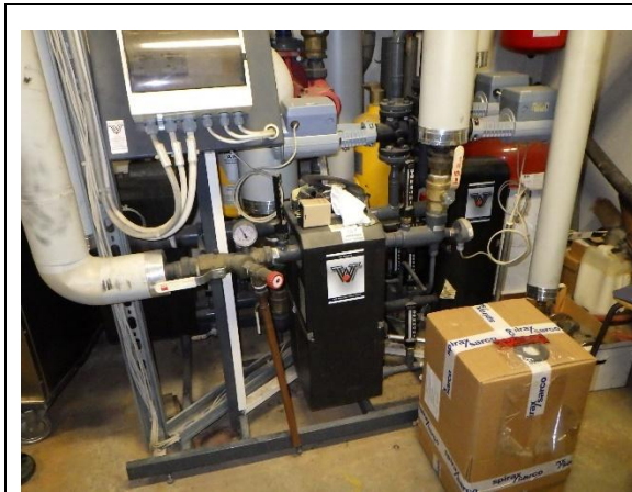
Kuva 112. Lämmönjakokeskus
