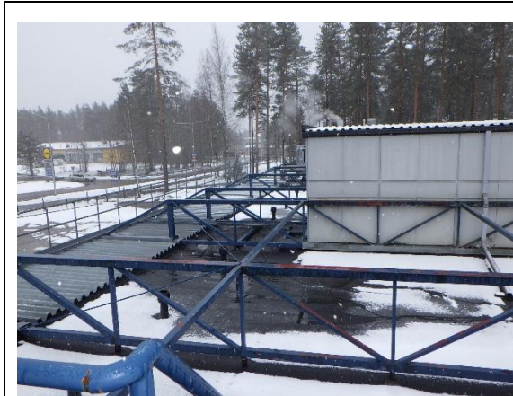
Kuva 36. Vesikaton alemmaa tasoa
