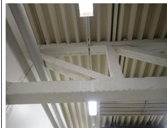
Kuva 100. Kylmiön eristetty ristikko
