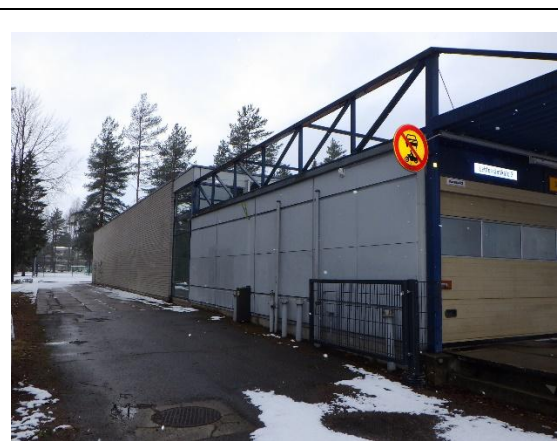
Kuva 27. Julkisivua vasemmalla sivulla
