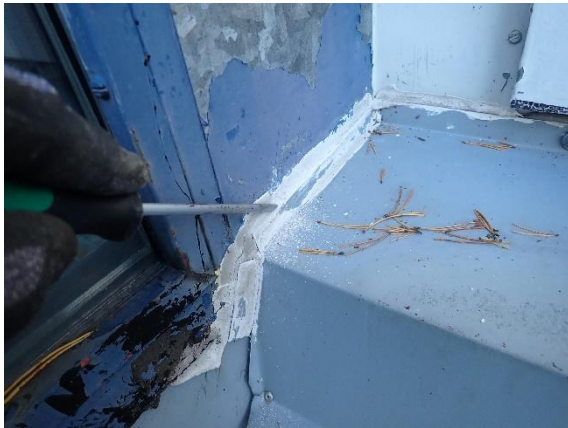
Kuva 48. Vesikattopellitysten kittauksia
