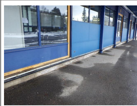
Kuva 10. Rakennuksen vierustaa kadun puolella
