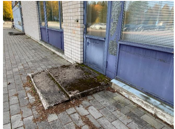
Kuva 73. Vesipeltien kaltevuus on loiva
