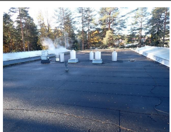
Kuva 39. Vesikaton ylempää tasoa
