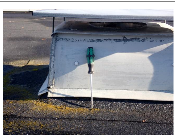
Kuva 41. Matala ylösnosto vesikatolla
