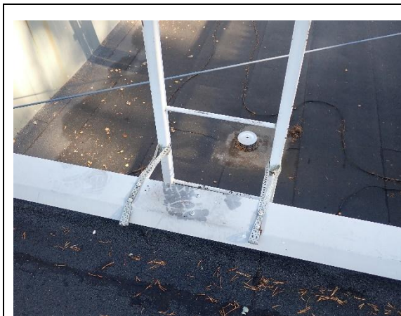
Kuva 40. Kattotikkaan kiinnityksessä korjaus
