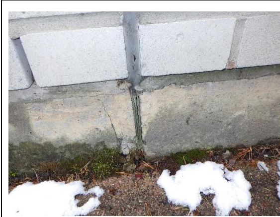
Kuva 12. Liikuntasäuma sokkelissa
