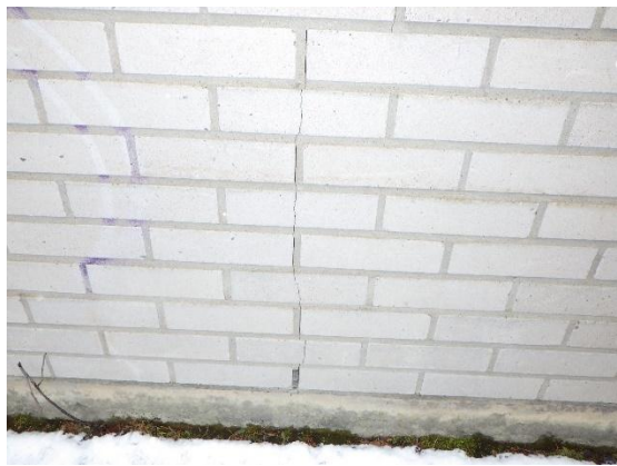
Kuva 30. Halkeama tiiliverhouksessa
