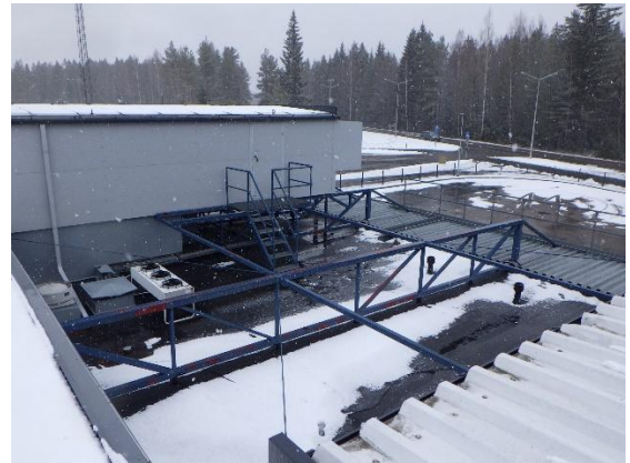
Kuva 37. Vesikaton alemmaa tasoa
