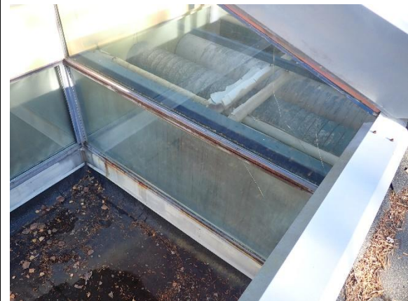
Kuva 75. Käytävän päätyikkuna rakenne ruokalan päässä rakennusta
