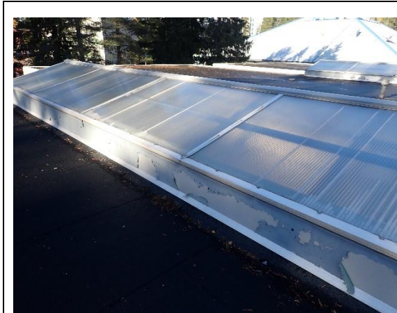
Kuva 38. Vesikaton käytävän valokate
