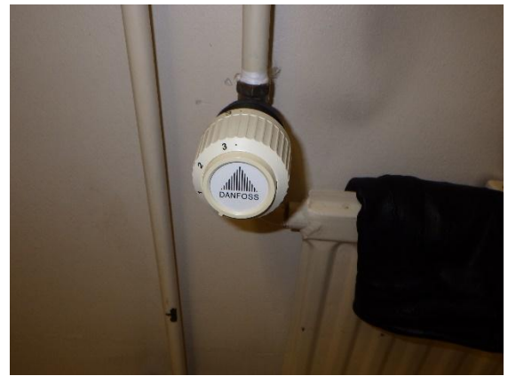
Kuva 115. Termostaattiventtiili
