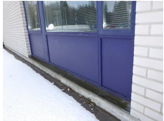
Kuva 67. Vesipeltien kaltevuus on loiva
