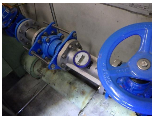
Kuva 118. Vesimittari
