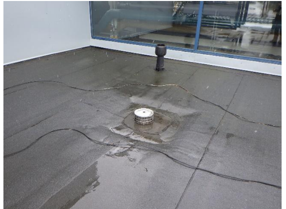
Kuva 45. Vesikatolla vedenpoistojärjestelmää
