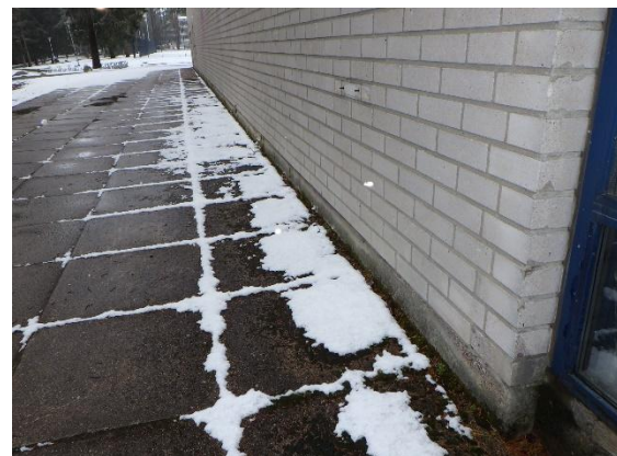
Kuva 6. Rakennuksen vierustaa vasemmalla seinustalla
