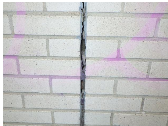
Kuva 31. Liikuntasauma on ikääntynyt ja avoin
