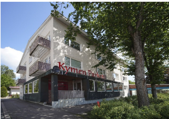
Kuva 79. Nykyinen Torvitien ja Kallantien kulmaus. Julkisivurapaukseen on tehty elementtijakoa osoittava viivoitus, kuten 1950-luvulla oli tapana. Kupari verhoukset on säilytetty Kuten myös sisäänkäynnin puupaneelikatto, joka on ollut 1960-luvun arkkitehtuurille tunnusomaista. (7/2025)
