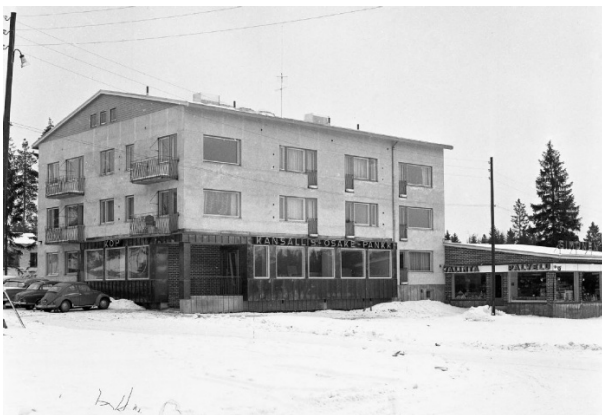
Kuva 78. Kansallis-Osake-Pankin uusi Torvitien konttori Torvitien ja Kallantien kulmauksessa. Rakennus valmistui vuonna 1961 ja konttori arvattiin maaliskuussa vuonna 1962. Oikealla samassa rakennuksessa toiminut elintarvikemyymälä T. Simonen. Myymälä avattiin joulukuussa vuonna 1961. Kuvan asuntojen ikkunan ulkopuutteet ovat tummat ja sisäpuolelta vaaleat, pankin konttorin ikkunapuutteet ovat vaaleat. Pankin ulko-ovi on ollut hieno puulasi-ovi. Kuva Poikilo-museot, kuvaaja Eero Suikki vuonna 1962.
