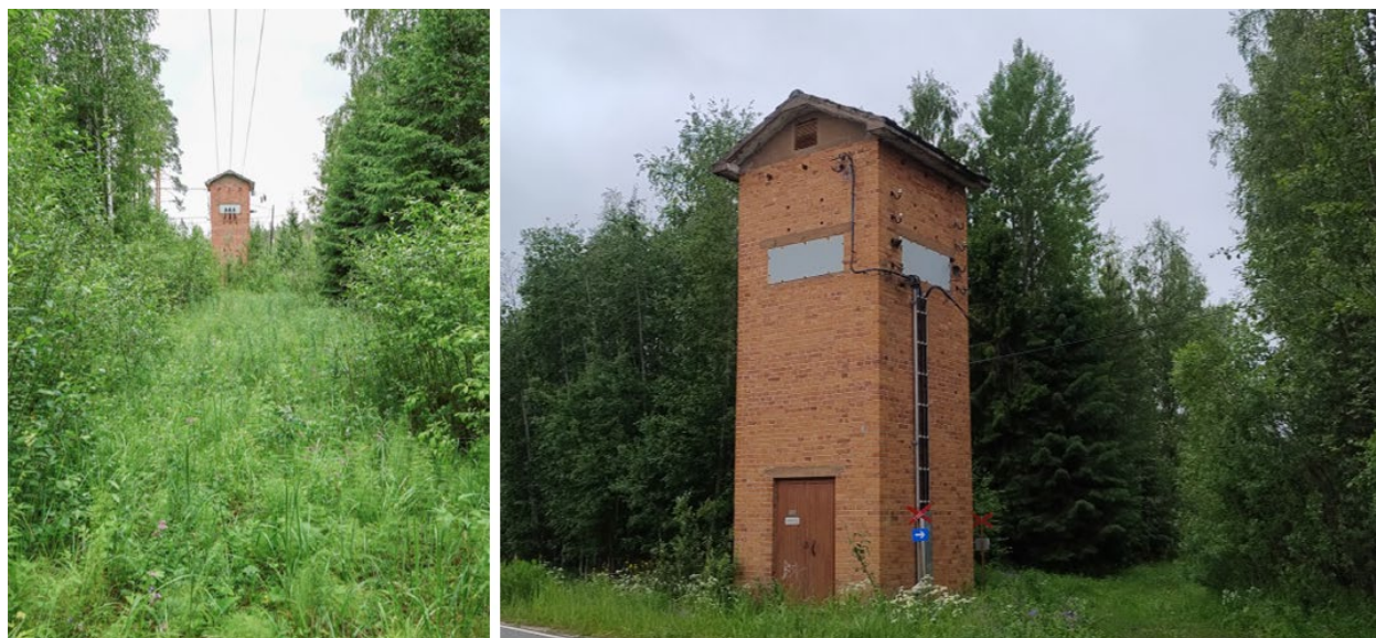
Kuva 10. Vasen kuva on ote vuoden 2019 Kullasvaara-Tykkimäki osayleiskaavan luontoselvityksestä, jolloin Häkämäentien varrella olevalta muuntajarakennukselta lähti sähköjohdot lounaaseen. Linja-aukolla kasvaa purtojuurta. Oikeanpuolisessa kuvassa sama muuntajarakennus kuvattuna kesällä 2025, jolloin sähkölinjat on purettu. Muuntajarakennus on potentiaalinen lepakkojen päivehtimispaikka, mutta asiaa ei ole todennettu rakennuksen sisätarkastuksiin.
