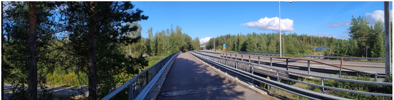
Kuva 2. Valtatie 15 ylittävät Karjalankadun ajoneuvoliikenteen ja kevyen liikenteen sillat. Nykytilanteessa Karjalankatu on maantie, mutta asemakaavan muutoksessa myötä katu siltoineen esitetään katualueena. Kuvaussuunta itään kohti Tykkimäkeä.
