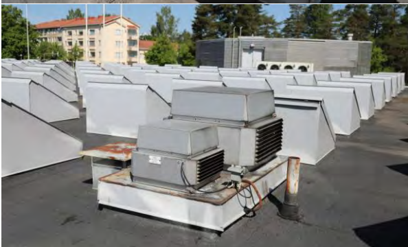
Kuva 128. Kuvia kirjaston katolta, ikkunoista ja asennuksista.
