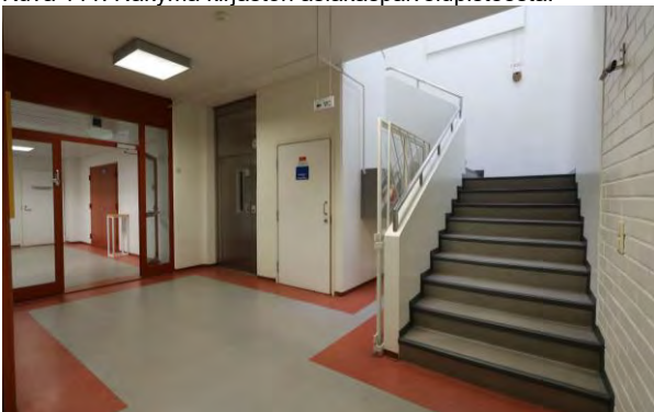
Kuva 112. Näkymä kellarikerroksen aulasta.
