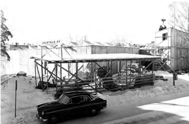
Kuva 48. Kirjaston rakennustyöt etenevät keväällä 1971.
