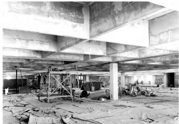
Kuva 49. Kirjaston sisätila ja vesikaton betonipalkit.
