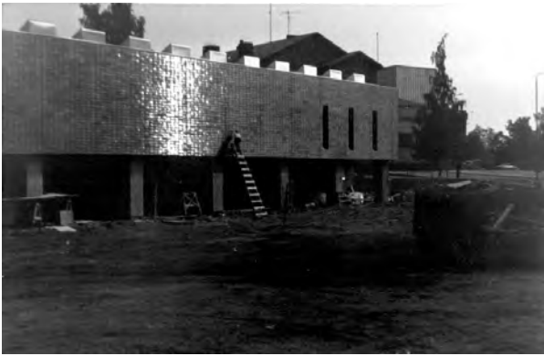
Kuva 50. Kirjaston julkisivuvuon laatoituksen saumaustyö 1971.
