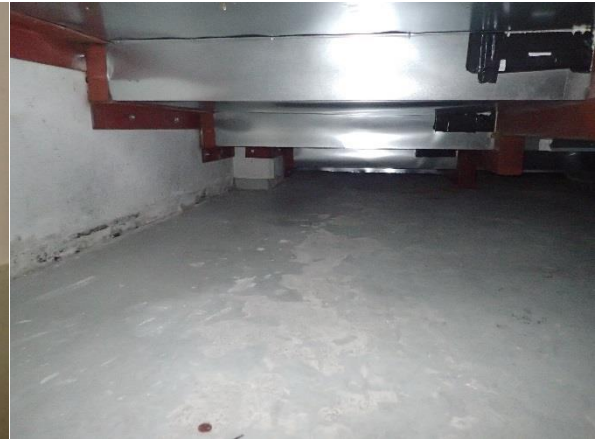
8.7 Vanhan autotallin alkuperäinen lattiapinta korokkeen alla. Maalipinta on kulunut. Alapuolisesta tilasta suora ilmayhteys yläpuoliseen huonetilaan
