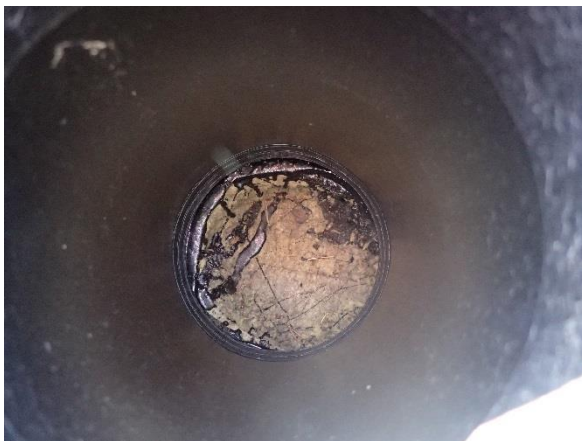
12.3 Yläpohjan alipainetuuletusputki, jossa nä- kyissä lämmöneriste
