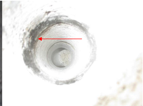
8.2 Rakenneavaus RA.03-AP (entinen autotallin lattia). Nuolella osoitettu vedeneriste
