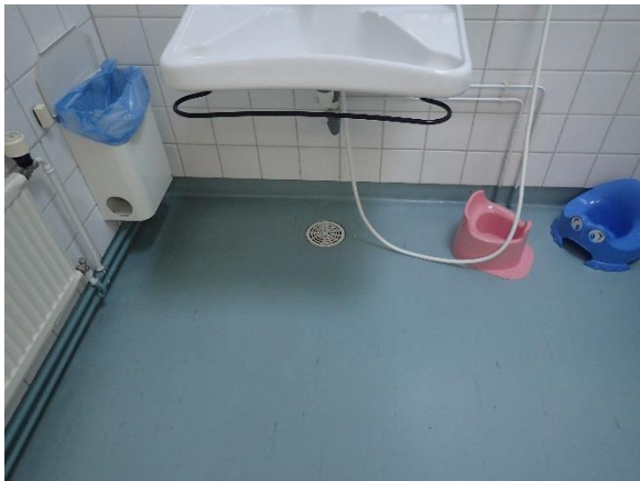
10.5 Inva-wc:n ja siivouskomeron lattiat ovat muovimattopintaisia
