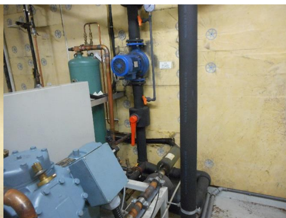
13.54 Jäähdytysjärjestelmän pumppuryhmä.
