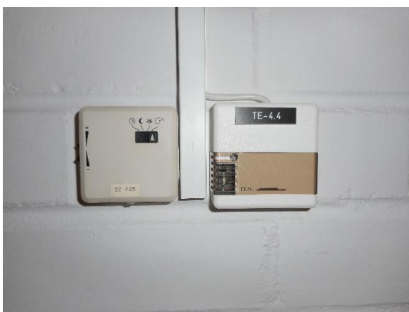
13.65 Huonesäädin ja lämpötila-anturi.
