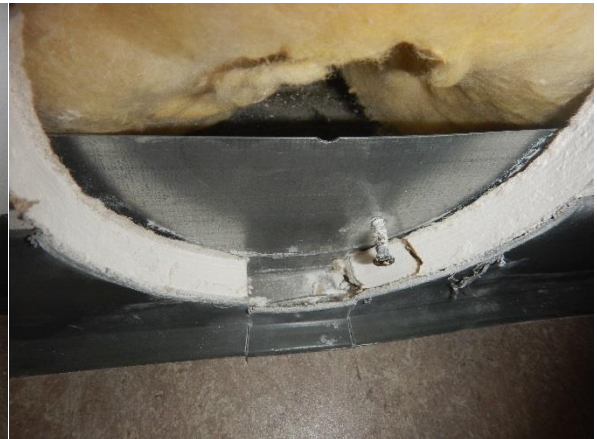
11.2 Rakenneavaus RA.06-VS, jossa näkyvissä metalliranka ja mineraalivillaeristys
