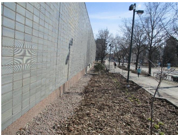
6.5 Rakennuksen länsireuna kaataa loivasti rakennukseen päin tai on lähes tasainen. Sorastuksen alla on multaa
