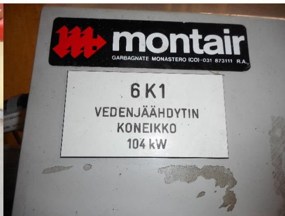
13.56 Vedenjäähdytyskoneen laitetunnus. Koneikko on 1990-luvun alusta.
