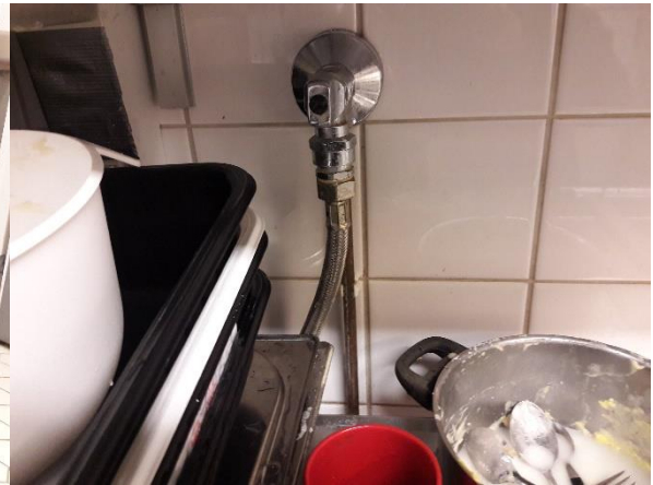
13.25 Keittiön vedenotto tapahtuu pesukoneventtiilin kautta
