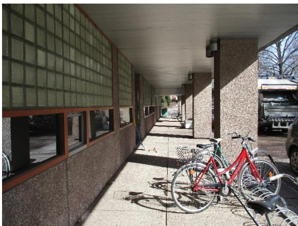
6.9 Rakennuksen eteläpuoli on kauttaaltaan kivitetty ja asfaltoitu
