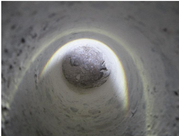
8.1 Rakenneavaus RA.01-AP, jossa näkyvissä muovitus
