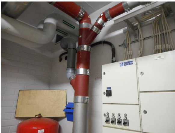
13.18 Uusittuja muovi- ja valurautaisia viemäri-osuuksia pohjakerroksen teknisessä tilassa.
