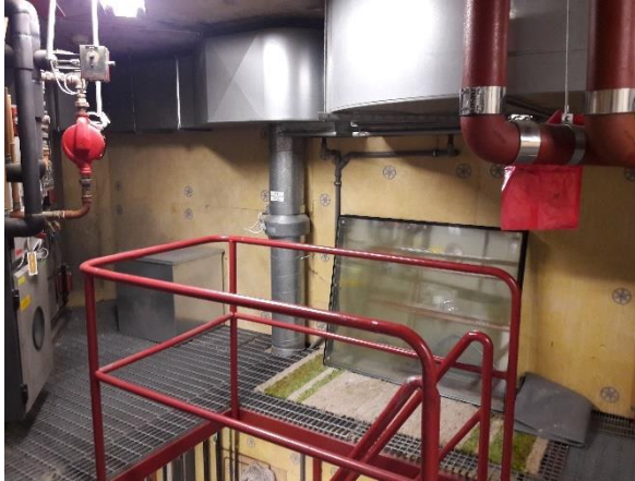
13.48 Yläpohjassa sijaitsevan IV-konehuoneen seinät on verhottu pinnoitetulla mineraalivillalla.
