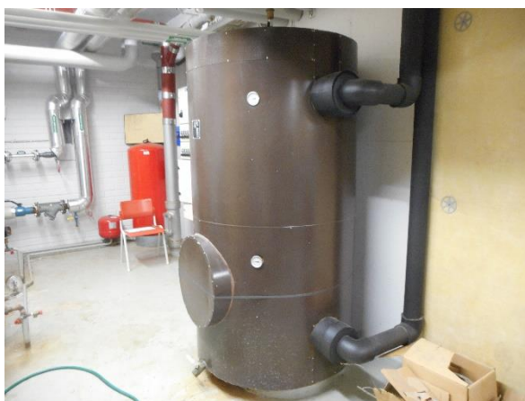
13.53 Jäähdytysjärjestelmän vesivaraaja.
