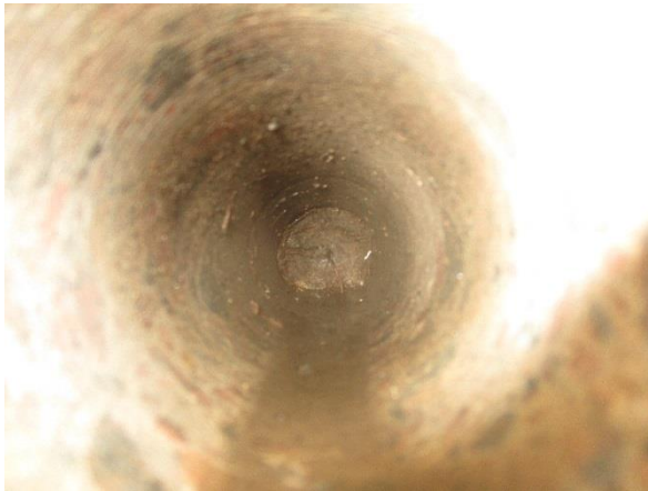
7.1 RA.02-US, rakenneavauksessa näkyvissä so- raa ja multaa.
