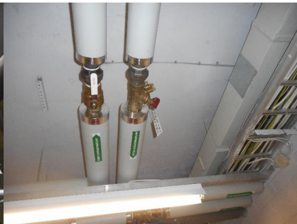
13.15 Lämmitysputket on eristetty ja päät on varustettu peiteheloin.
