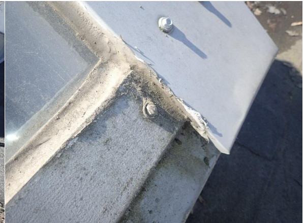
12.6 Kattoikkunan liittymiä paikkakorjattu elastisella massalla
