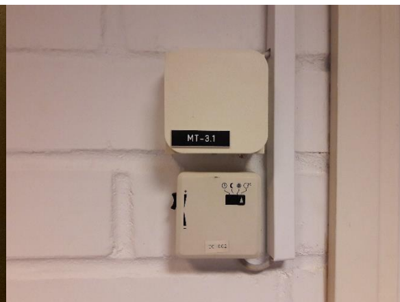
13.68 Kosteusanturi ja lämpötilasäädin.
