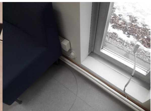
13.13 Kirjastosalin konvektorit on varustettu irtotanturein.
