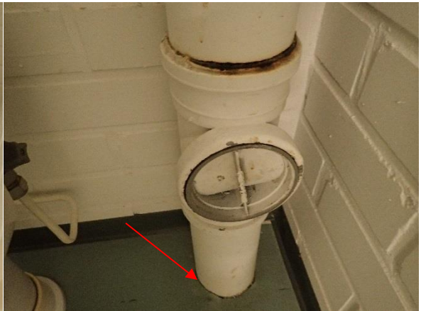
8.13 Märkätilan muovimaton liittymän läpivienti on epätiivis
