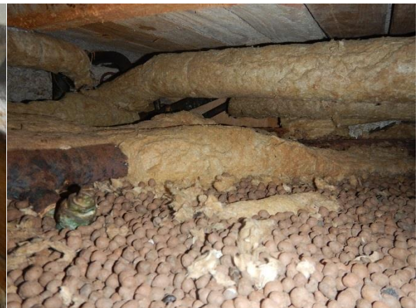
8.7 Vanhan autotallin alkuperäinen lattiapinta korokkeen alla. Maalipinta on kulunut. Alapuolisesta tilasta suora ilmayhteys yläpuoliseen huonetilaan
