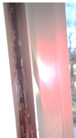
9.7 Ikkunan pellitys sisäpuolelta. Tilkkeenä tummunutta mineraalivillaa
