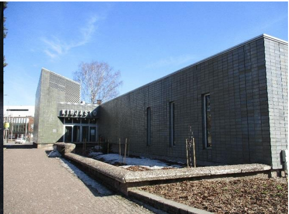
6.4 Rakennuksen pohjoispuolen pääsisäänkäynnin molemmin puolin käytöstä poistetut vesialtaat, jotka on täytetty istutuksilla
