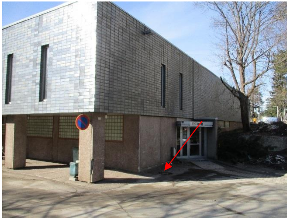
6.7 Nuolella osoitettuna sadevesikaivo. Kaadot rakennuksesta kaivon päin loivia. Kaivon edustalla entisen autotallin oviaukko
