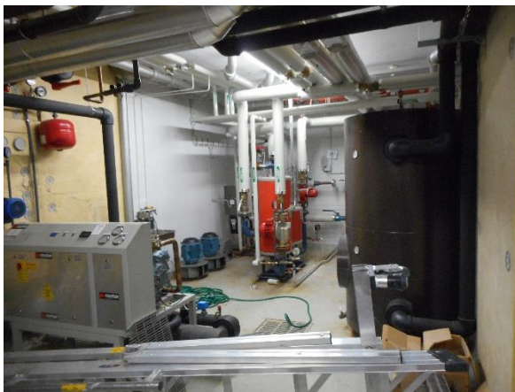
13.5 Lämmitysputkia lämmönjakohuoneessa.
