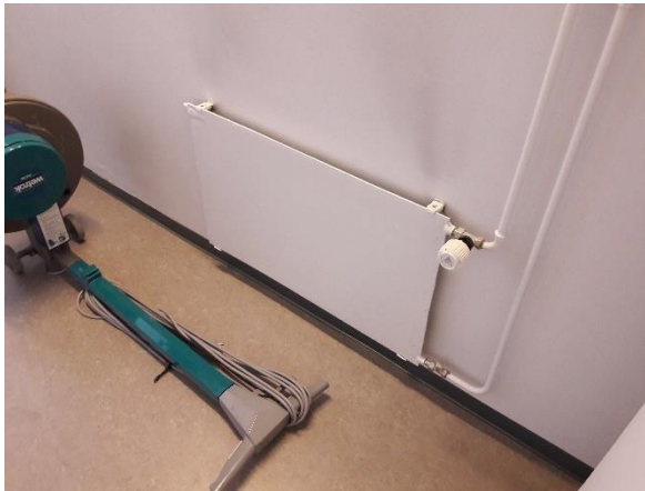
13.8 Sileäpintainen patteri termostaatilla varustettuna.
