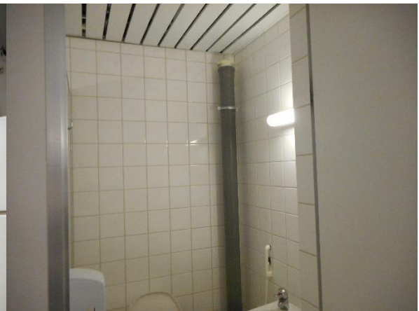
13.19 Osa rakennuksen WC-tiloista oli varustettu alipaineventtiilein.
