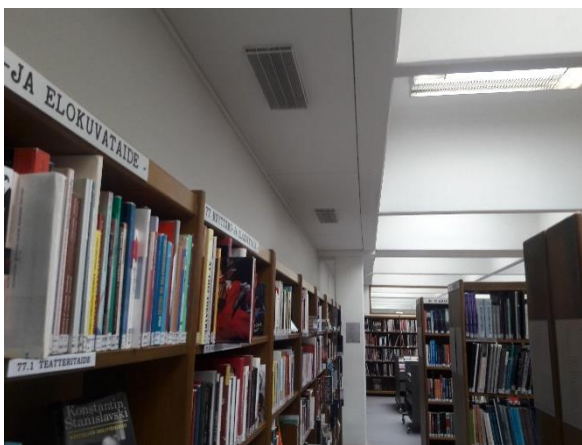
13.42 Poistoilmahajottajia kirjastosalin palkeissa.
