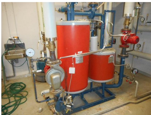
13.1 IV- ja patteriverkoston lämmönsiirtimet. Lämmönsiirtimet ovat vuodelta 1978.
