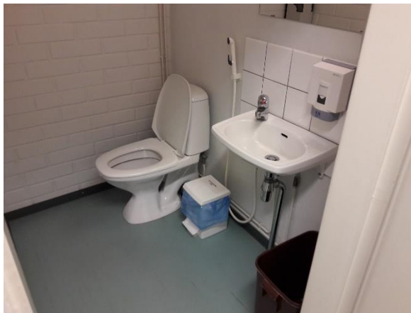
13.22 WC-tila pohjakerroksessa. Vesikalusteet on uusittu arviolta peruskorjauksen yhteydessä 1990-luvulla.
