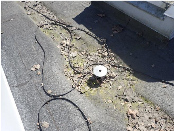
12.5 Lämmityskaapelit ja lehtiä kattokaivon ympärillä
