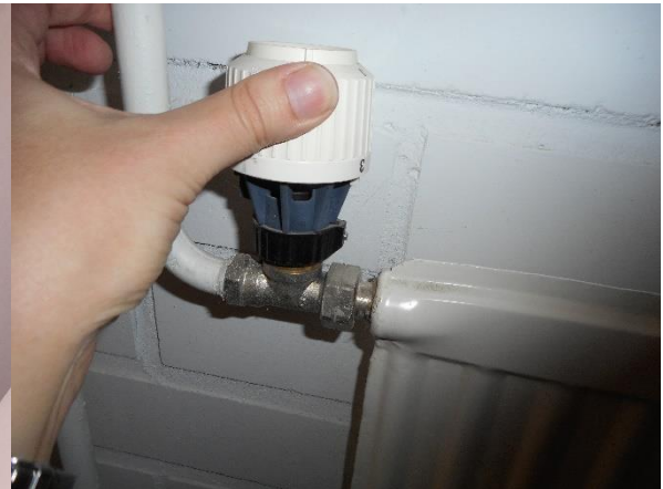
13.9 Auditorion takana olevalla käytävällä olevan patterin termostaatti oli löysällä.
