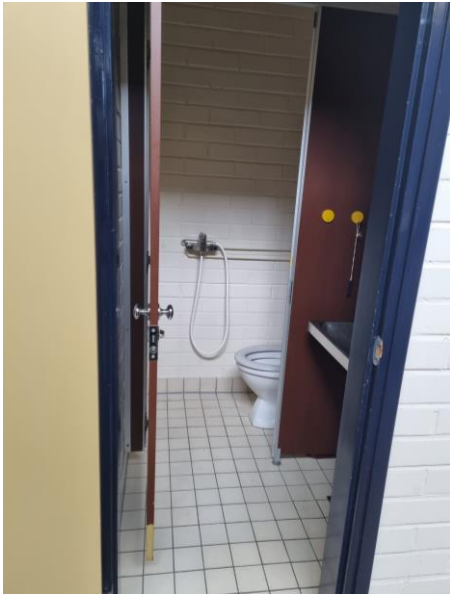
Alla: Kuva 19: WC-tila 16. Alkuperäiset ovi ja seinäke.
