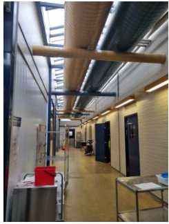
Yllä vasemmalla: Kuva 1: Näkymä käytävältä ruokasaleja kohti. Käytävään tulee luonnonvalo kattoikkunan kautta. IV-kanavat ovat värikkäästi maalattuja.
