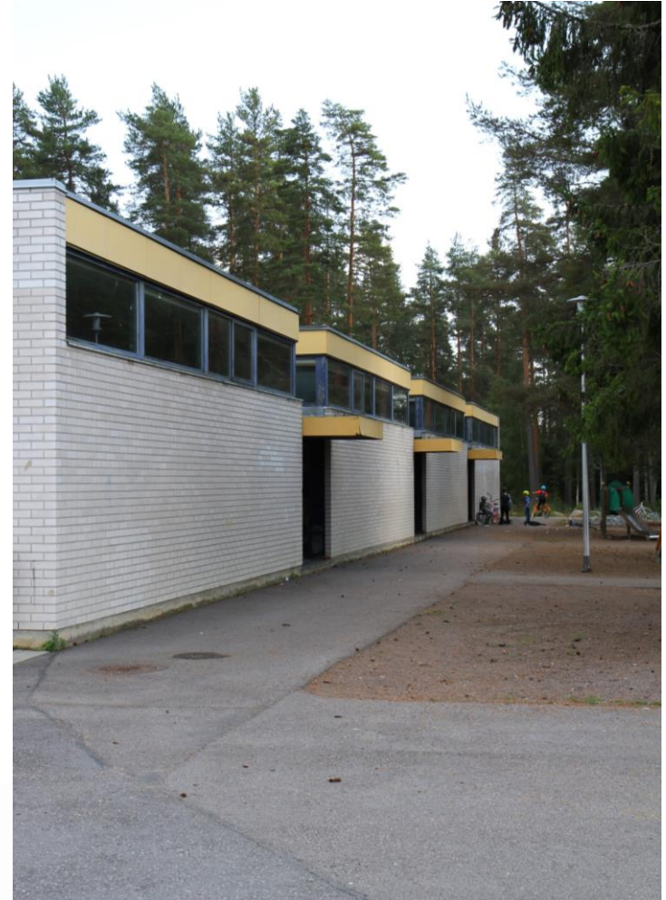
Alla vasemmalla: Julkisivu etelään. Keskuskeittiön teräksiset kattopalkit kannattelevat lastauslaiturien katosta ja ovat olennainen osa rakennuksen julkisivua. Porttien takaa alkaa pihalaatoitus, joka näkyy myös alkuperäisessä pihapiirustuksessa. Kuvaaja: Lumi Alastalo
