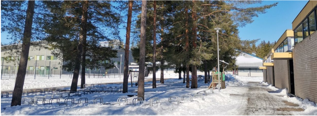
Kuva 7. Keskuskeittiön länsiosassa sijaitsee koulun nykyinen ruokala, jonka edustalla on pihan keskiosan ainoa puustoinen alue. Ruokalaan on useampi lipallinen julkisivua rytmittävä sisäänkäynti. Ikkunat on sijoitettu lähelle kattoa yhtenäiseksi nauhaksi.
