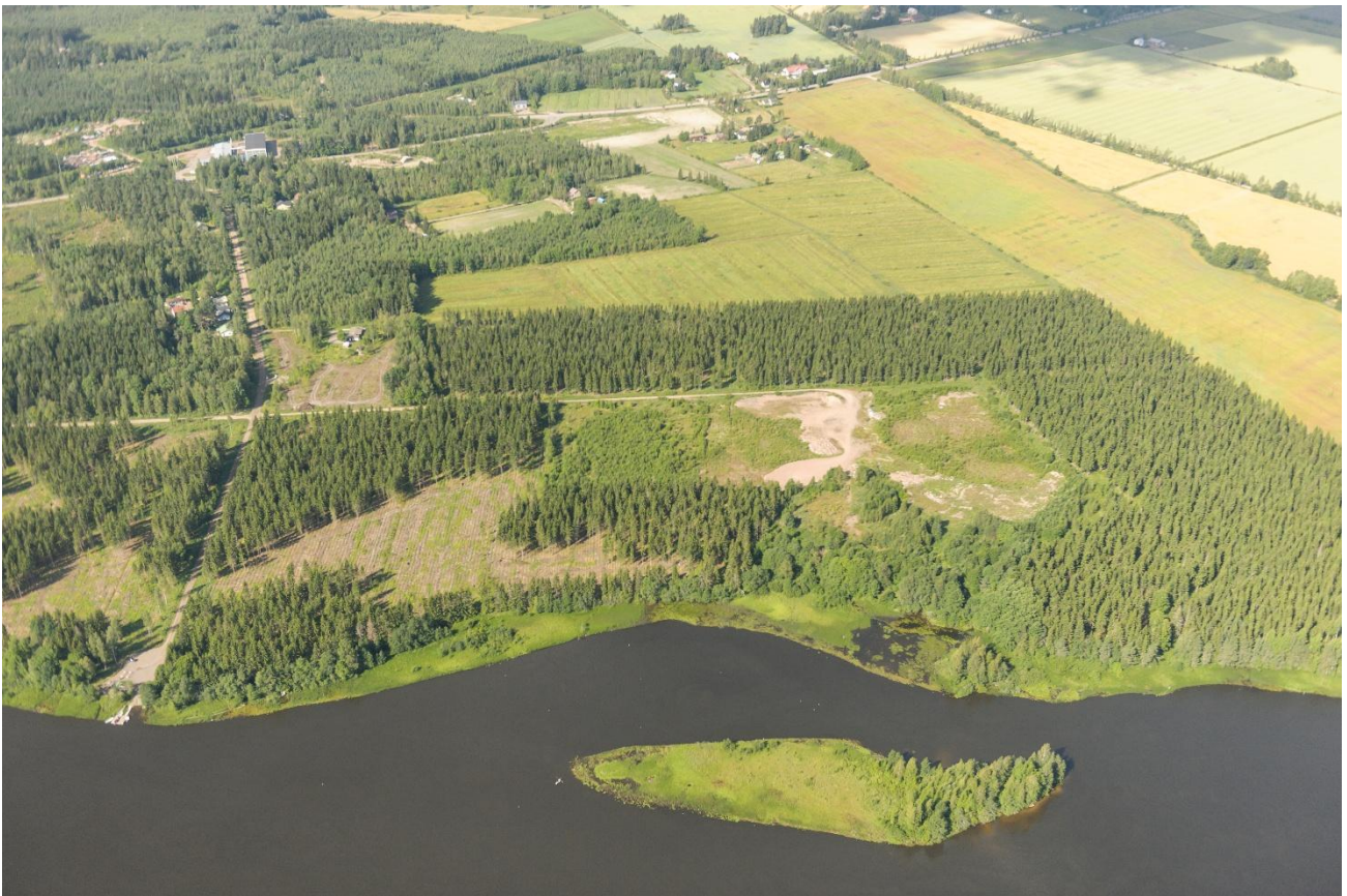
Kuva 18. Ilmakuva suunnittelualan eteläosaan idän suunnalta 1.8.2015. Kuva Lentokuva Vallas Oy, Hannu Vallas. Kuvan vasemmassa laidassa olevan Lossitien eteläpuolista aluetta ei ole vielä valmisteltu rakentamiseen.
