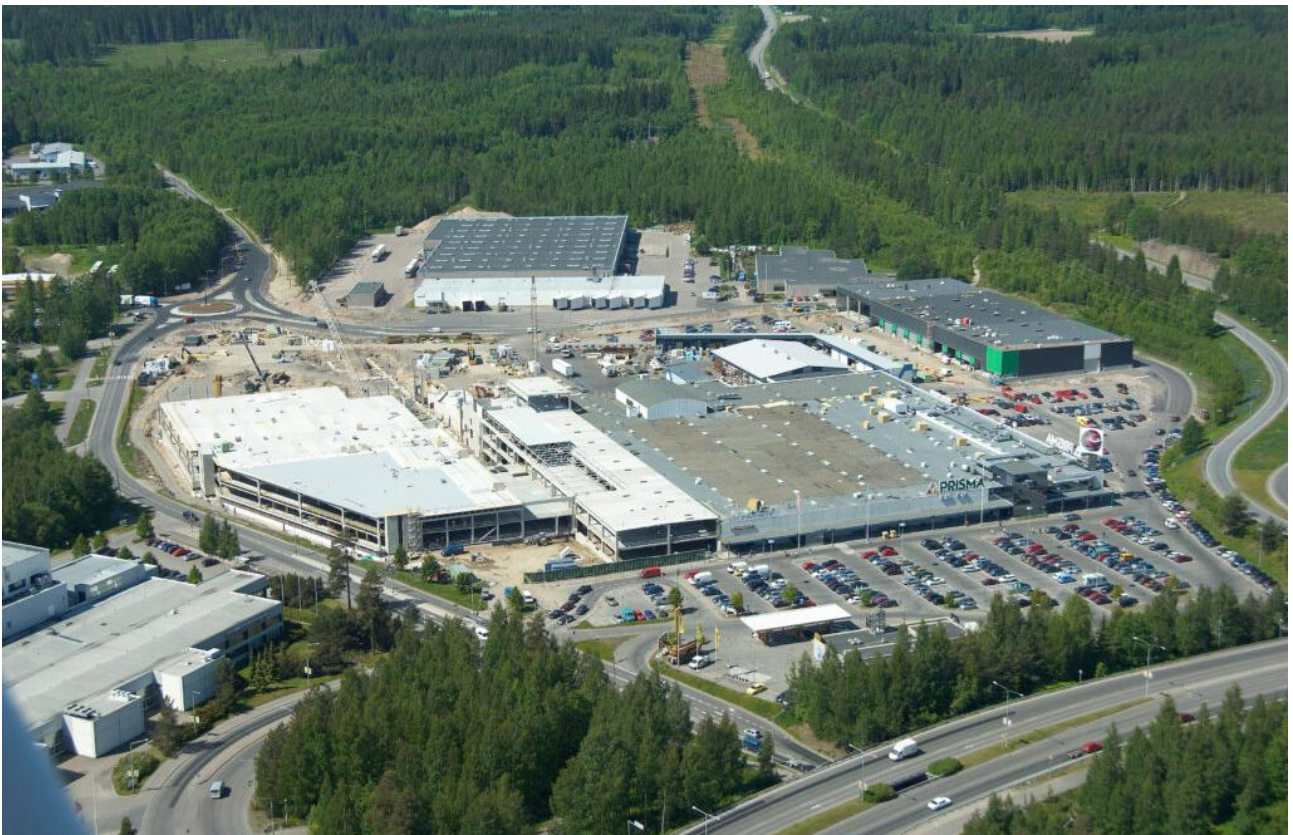
Kuva 19. Vuoden 2010 kesällä otetun kuvan laidoilla parkkihalli ja Rakentajan noutomymälä ovat rakenteilla. Kauppakeskuksen takosaan on vielä tulossa runsaasti lisätilaa päivittäistavaroille kuten remontoinnin ja puutarhan tuotteille. Teksti- ja kuvalähde KSO.
