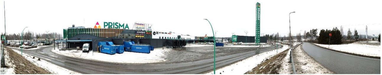
Kuva 20. Näkymä Prismakeskukselle pohjoisesta valtatie 6:n rampilta. Hypermarketti on kuvassa vasemmalla ja rakentajan noutopiha oikealla. Kuvassa oleva hypermarketin huoltopiha ja sen rakenteet ovat valmistuneet vuonna 2024.
