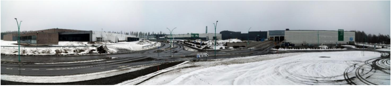
Kuva 6. Näkymä suunnittelualueelle idästä Tommolankadulta helmikuussa 2025. Kuvan vasemmassa laidassa on Plus Logisticin hallirakennus, keskellä KSO:n rakentajan noutopiha ja puutarhamyymälä. Kuvan oikeassa reunassa on Prismakeskuksen paikoitushalli.
