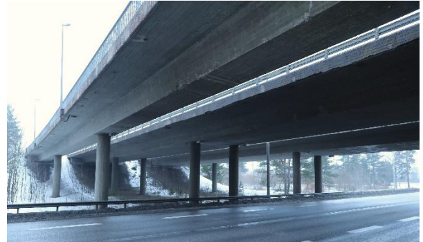
Kuva 31. Valtatie 6:n ylittävät Kuusaantien sillat (3 kpl).
