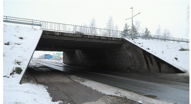
Kuva 30. Tommolankadun Kuusaantien alittava tunneli.
