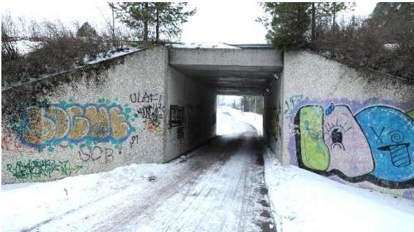
Kuva 28. Kuvassa Tommolankaaren kadun alittava tunneli.
