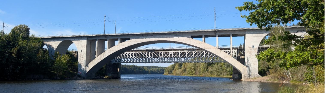
Kuva 6-11. Korian sillat Kymijoen pohjoisrannalta nähtynä. Kuvaussuunta on luoteeseen. Etualalla vuodelta 1925 oleva silta, taustalla maantiesilta vuodelta 1985 ja vuonna 1870 valmistunut nykyään jalankulun ja pyöräilyn käytössä oleva rautasilta. Kuva: Antthesis Finland Oy, 11.9.2025.
