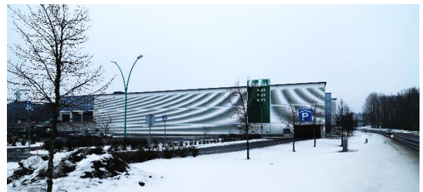
Kuva 23. Prismakeskuksen autopaikotushalli etelästä.
