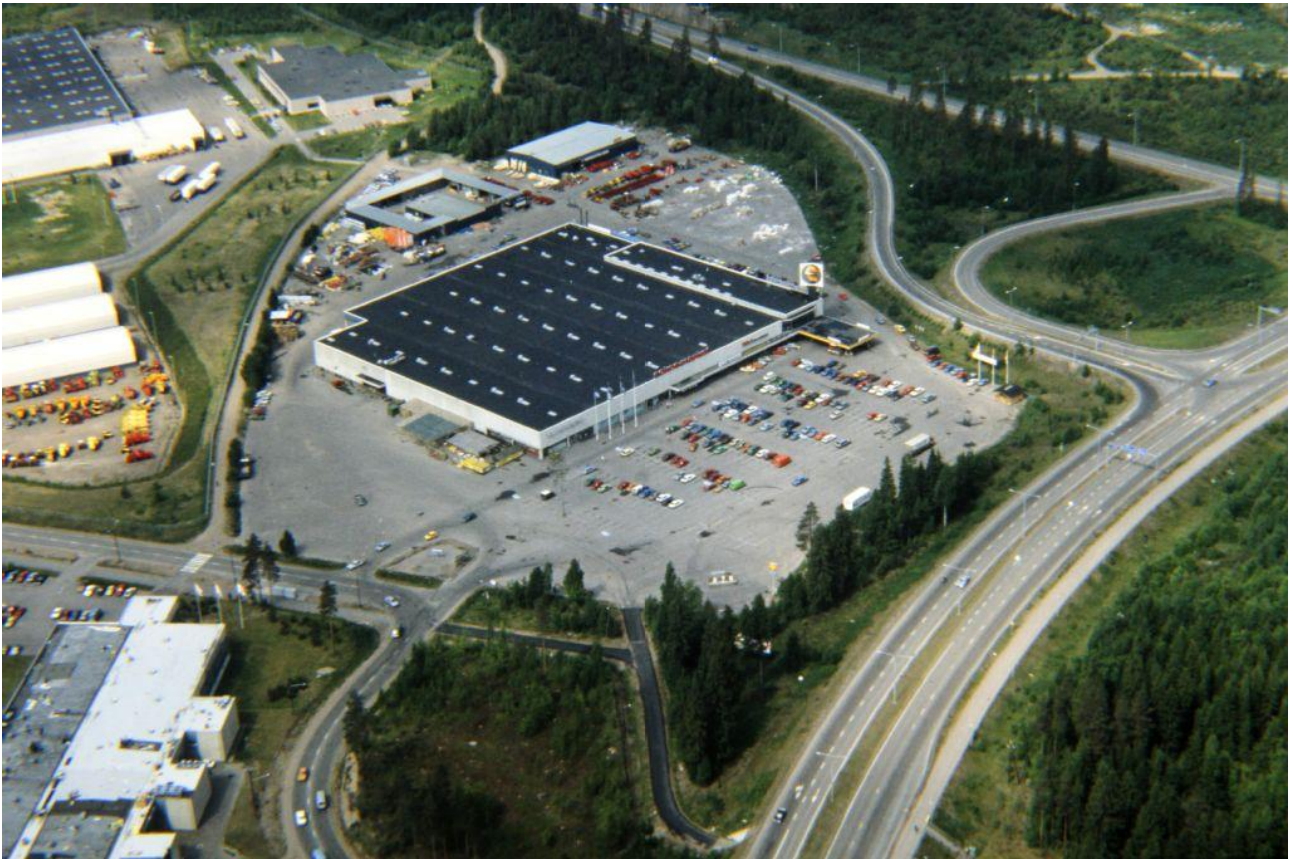
Kuva 15. Ilmakuva Sokos-Marketista ja sen lähialueesta vuodelta 1985. Tommolankatua ei ole vielä ulotettu Kuusaantien itäpuolelle. Kuvan vasemmassa reunassa konemyynti. Sokos-Marketin vieressä sijaitsivat rakentajan noutopiha ja käytettyjen autojen myyntirakennus. Kuvälähde Poikilo-museot. Kuvaaja Raimo Sävilä.
