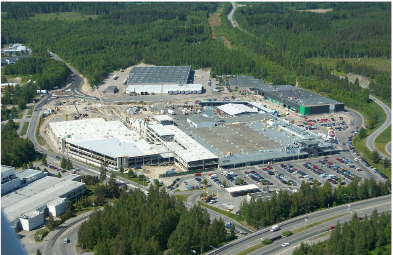
Kuva 16. Vuoden 2010 kesällä otetun kuvan laidoilla parkkihalli ja Rakentajan noutomyymälä ovat rakenteilla. Kauppakeskuksen takaosaan on vielä tulossa runsaasti lisätilaa päivittäistavaroille kuten remontoinnin ja puutarhan tuotteille. Teksti- ja kuvälähde KSO.
