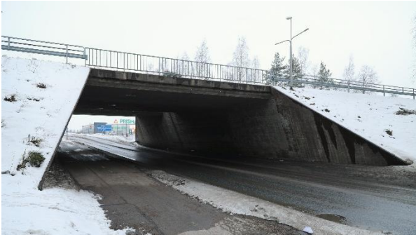
Kuva 27. Tommolankadun Kuusaantien alittava tunneli.
