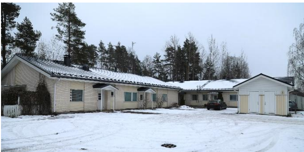
Kuva 8. Näkymä korttelissa 8259 olevista rakennuksista.
