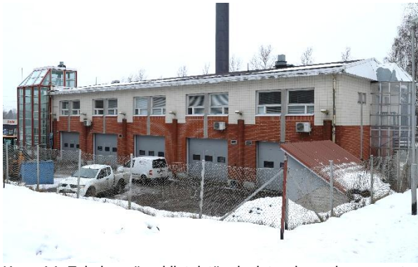
Kuva 14. Eskolanmäen kiinteistöpalvelut, rakennuksen muutos ja korotus on tehty vuonna 1989.
