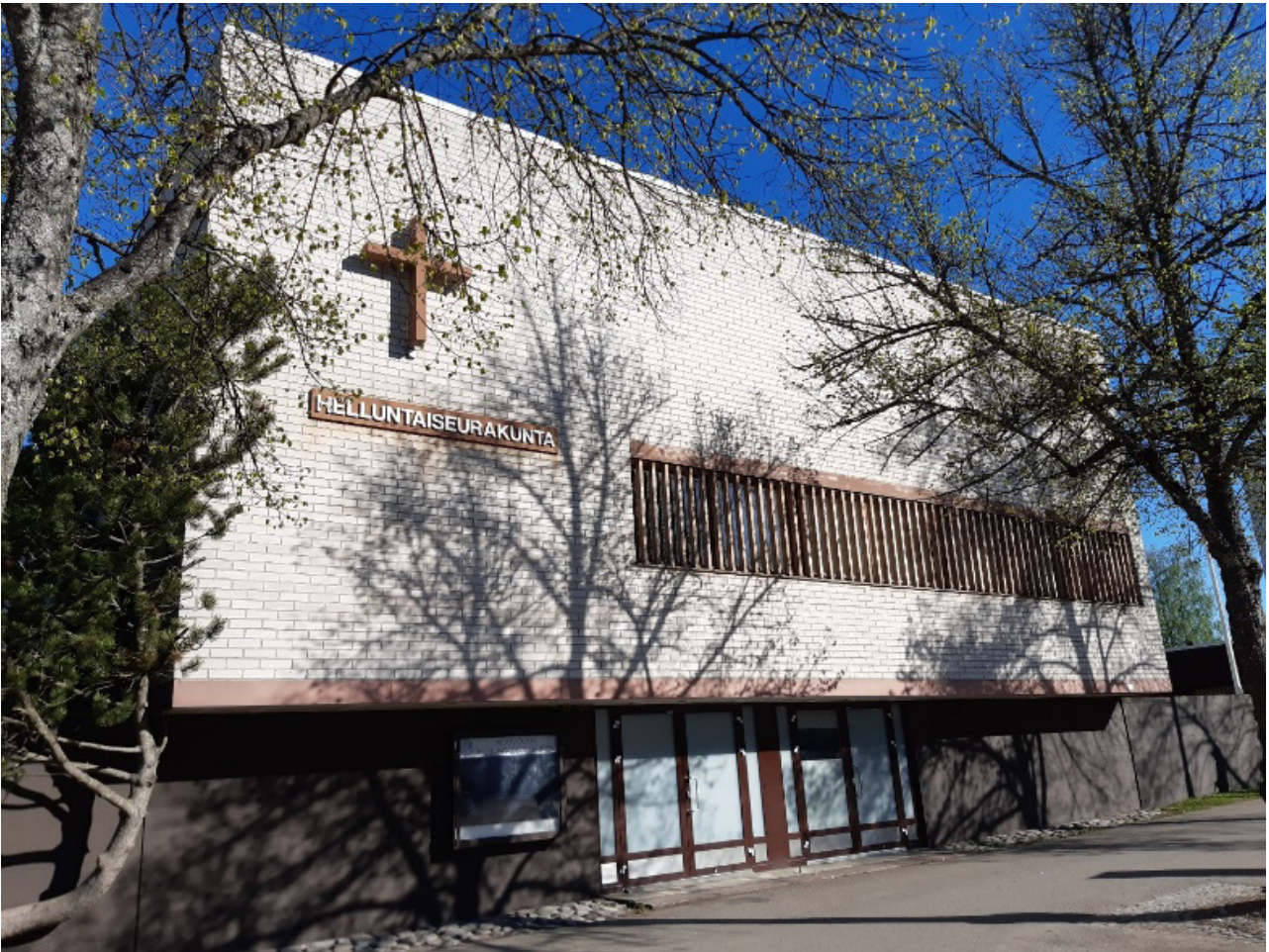
1. Beatanian kadun puolen julkisivu kuvattuna keväällä 2024 (Kuva: Kaisa Niilo-Rämä)
