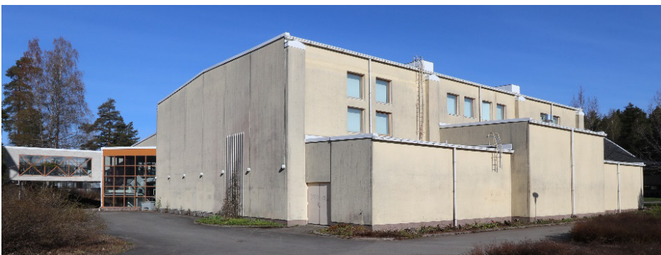
22. Lyseon liikuntahallin itä- ja eteläpuolen julkisivut keväällä 2024. (Kuvaaja Hannu Purho)
