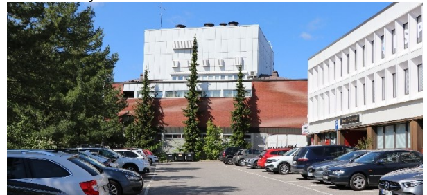
Kuva 10. Näkymä teatterille idän suunnalta.
