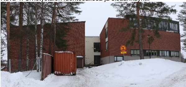
Kuva 5. Näkymä lännestä rakennuksen huoltosisäänkäynnille.
