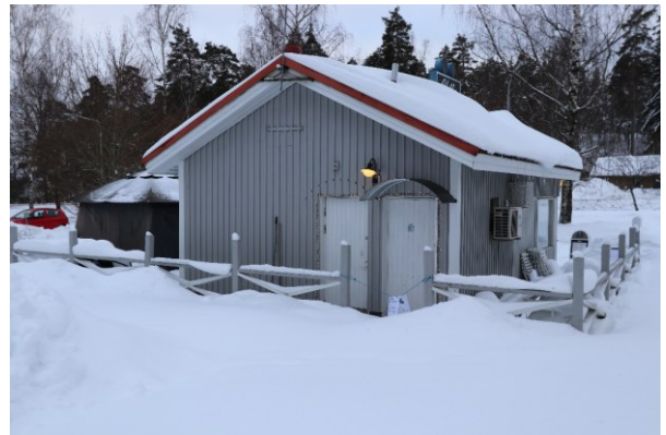
Kuva 14. Kioskirakennus saunan suunnasta.
