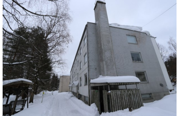
Kuva 12. Pohjoisimman rakennuksen pääty.
