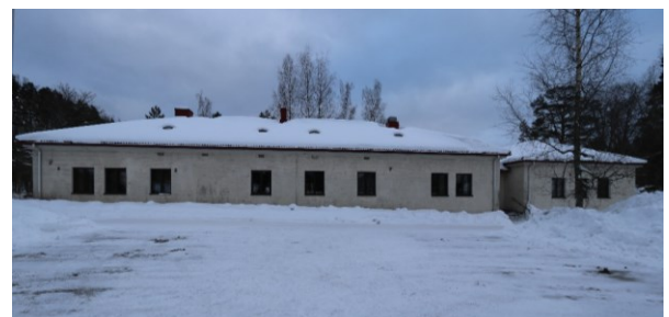
Kuva 18. Saunarakennus pohjoisesta Messutien suunnasta.
