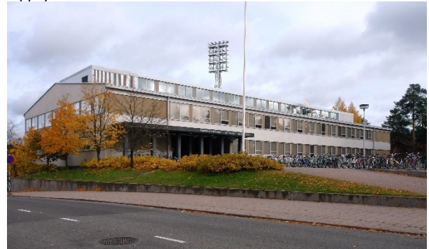
Kuva 12. Kouvolan Yhteiskoulun rakennus Sumulaaksonkadun ja Salpausselänkadun risteyksestä. Kuva Rurik Wasastjerna 2012.
