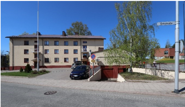
Kuva 72. As Oy Salpausselänkatu 37 Oikokadun suunnalta tarkasteltuna.
