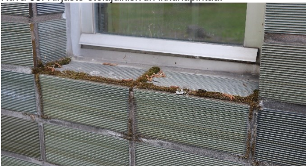
Kuva 64. Yksityiskohta julkisivu- ja ikkunamateriaaleista.
