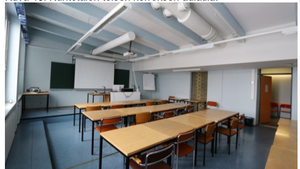
Kuva 47. Näkymä kuntotalon luokkatiloista.
