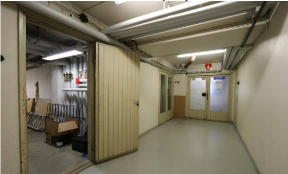
Kuva 40. Kuntotalon kellarikerroksen käytävätila.
