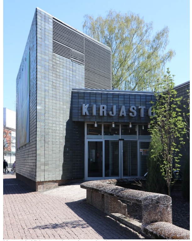
Kuva 76. Kirjaston sisäänkäynnin yhteydessä oleva tornimainen osa sisältää asiakkaiden wc-tilojen lisäksi rakennuksen IV-konehuoneen. Rakennusta kiertävät pesubetoniset kaiteet ovat alkuperäiset. Seinän vieressä olevat istutuslaatikot ja niiden istutukset on uusittu vuonna 2022.
