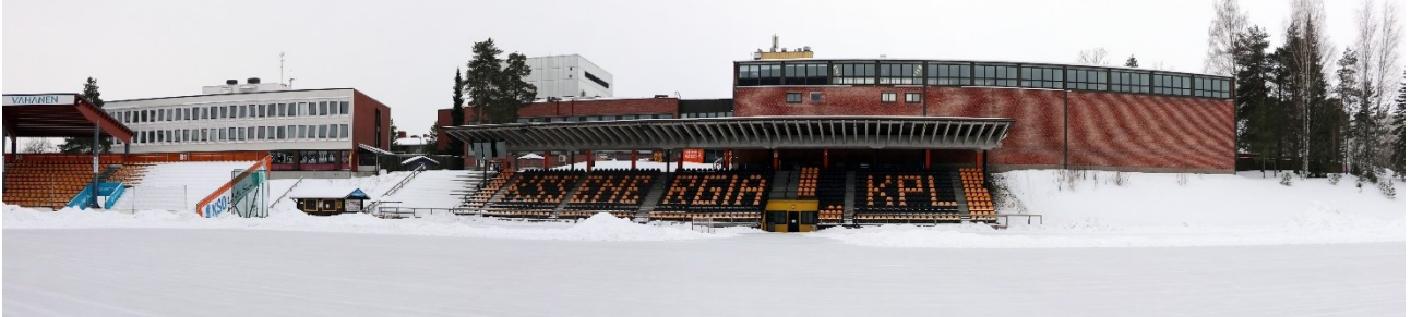
Kuva 5. Kouvolan teatteri- ja kuntotalo sekä katos pohjoisesta pesäpallokentän suunnalta tarkasteltuna. Lähde Kouvolan kaupunki.
