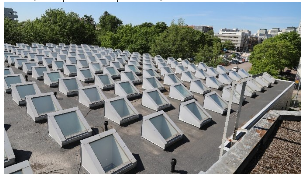
Kuva 68. Näkymä kirjaston katolta, jossa on 256 kattoikkunaa.
