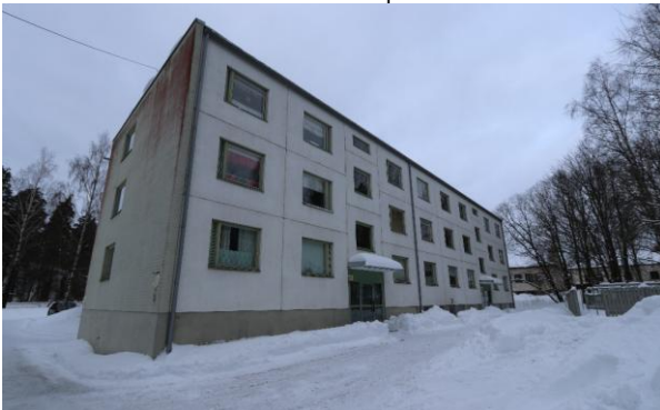
Kuva 10. Kerrostalo pihan puolelta tarkasteltuna, v.2024.
