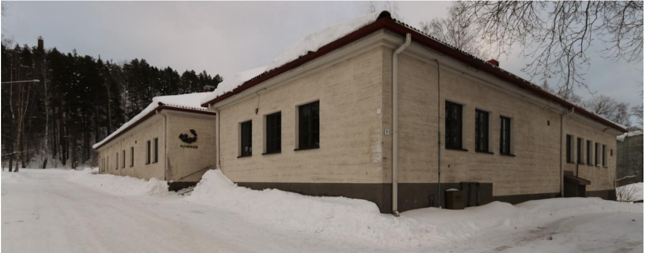
Kuva 22. Saunarakennus Messutien suunnalta talvella 2024. Pääsisäänkäynti on rakennusrunkojen liitoskohdassa.
