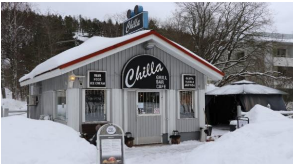
Kuva 16. Kioskirakennus Vuorilaaksontien suunnasta.
