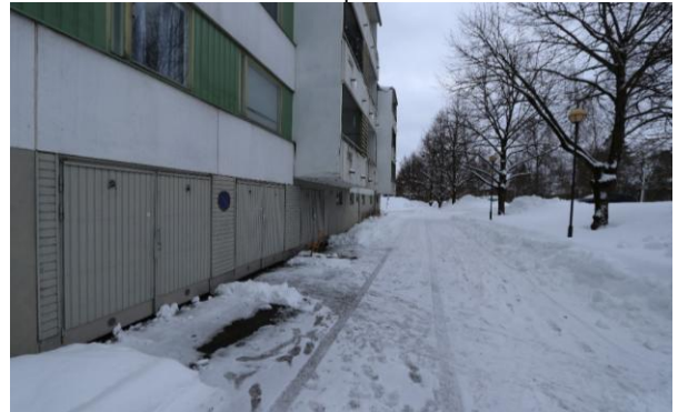
Kuva 11. Rakennusten maantasokerroksessa on autotalleja.
