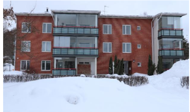
Kuva 33. As Oy Villiviini on valmistunut vuonna 2003.
