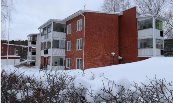
Kuva 32. As Oy Vanhaviini on valmistunut vuonna 1995.
