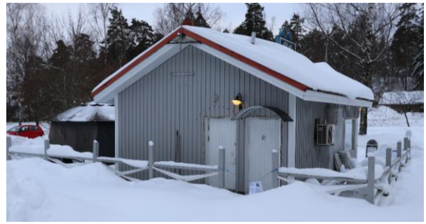
Kuva 17. Kioskirakennus saunan suunnasta vuonna 2024.
