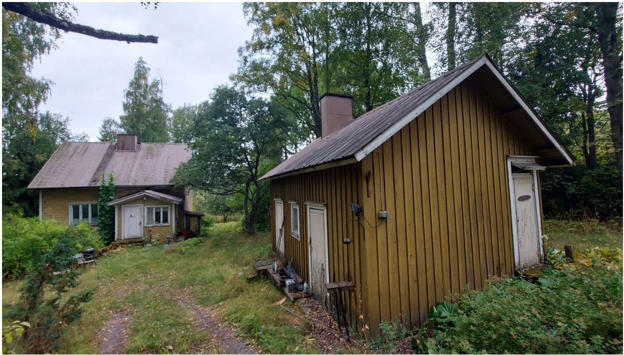
Kuva 13. Kaava-alueella oleva rakennuspaikka.
