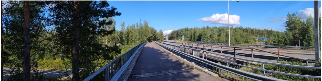
Kuva 2. Valtatien 15 ylittävät Karjalankadun ajoneuvoliikenteen ja kevyen liikenteen sillat. Nykytilanteessa Karjalankatu on maantie, mutta asemakaavan muutoksessa myötä katu siltoineen esitetään katualueena. Kuvaussuunta itään kohti Tykkimäkeä.
