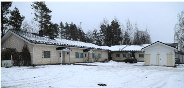
Kuva 8. Näkymä korttelissa 8259 olevista rakennuksista.
