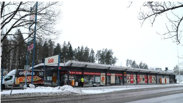
Kuva 15. Eskolanmäen liikerakennus pohjoisesta.
