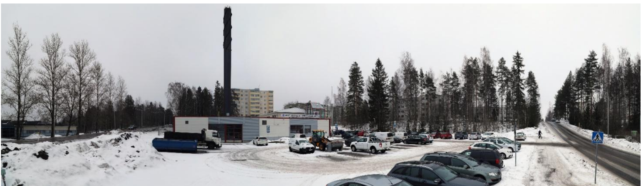
Kuva 2. Näkymä Sippolankadun ja Tasankotien risteysalueelta kohti itää. Etualalla oleva yleinen pysäköintialue on kiinteistön käytössä.
