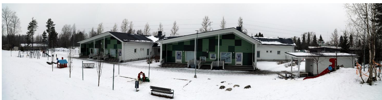
Kuva 7. Tasankotien varrelle on valmistunut päiväkotirakennus vuonna 2020. Näkymä päiväkodin piha-alueelle etelästä.
