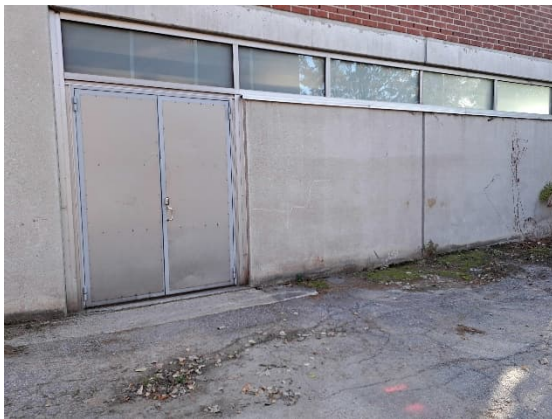
Kuva 54. Ulko-ovet ovat metallia.
