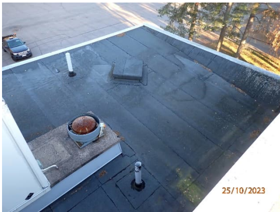
Kuva 76. Pienempi asuinkerroksen vesikatto.
