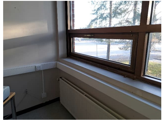
Kuva 51. Osa ikkunoista on avattavia tuuletusikkunoita.
