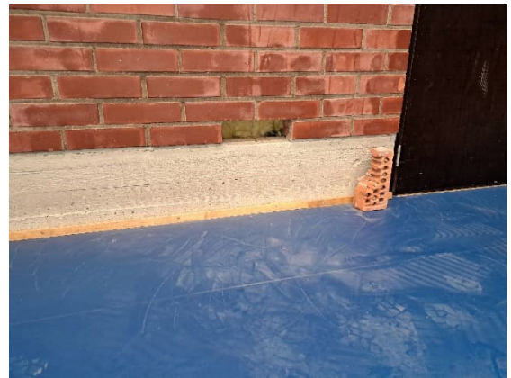
Kuva 35. Rakenneavaus RAK5 tehtiin tiiliseinän alareunaan, sokkelin liittymään.
