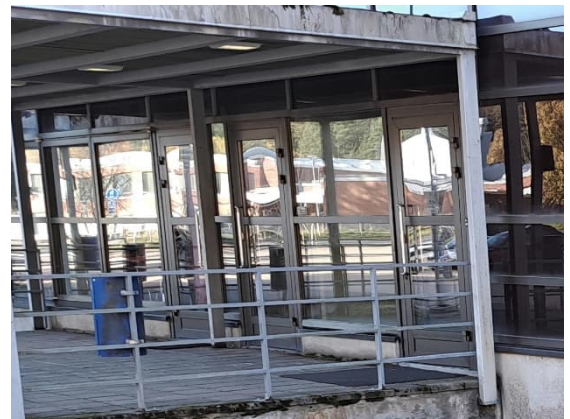
Kuva 55. Päävet ovat metalli-lasiovia.
