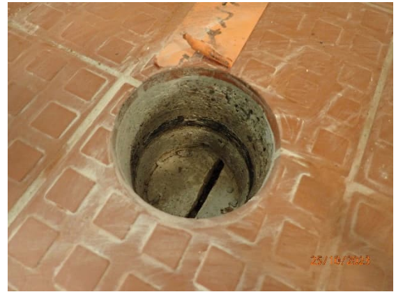
Kuva 59. Väestönsuojan yläpuolella olevaan välipohjarakenteeseen tehtiin avaus.
