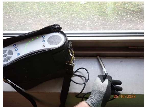
Kuva 43. Merkkiainekokeessa havaittiin selkeitä vuotoja ikkunaliittymien kautta. Merkkiainekoe tehtiin rakennuksen normaalipaineessa.
