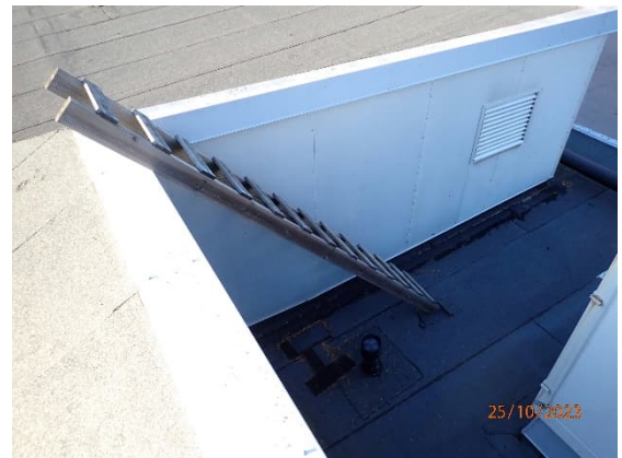
Kuva 77. Vesikatolle kulku on puisia tikkaita pitkin.
