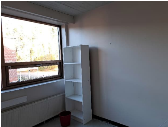
Kuva 28. Asuntolakerroksen ulkoseinien sisäkuori on betonia.
