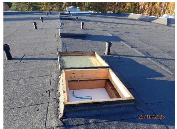
Kuva 73. Vesikatolta on pääsy alakattotilaan, luukuissa on eristeenä polystyreenilevyt.
