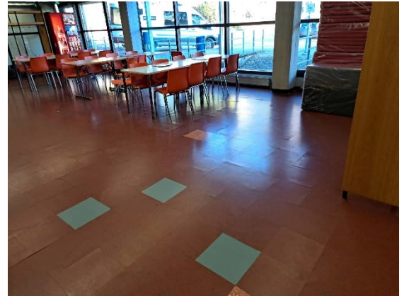
Kuva 61. Lattian pintarakenteet on asennettu suoraan betonin päälle.
