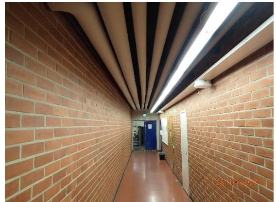
Kuva 37. Suuri osa väliseinistä on tiilirakenteisia, kuva pohjakerroksen käytävältä.
