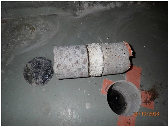
Kuva 22. Rakenneavaus RAK2 varaston alapohjarakenteeseen.
