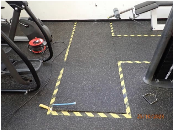
Kuva 16. Kuntosalin lattia on uudehko, lattiassa on tekniikkakanaalin luukku.
