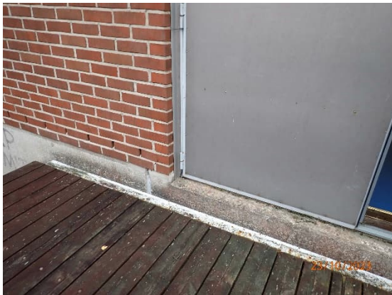
Kuva 36. Sokkelin korko ovea verrattuna ulkopuolelta rakenneavauksen RAK5 kohdalla.
