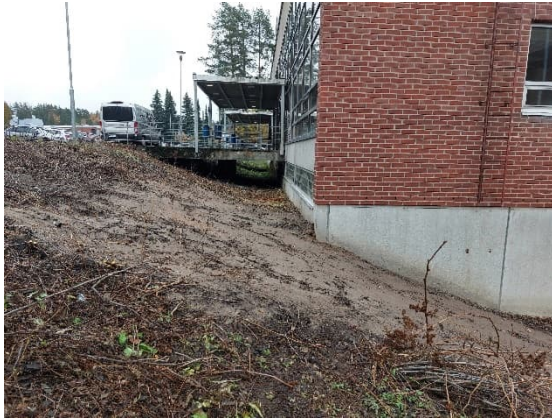
Kuva 4. Rakennus on rinteessä ja maanpinta laskee jyrkästi lounaaseen päin. Pohjoisnurkalla on tehty maankaivuutöitä.
