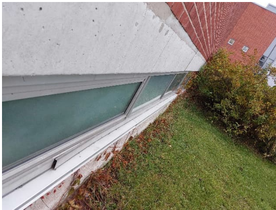
Kuva 46. Kellarikerroksen ikkunoita, vesipellit ovat tasaiset, eivätkä juurikaan kallista rakennuksesta poispäin.
