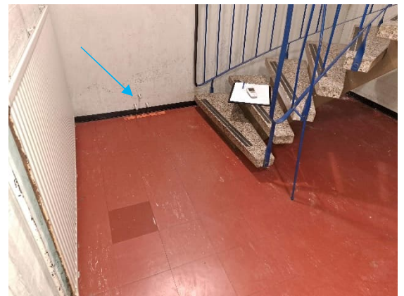
Kuva 27. Maanvastaiseen seinään tehtiin rakennearvotmittaus.
