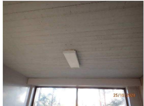
Kuva 63. Asuntolakerroksessa kattopinnat ovat maalattua betonia.
