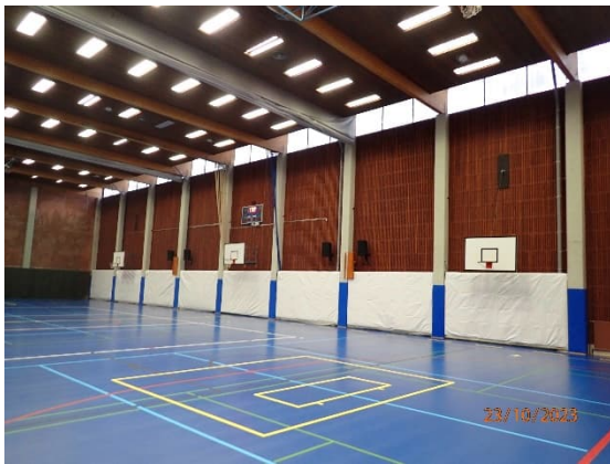
Kuva 34. Salin pitkä seinä on levyrakenteinen ja pinnaltaan puurimoitettu.
