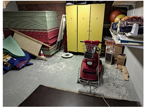
Kuva 87. Varastotilojen lattiat ovat maalattua betonia ja kuluneet
