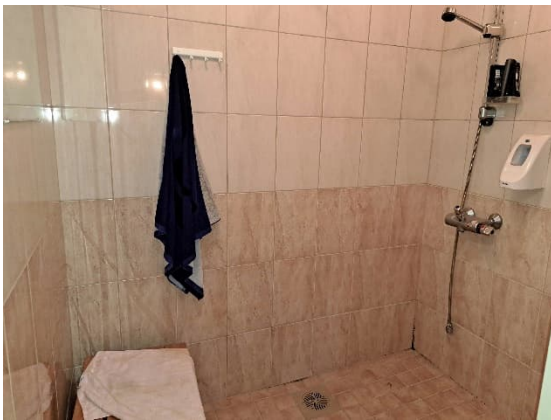
Kuva 94. Asuntolakerroksen suihkutila on mahdollisesti uudempi
