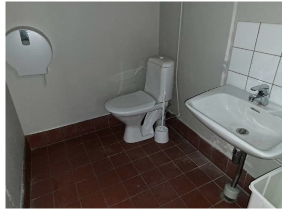
Kuva 93. WC-tila, osa kalusteista uusittu
