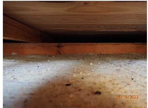
Kuva 75. Yläpohjaelementtien eristeenä on lasivillaa ja sen yläpuolella on tuuletusrako.
