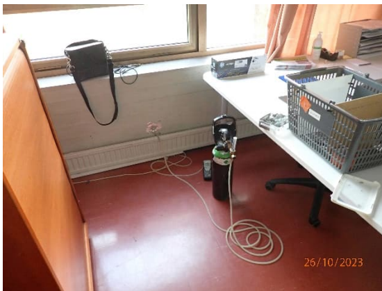
Kuva 42. Merkkiainekoe tehtiin laskemalla merkkiainekaasua ulkoseinän eristekerrokseen ja havainnoimalla mahdollisia vuotokohtia merkkiainelaitteella.
