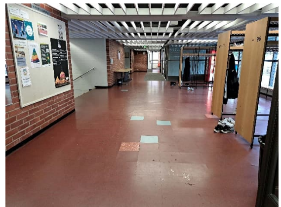
Kuva 31. Sisääntulokerroksen ulkoseinät ovat betonia, väliseinät muurattuja.
