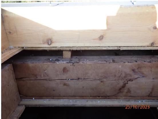
Kuva 74. Yläpohjarakenteesta voitiin tehdä havaintoja vain luukun reunalta.
