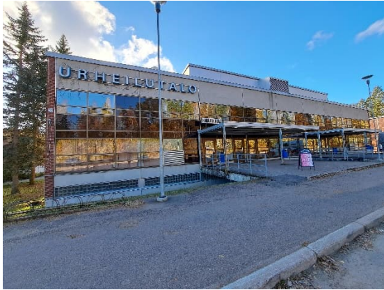
Kuva 2. Pääsisäänkäynnin puolella on asfaltoitu pysäköintialue. Sisäänkäynnille johtaa betoninen silta.
