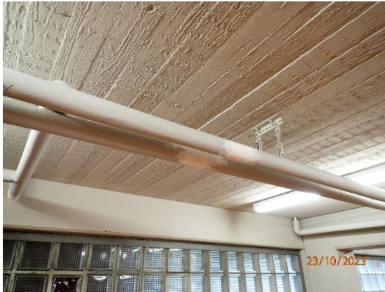
Kuva 60. Kattopinnat ovat pääosin maalattua betonia.
