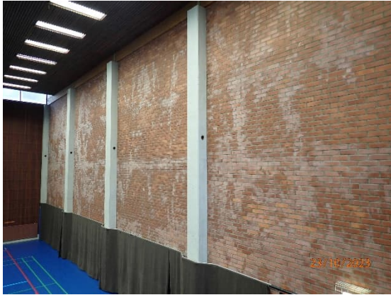
Kuva 32. Salin päätyseinät ovat tiilivilla-tiilirakenteiset.
