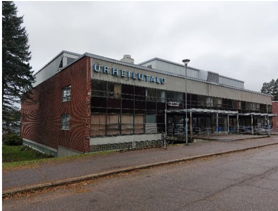
Kuva 44. Koillispuolen julkisivu on pääosin ikkunapintainen.
