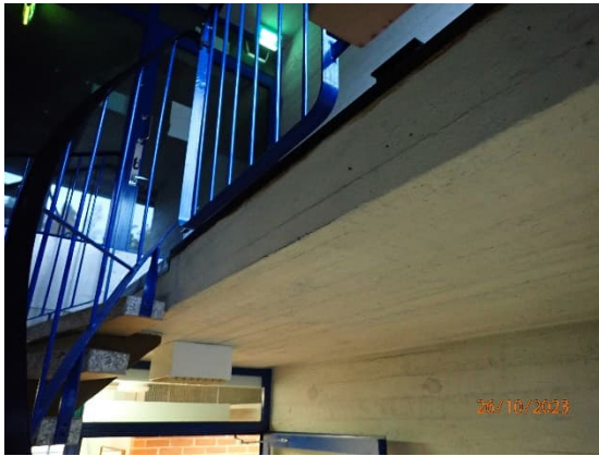
Kuva 58. Porrashuoneiden kohdalla välipohjan paksuus on nähtävissä.
