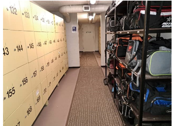
Kuva 17. Väestönsuojassa lattiapinnoitteena on muovimattoa.
