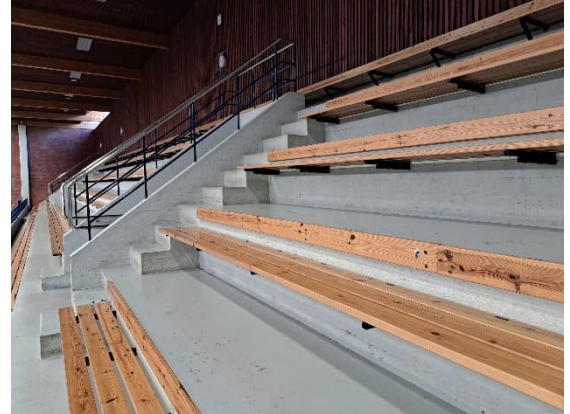
Kuva 81. Katsomossa on betonirakenteiset tasoerot ja niissä puurakenteiset penkit.
