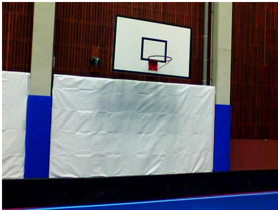
Kuva 82. Salin pitkälle ulkoseinälle on asennettu suojapressut.
