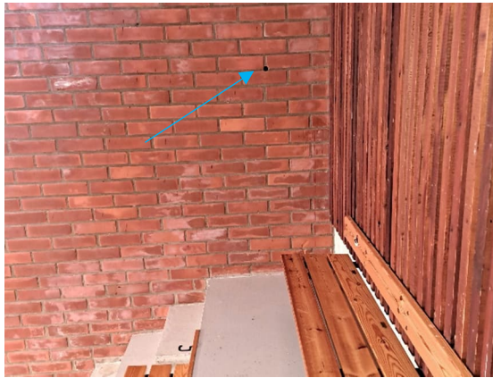
Kuva 38. Näyte M6 otettiin katsomon yläpäästä, ulkoseinärakenteesta.
