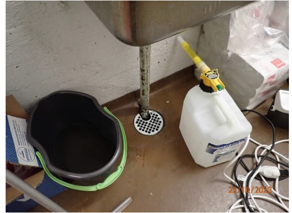
Kuva 99. Lattiakaivot ovat vanhoja valurautakaivoja.
