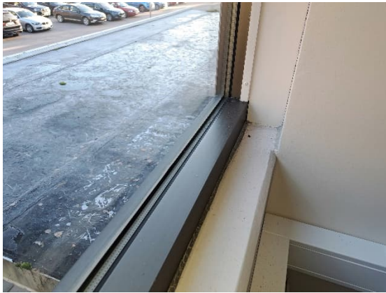
Kuva 50. Ikkunat ovat pääosin metallirunkoisia lämpöelementti-ikkunoita.
