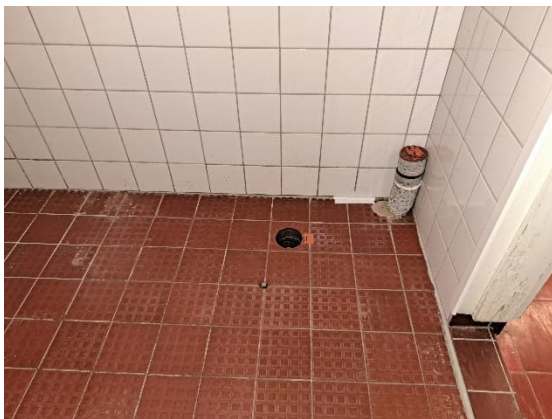
Kuva 20. Rakenneavaus RAK3 pesutilan 129 alapohjarakenteeseen.
