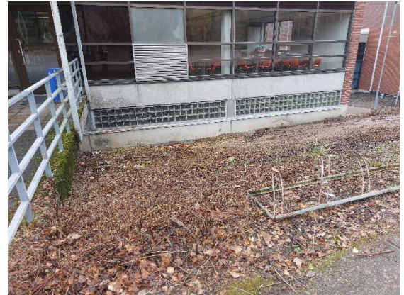
Kuva 45. Ikkunat ovat lämpöelementtiä, kellarikerroksessa on lasitiili-ikkunaa.
