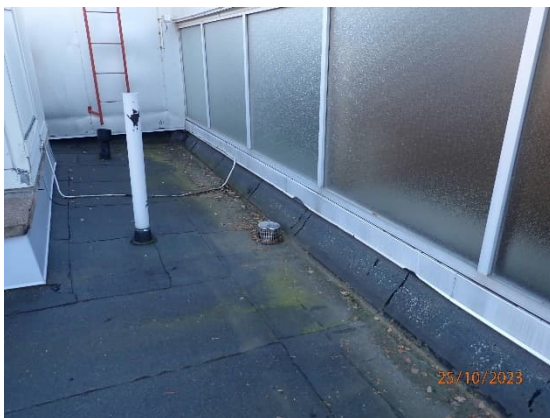
Kuva 48. Katsomon yläosassa olevat ikkunat ovat metallirunkoisia.
