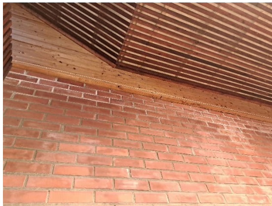
Kuva 64. Salin päädyssä alakattorakenne on liimapuupalkkia vasten ja nousee reunoilla.
