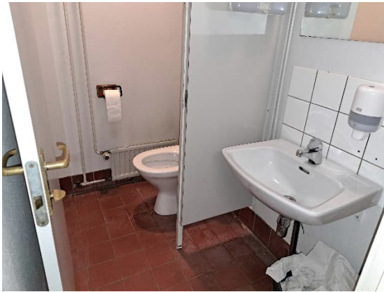
Kuva 92. WC-tilat ovat pääosin alkuperäisiä.
