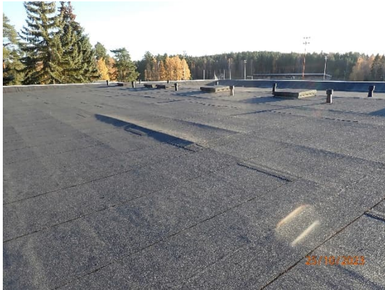
Kuva 70. Salin vesikatolla on useita luukkuja alakattotilaan.
