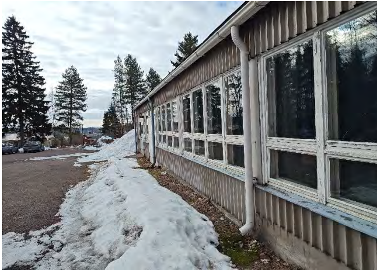
Kuva 12. Työpajan sadevesi ohjataan sokkelin viereen.
