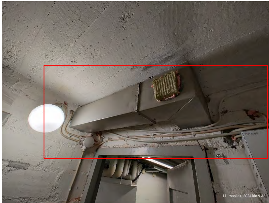
Kuva 29. Rakennusten johtoläpivientien ja palokatkojen kartoitus on suositeltavaa (paloturvallisuus).
