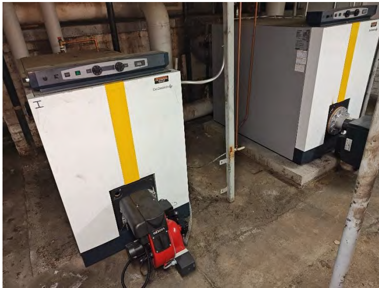
Kuva 1. Öljylämmityskeskuksen kattilat
