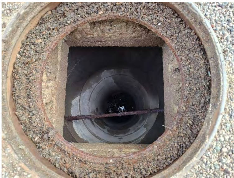
Kuva 11. Sadevesikaivo betonirenkailla.
