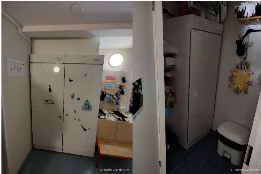
Kuva 40. Rakennuksissa on käytössä useampia kuivauskaappeja.
