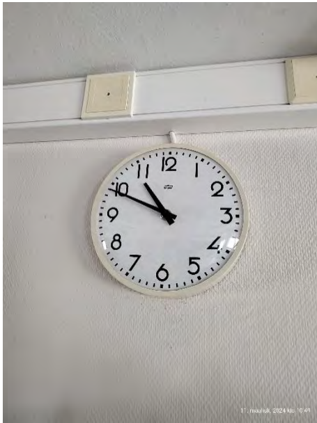
Kuva 44. Keskuskellojärjestelmän kellolaite.
