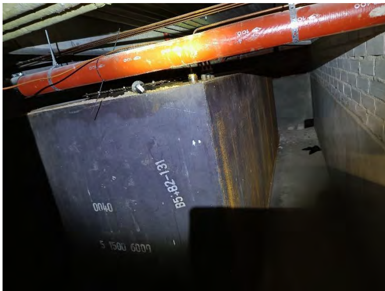
Kuva 2. Öljysäiliöt kellarissa 2 kpl
