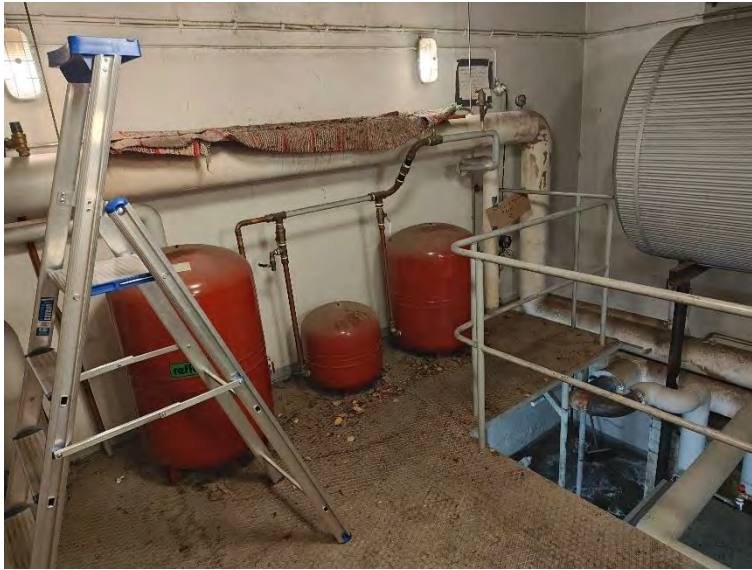
Kuva 3. Lämmitysverkostojen paisuntalaiteet
