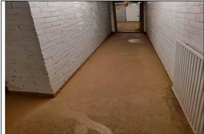
Kellarikerroksen maalattu lattiapinta
