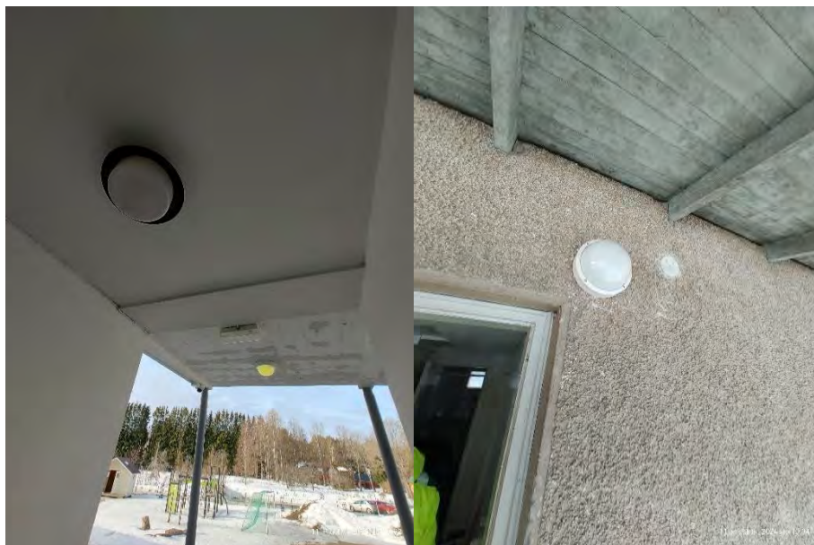
Kuva 20. Ulkovalaisin malleja. Hämäräkytkinohjausten toiminta tulisi tarkastaa.
