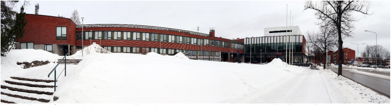
Kuva 14. Näkymä Salpausselänkadun varrelta Kunto- ja sivistystalon sekä teatterin muodostamalle piha-alueelle.
