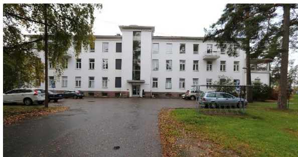
Kuva 12. Keuhkotautiparantola, pohjoisjulkisivu, arkkitehti Eino Forsman 1933.
