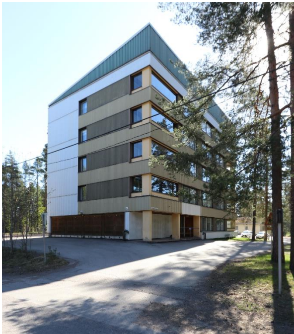
Kuva 20. Lääkärien ja muun johtavan henkilökunnan kerrostalo, arkkitehti Väinö Vuorinen 1962-63, muutokset 1981.
