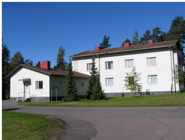
Kuva 24. Puretun rakennuksen sairaalan puoleisessa siivessä sijaitsevat pesula ja sosiaalitiloja. Kuva Sanna Mäkinen 2003.
