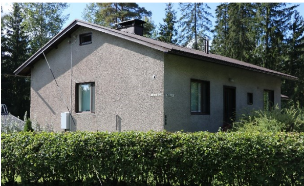
Kuva 26. Viulukuja 20, rakennusmestari Kaarlo Ritvola 1960.
