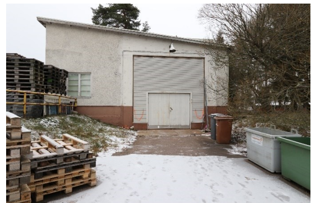
Kuva 18. Huoltamorakennus, lounaisjulkisivu 24.11.2022. Suuri oviaukko on avattu seinään rakennuksen muutostöiden yhteydessä.
