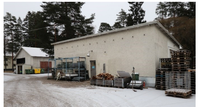
Kuva 17. Huoltamorakennus, luoteisjulkisivu. Taustalla rautavaraston rakennus. Kuva 24.11.2022.
