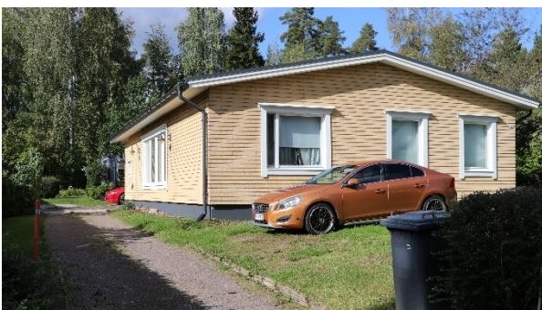
Kuva 28. Viulukuja 8, Puutalo Oy:n valmistalo "Pirkko" 1959.
