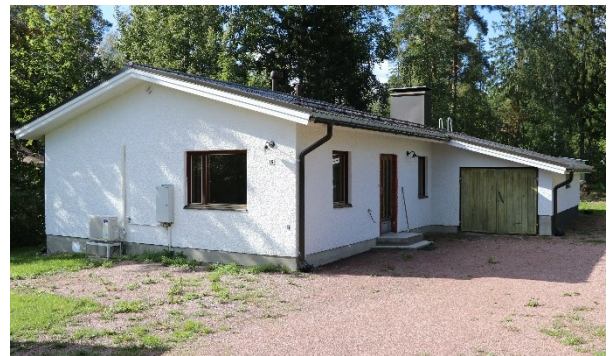
Kuva 29. Viulukuja 18, rakennusmestari Kaarlo Ritvola 1961.
