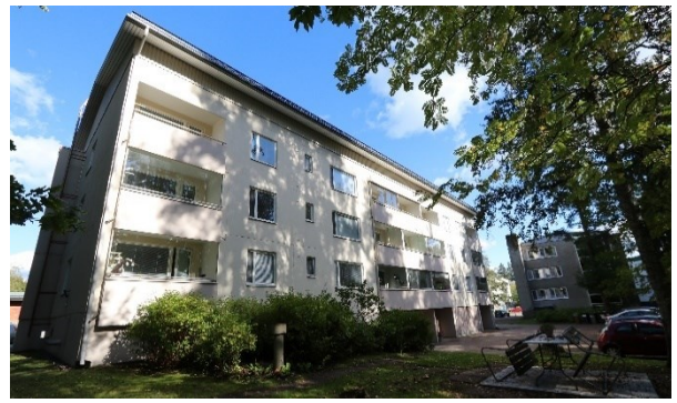
Kuva 36. Kallantie 1 eteläjulkisivu. Muutoksia 2000-l.
