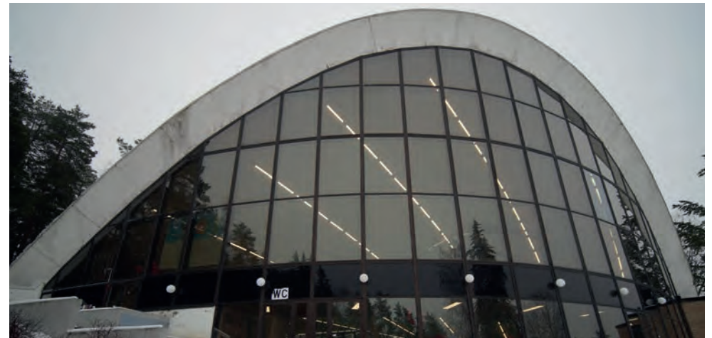
Osasuurennos viereisestä valokuvasta. Lasiseinän yksitiskohtia. Vaaka- ja pystysuuntaiset ikkunaseinän runko-/puittejakojen liitoskohdat muodotavat suorakulmisen liitoksen. Vaakajajon profiilit ovat vaihtelevan levyiset - kaksi eri levyyttä. Lasiseinällä olevissa valaisimista on poistuneet yläpuoliset varjostimet. Valaisin tyyppi ominaisuuksiltaan on muutettu. Valokuva Kari Mustonen, 25.1.2023.
