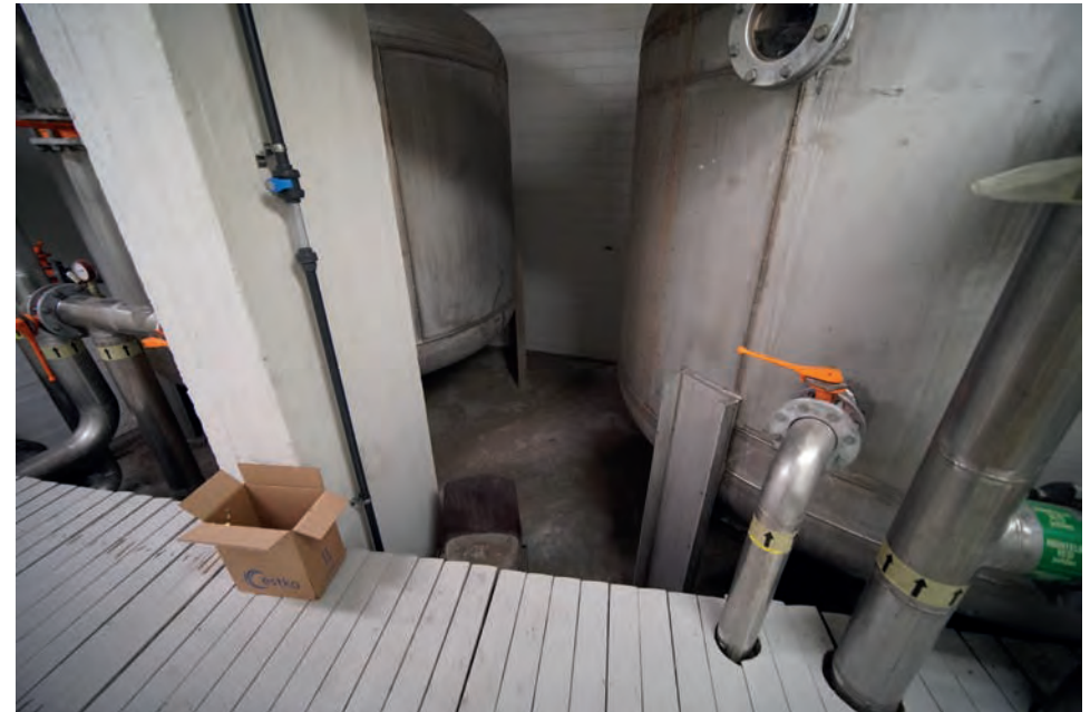
Urheilupuiston uimahalli. Pohjakerroksen säilöitä ja käytävä. Vakokuvat: Kari Mustonen 25.1.2023.
