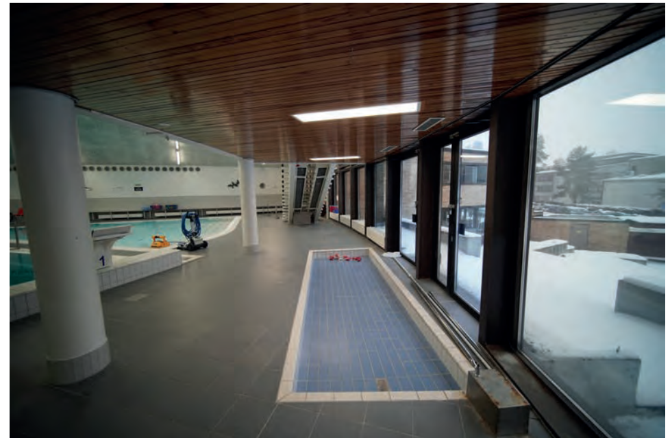
Urheilupuiston uimahalli. Allastilojen miesten wc:t. Allastilan parven alapuoli. Vakokuvat: Kari Mustonen 25.1.2023.
