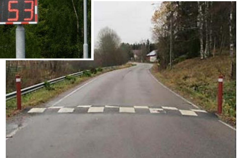
Kuva 11. Keinoja liikenteen ajonopeuksien alentamiseksi: ajoradan kaventaminen (lähde: http://www.thinkstreetsmart.org/traffic-calming.html ), nopeusnäyttö (lähde: Nopeusnäytöt kuntien liikenneturvallisuustyössä. Pohjois-Pohjanmaan ja Kainuun liikenneturvallisuustoimija) ja pikkutöyssy (lähde: Hidasteiden suunnittelu. Liikennevirasto, 2017) ja
