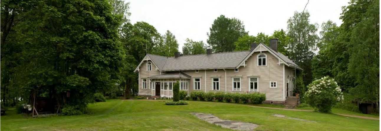
Kuva 45. Pilkanmaan päärakennus. Rakennuksen paikalla oli vanhempi rakennus, joka purettiin. Kartanossa on tehty muutostöitä vuonna 1933, suunnittelijana Heikki Siikonen. Rakennuksen sisätilat on uudistettu kauttaaltaan vuosien 1935–1947 välisenä aikana. Rakennuksen ulkoasu on säilyttänyt lähes alkuperäisen asunsa. Pihanpuolelle on rakennettu sisääntulokuisti, jota on myöhemmin laajennettu.
