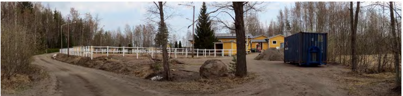
Kuva 42. Kartanon pohjoispuolella sijaitsevan Metelin alueelle on rakennettu uudisrakennuksia ja hevosaitauksia.
