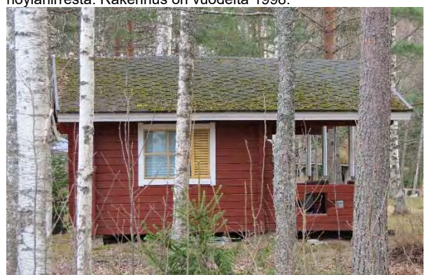
Kuva 220. Höylähirsinen rakennus 1990-luvulta.
