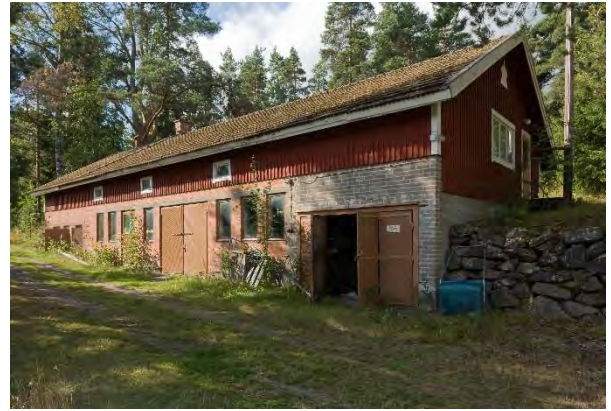
Kuva 78. Saukkolan toinen varistorakennus. Rannassa on lisäksi suurikoinen katos. Kuva Rurik Wasastjerna, 2015.
