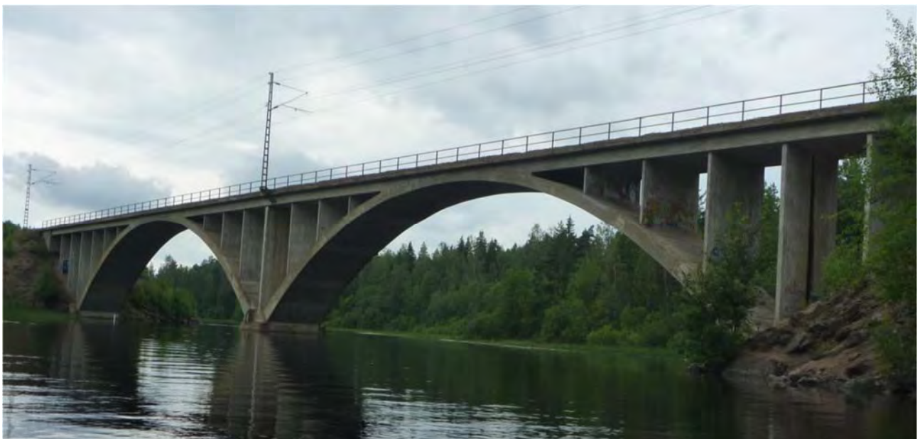
Kuva 73. Savon radalla tehtiin Harjun ja Multamäen välillä vuosina 1968–1970 rataoikaisu, jonka yhteydessä rakennettiin uusi Harjunjoen ylittävä silta (1970) sekä 180 metriä pitkä Venekallion tunneli. Teräsbetoninen rautatiesilta on toteutettu kaksiaukkoisena kaarisiltana.
