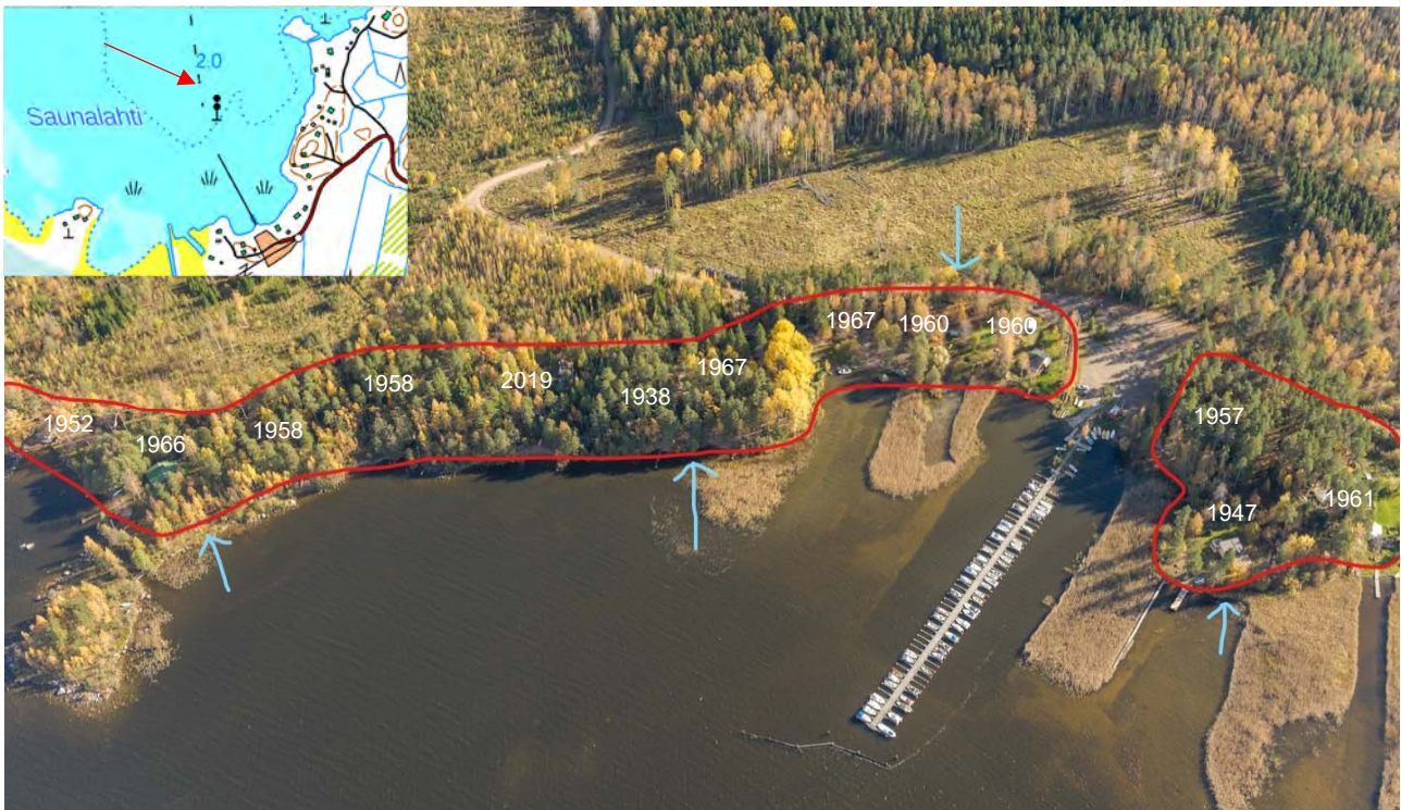
Kuva 203. Viistoilmakuva Pilkanmaassa sijaitsevan Kouvolan kaupungin Saunalahden venesataman alueelta. Saunalahti, eli entiseltä nimeltään Makasiinilahti toimi Halla-yhtiön tukkivarastona. Lahden rannalle oli tuolloin rakennettu torppa lauttavahdin asunnoksi. Vapaa-ajan rakentaminen sijoittuu hyvin kapealle kaistaleelle lähelle Pyhäjärven rantaan. Ensimmäisen vaiheen rakennuspaikat on merkitty kuvan sinisillä nuolilla. Kuva: Lentokuva Hannu Vallas Oy, 4.9.2016.
