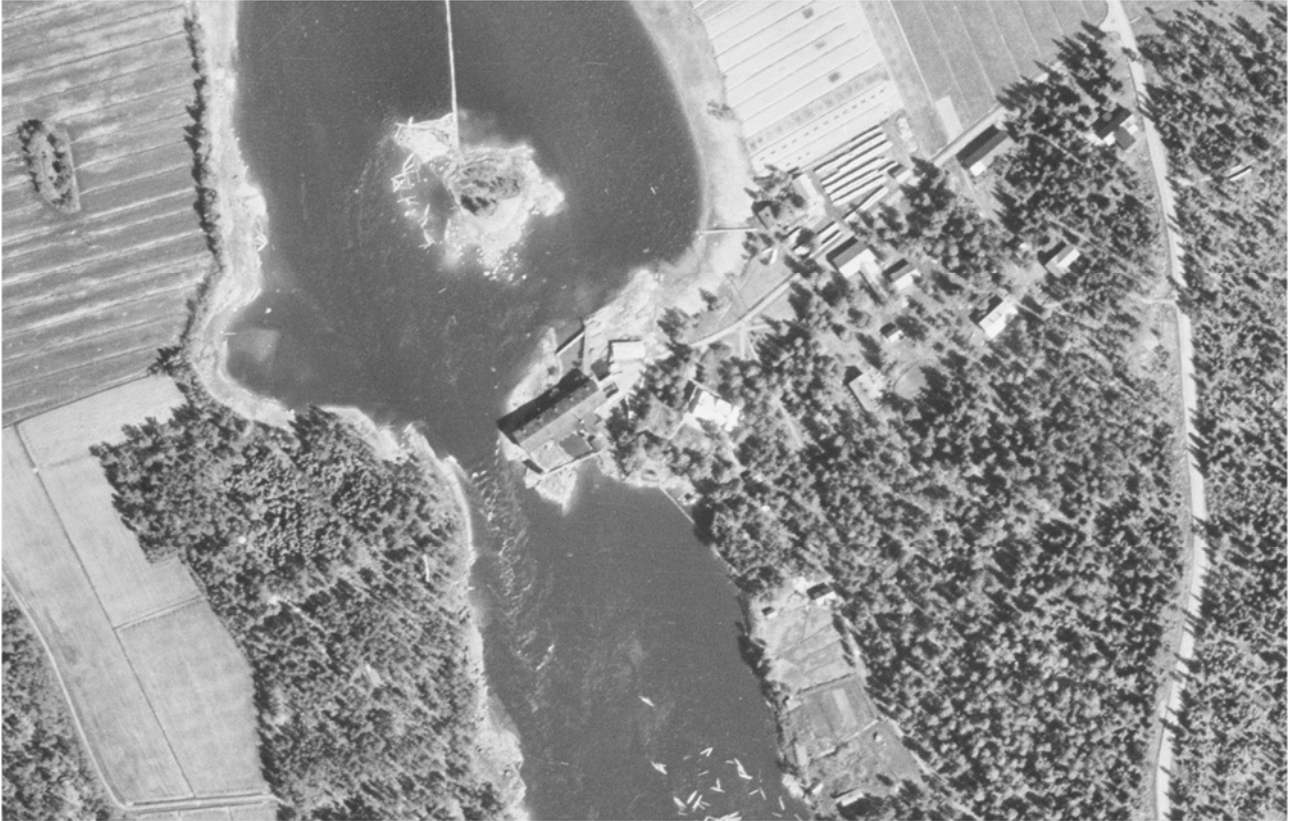
Kuva 123. Harjun villatehtaan alueella oleva rakennuskanta ja tehdasrakennuksen vieressä oleva kulkusillat näkyvät hyvin alueen ilmalokuvassa vuodelta 1941. Lappakoskentien ja alueen sisäänajotien varrella olevat rakennukset on myöhemmin purettu. Kuva: Maanmittauslaitos, paikkatietoikkuna, viimeksi vierailtu 8.9.2023.
