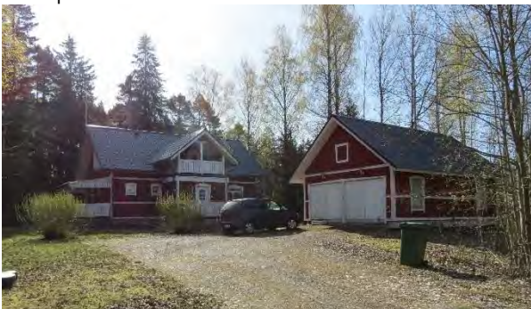
Kuva 26. Vanhan asuinalueen täydennysrakentamista Välikujan varrelta Miehosta.
