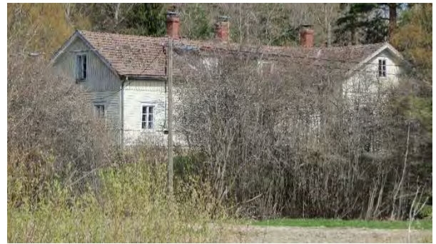
Kuva 158. Mettalon päärakennus Saarennonväylän suunnalta.
