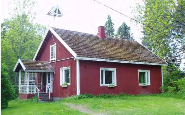
Kuva 58. Asuinrakennus, 1918. Muutokset 1950-luvulla.
