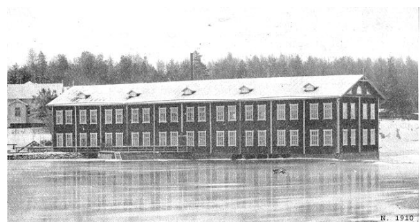
Kuva 122. Harjun villatehdas pohjoisen suunnasta noin vuonna 1910. Taustalla asuinrakennus. Lähde: https://www.porssi-tieto.fi/poistuneet/harju.shtml , viimeksi vierailtu 6.9.2023.
