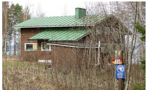
Kuva 212. Vapaa-ajan rakennuksien toinen kerros on myös saatettu ottaa käyttöön, rakennus on vuodelta 1966.
