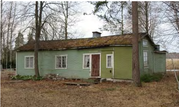
Kuva 206. Vanhimpia rakennuksia on jatkettu ja laajennettu vuosien kuluessa, rakennus on vuodelta 1960.
