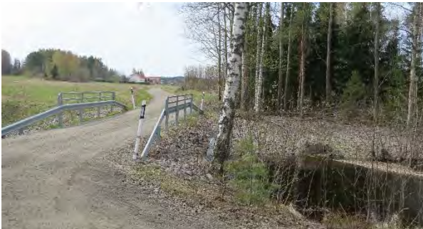
Kuva 282. Huon-ojan, eli Juotin ylittävä siltarumpu.
