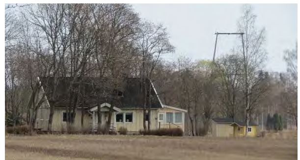
Kuva 44. Pilkanmaan kartanon uudempaa rakennuskantaa.
