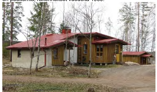
Kuva 209. Alkuperäinen vuodelta 1958 peräisin oleva rakennus on jäänyt kokonaan myöhempien aikojen laajennusten alle.
