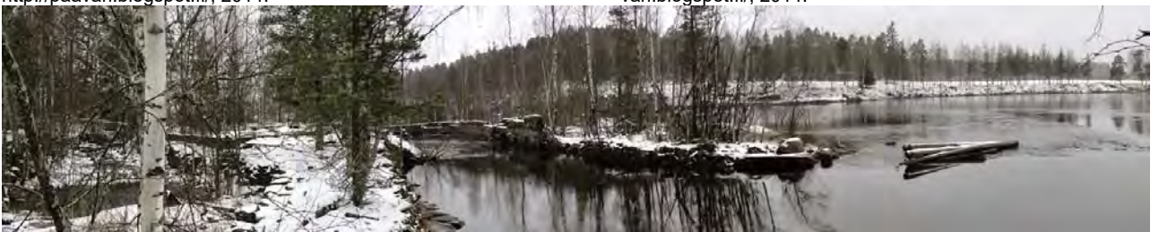
Kuva 126. Näkymä villatehtaan perustusten alueelta. Lähde http://paavari.blogspot.fi/ , viimeksi vierailtu 2014.
