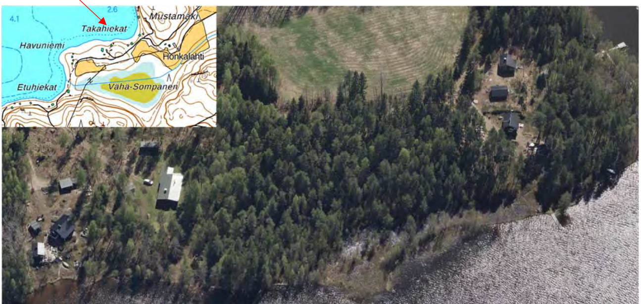
Kuva 163. Näkymä Sompasen itärannalta, jossa alkujaan 1950–1960-luvuilta peräisin olevien rakennuspaikkojen viereen on sijoittunut uutta vapaa-ajan rakentamista 1980–2000-luvuilla. Kuva: Kouvolan kaupunki, 21.5.2022.
