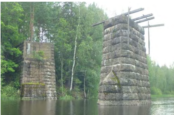
Kuva 69. Harjun rautatiesillan graniittikiviset pylonit. Kuva Hannu Purho, 2013.
