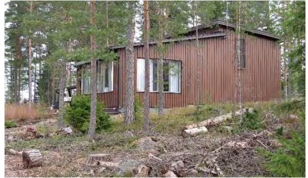
Kuva 217. Alkujaan vuodelta 1930 peräisin oleva vapaa-ajanrakennus, jota on myöhemmin laajennettu kaksi kertaa.
