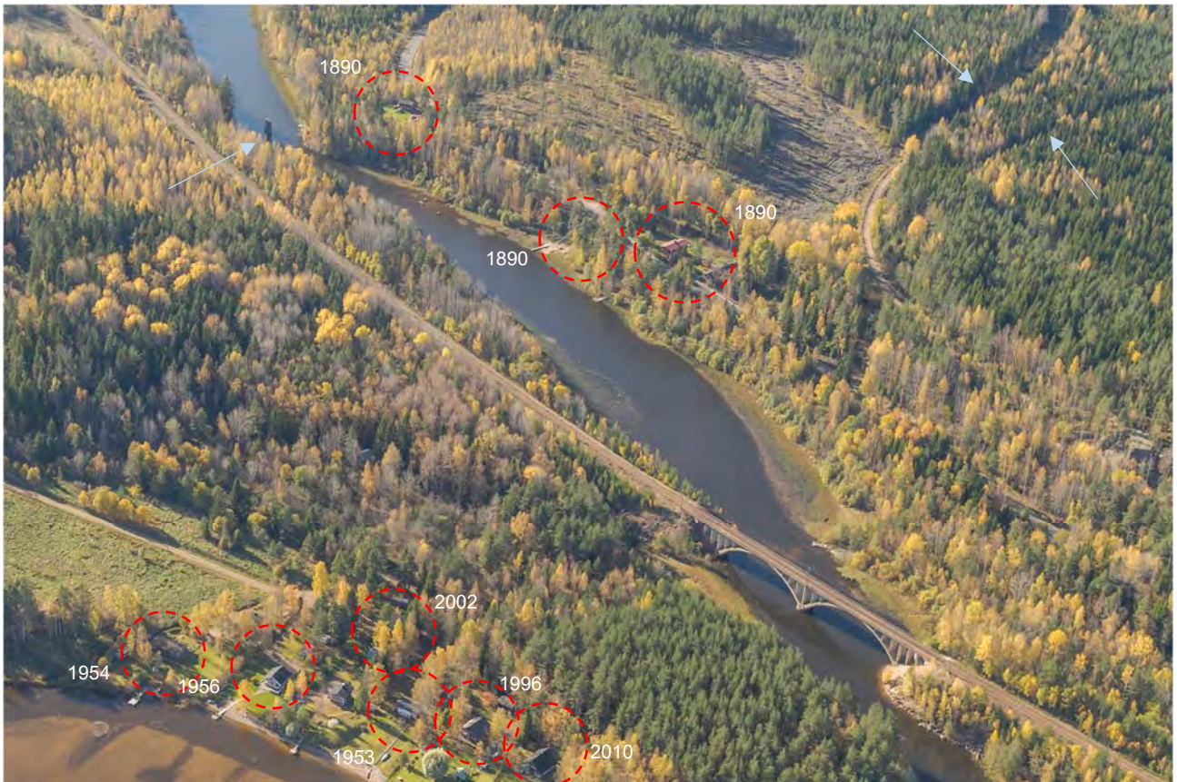
Kuva 72. Näkymä Harjun rautatien alueelle. Kuvan vasemmassa yläreunassa näkyy radan vanhan sillan paikka ja joessa olevat pylonit. Kuvan keskellä näkyvät Haarakallion ratavartijan talot. Oikeassa yläreunassa näkyy metsässä olevana aukkona sekä nykyinen Multahovintie että vanha vuonna 1902 valmistunut Voikkaan tehtaalle johtanut ratalinja. Oikeassa alareunassa näkyvä teräsbetoninen kaksiaukkoinen kaarisilta on valmistunut vuonna 1970. Kuva Lentokuva Hannu Vallas Oy, 3.9.2016.
