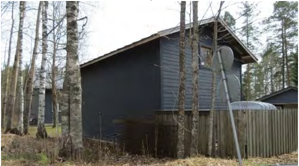
Kuva 285. Osa vanhoista rakennuksista on uusittu kokonaan.
