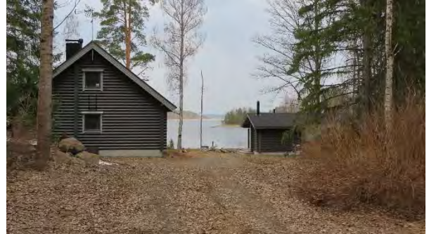
Kuva 218. 2020-luvulla vapaa-ajanrakennuksia on toteutettu pyöröhirrestä. Kuva Palastentien varrelta.
