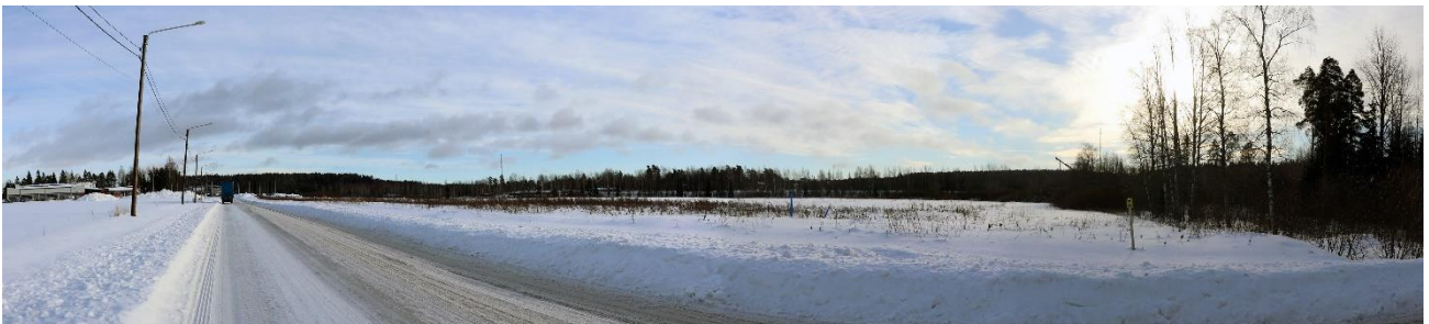
Kuva 2. Näkymä Savonsuontieltä pohjoiseen. Kuvan vasemmassa reunassa on KSS Verkko Oy:n varikko. Taustalla peltoalueen takana näkyy Kouvola – Mikkeli rautatien ratapenger. Kuvan oikeassa reunassa on alueen läpi kulkeva hulevesioja
