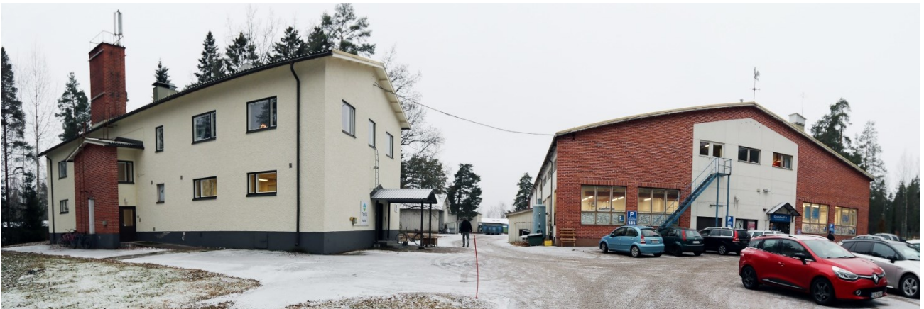
Kuva 10. Parik-säätiön hallintorakennus, Annikki Virtanen, 1957. Kuvassa oikealla olevan varastorakennuksessa (Annikki Virtanen, 1957) sijaitsevat lahjoitetun tavaran käsittelytilat ja rakennuksen itäpäädyssä sijaitsee Goodwill-kierrätystarvikemyymälä.
