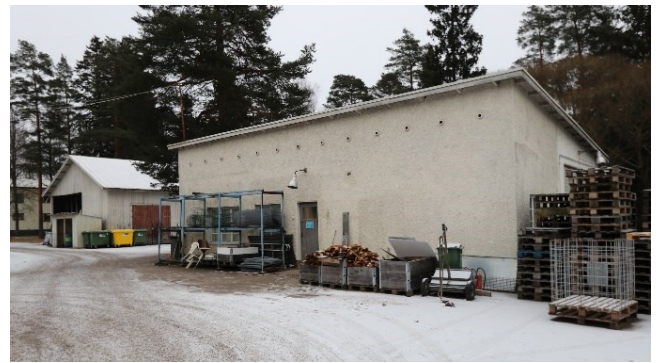
Kuva 17. Huoltamorakennus, luoteisjulkisivu. Taustalla rautavaarasto. Kuva 24.11.2022.
