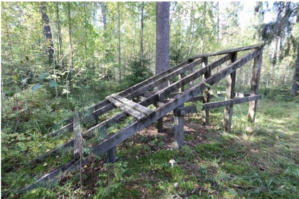
Kuva 46. Alueella on vanhoja kuntoiluvälineitä.
