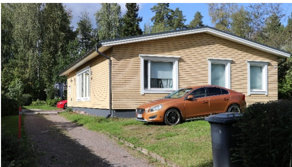
Kuva 28. Viulukuja 8, Puutalo Oy:n valmistalo "Pirkko" 1959.
