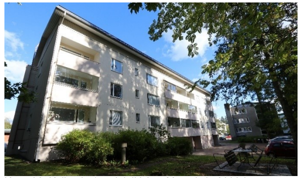
Kuva 36. Kallantie 1 eteläjulkisivu. Muutoksia 2000-l.
