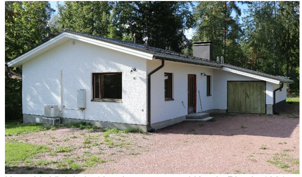
Kuva 29. Viulukuja 18, rakennusmestari Kaarlo Ritvola 1961.
