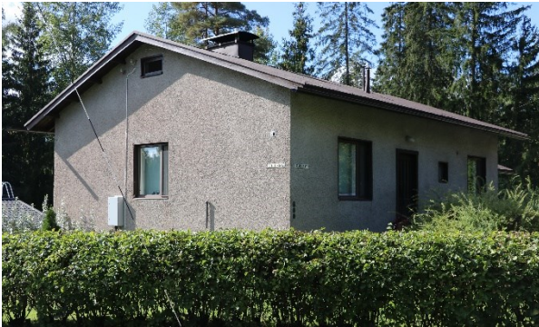
Kuva 26. Viulukuja 20, rakennusmestari Kaarlo Ritvola 1960.
