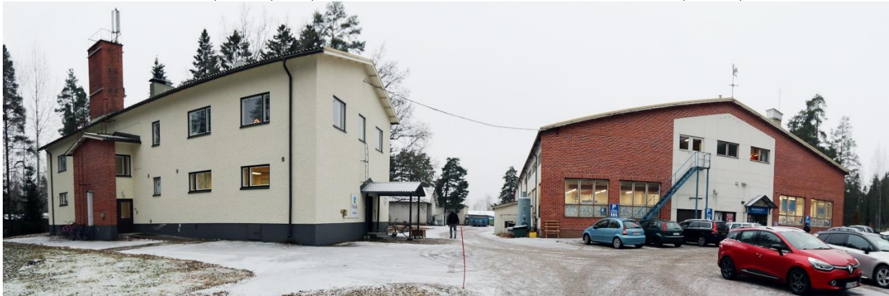
Kuva 10. Parik-säätiön hallintorakennus, v.1957, Annikki Virtanen. Kuvassa oikealla olevan varastorakennuksessa (v. 1957, Annikki Virtanen) sijaitsivat lahjoitetun tavarankäsittelytilat ja rakennuksen itäpäädyssä sijaitsee Goodwill-kierätystarvikemyymälä.
