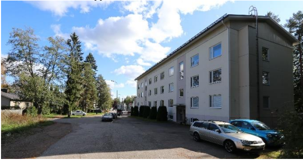
Kuva 13. Näkymä Kallantien ja Viulukujan risteysalueelta itään. Asfaltoitu osa on Kuusantielle vievää kevyenliikenteen yhteyttä.
