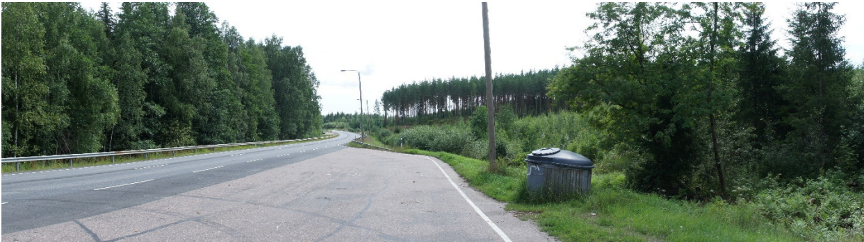
Kuva 7. Kotkan valtatie kuvattuna Käyrälammen suuntaan (kuva 8/2022).
