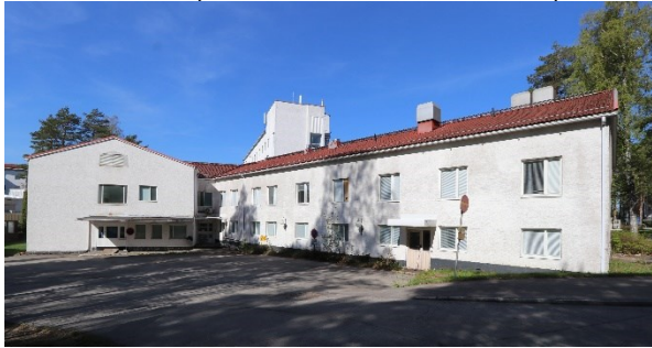
Kuva 5. Oikealla sairaalan synnytysosaston laajennus, Anssi Junkkari ja Kari Toppila Ky, valmistunut vuosina 1989–1990.
