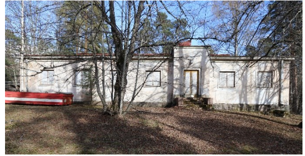
Kuva 15. Autonkuljettajan ja puutarhurin asunto, länsijulkisivu, arkkitehti Eino Forsman 1933.
