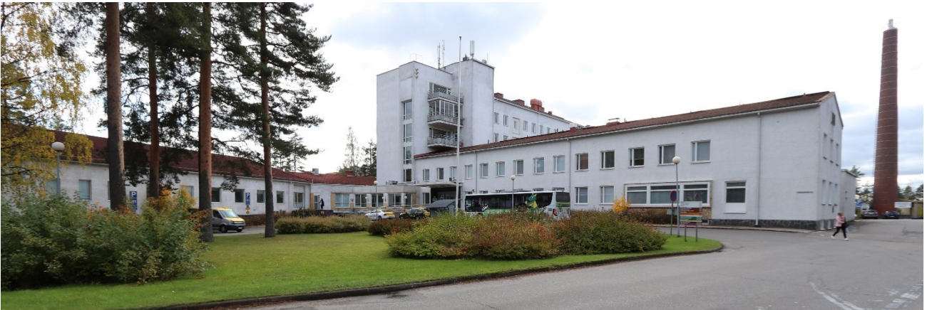
Kuva 3. Vanha sairaalarakennus on rakentunut useammassa vaiheessa. Kuvan rakennukset edustavat rakennuksen ensimmäistä vaihetta, jonka on suunnitellut arkkitehti Ragnar Wessman 1953. Sairaala on myöhemmin muutettu ja laajennettu useaan kertaan.
