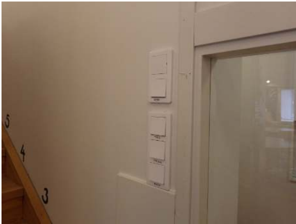
138. Uusittuja sähkökalusteita.
