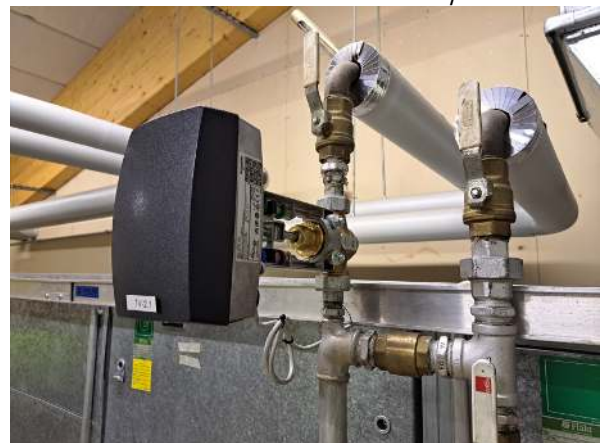
107. Ilmanvaihtokoneiden säätöventtiileitä on juuri uusittu.
