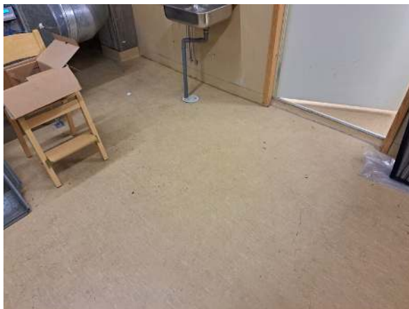
64. Ilmanvaihtokonehuoneen lattiassa muovimatto.
