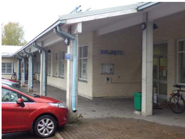
121. Rakenteisiin asennettuja valaisimia.
