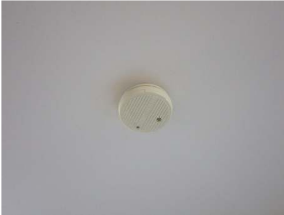
154. Paristokäyttöinen palovaroitin.
