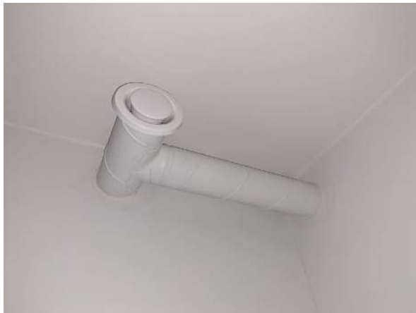
115. Poistoilmaventtiili.
