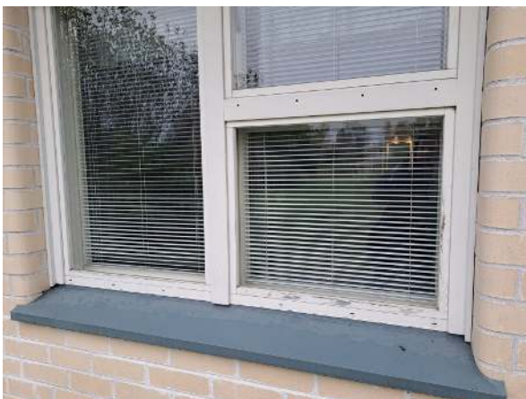
43. Ikkunat ovat MSE -tyyppiset. Ulkopinta on puurakenteinen.
