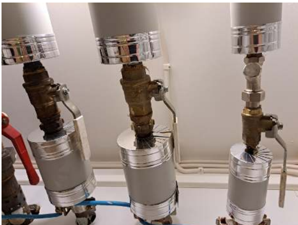
99. Käyttöveden linjaventtiileitä.
