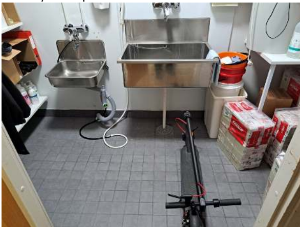
75. Siivoustilan lattia on uusittu.
