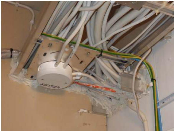
136. Tiivistettyjä kaapeliläpivientejä.
