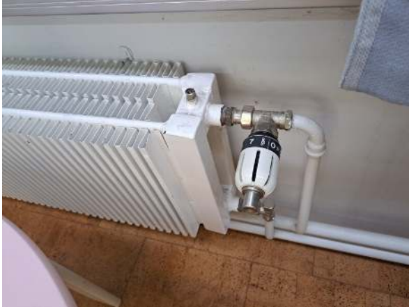
95. Termostaattinen patteriventtiili.
