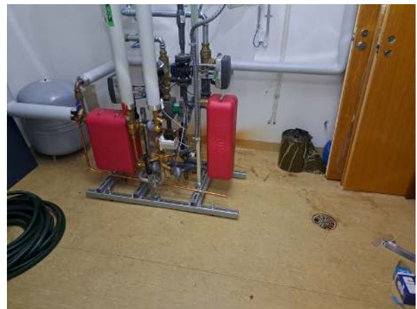
65. Lämmönjakuhuoneen rakenteita. Lattiassa vanha muovimatto.
