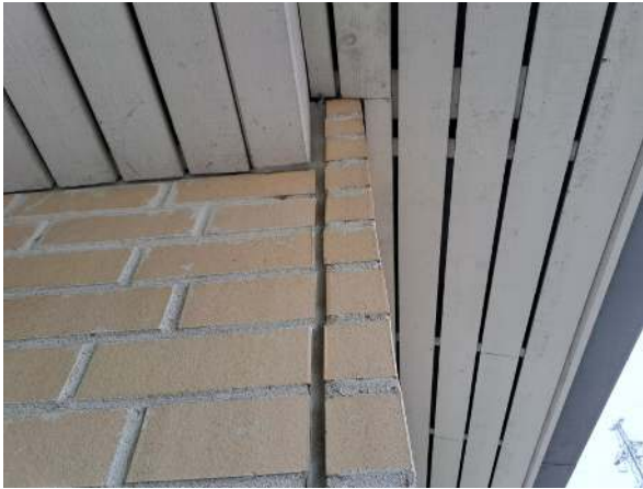
41. Elastinen julkisivusauma ja räystästä.
