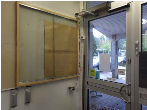
157. Ulko-oven sähköinen avauslaite.
