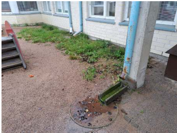
2. Vierustaa ja kattovesien ohjausta päiväkodin piha.
