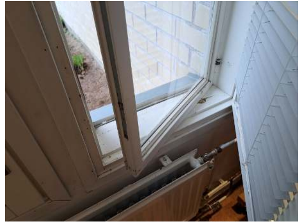
46. Ikkunoiden mekanismeissa ei havaittu vaurioita.
