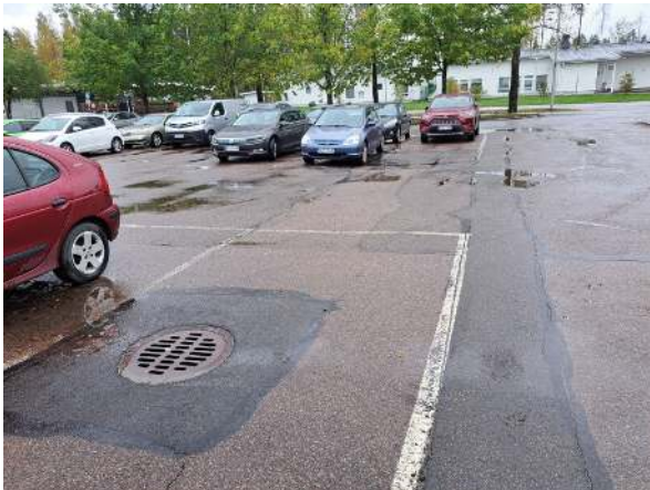
8. Pintavesien ohjausta, paikoin puutteita pyritty korjaamaan.
