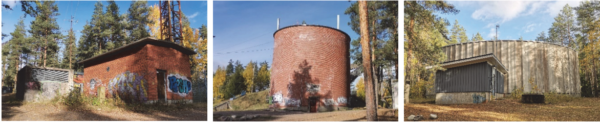
Kuva 10. Tietoliikennemaston juurella olevia teknisiä tiloja.
