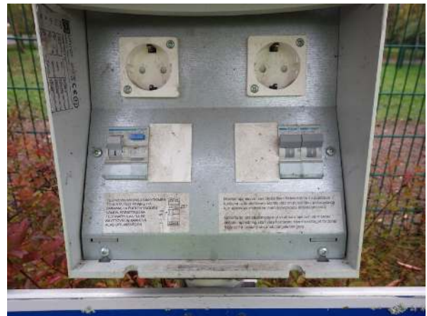
124. Uusittu autolämmityspistorasia (kannet tulisi pitää aina lukittuina).
