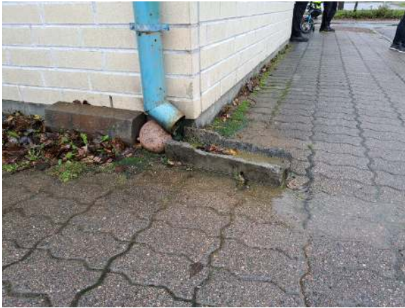
4. Vierustaa ja kattovesien ohjausta Hammashoitolan osalla.
