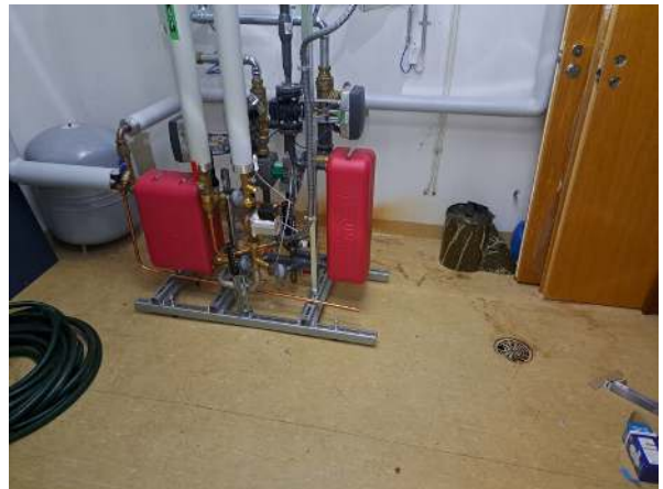
65. Lämmönjakuhuoneen rakenteita. Lattiassa vanha muovimatto.
