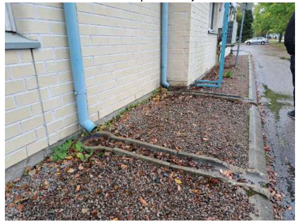
7. Vierustaa ja kattovesien ohjausta kadun puolella.
