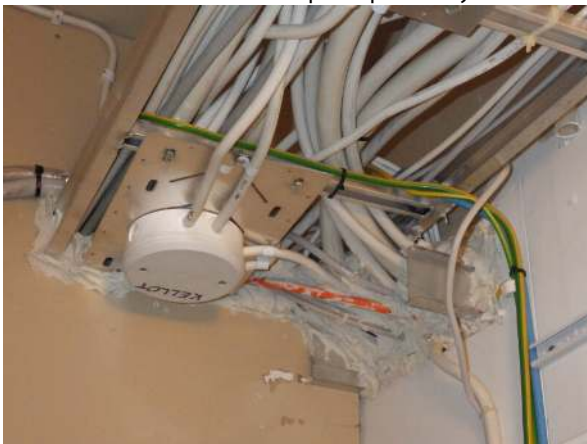
136. Tiivistettyjä kaapeliläpivientejä.
