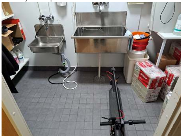
75. Siivoustilan lattia on uusittu.
