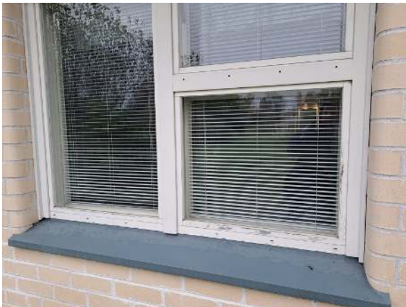
43. Ikkunat ovat MSE -tyyppiset. Ulkopinta on puurakenteinen.
