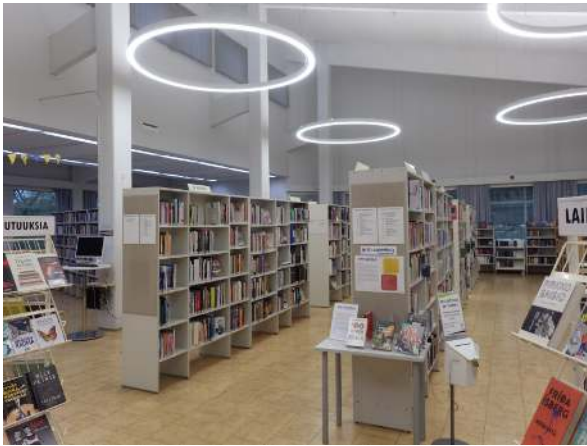
140. Kirjaston uusittua valaistusta.
