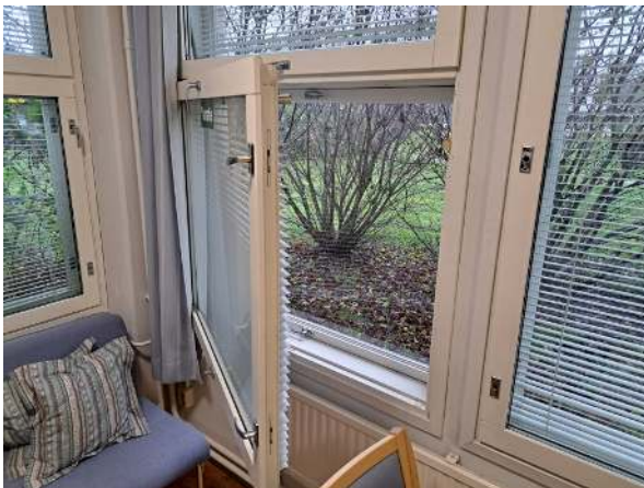
47. Ikkunoiden mekasmisseissa ei havaittu vaurioita.
