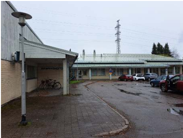
13. Kuvaa kulkuväylien pinnoitteista.
