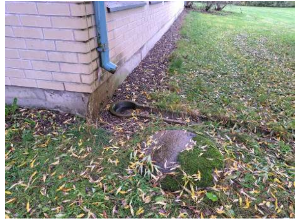
5. Vierustaa ja kattovesien ohjausta takaosalla rakennusta. Nurkalla myös salaojakaivo.
