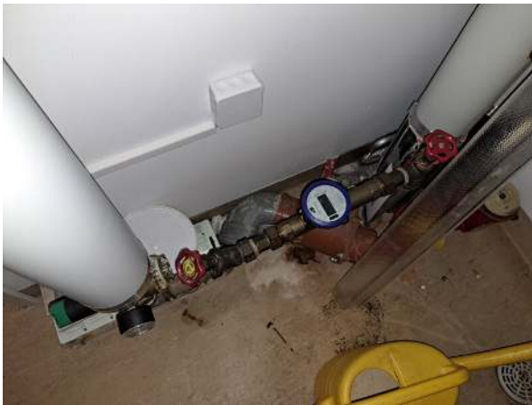
98. Kiinteistön päävesimittari.
