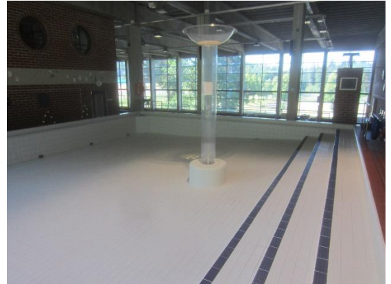
Kuva 25 Laatoitukset ovat tyydyttävässä kunnossa, vaurioita ei havaittu.
