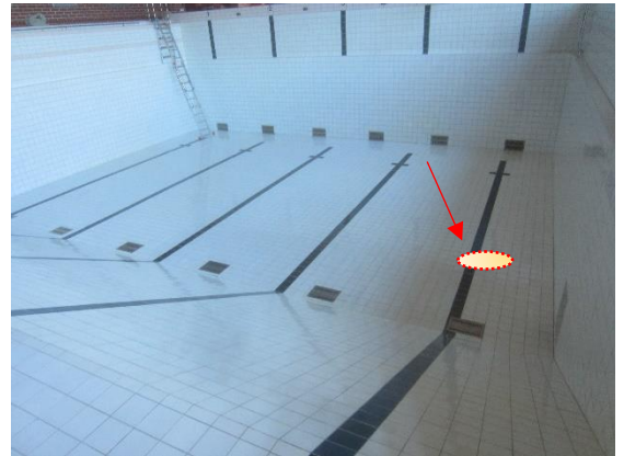
Kuva 14 Ainoa pieni kopaalue todettiin syvässä päädyssä matalan hyppyta-son edessä.
