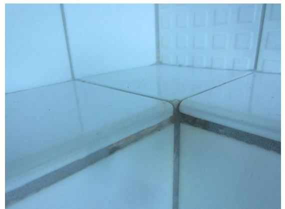
Kuva 18 Laattojen saumojen hyvin paik- allista kulumaa.
