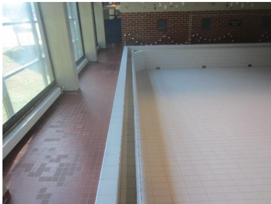
Kuva 26 Loiskekoururakenteen pinnat on altaan ohella saneerattu vuonna 2011.
