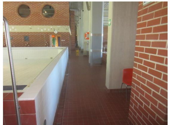
Kuva 47 Pilareissa ei todettu vaurioitumista.
