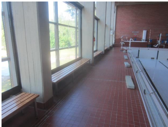
Kuva 46 Allastilojen pilarit ovat tyydyttävässä kunnossa.
