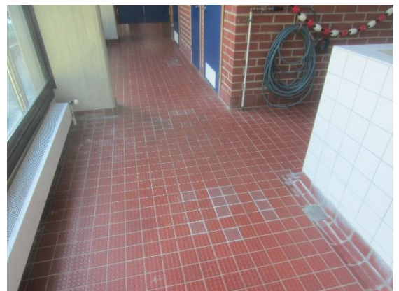
Kuva 37 Laatoituksia on uusittu paikalli- sesti
