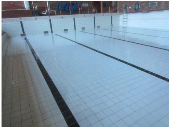
Kuva 13 Altaan laatoitukset ovat hyvin kiinni alustassaan.
