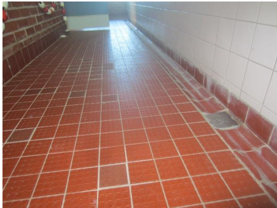
Kuva 38 Laattojen saumoissa ei havaittu merkittäviä vaurioita.
