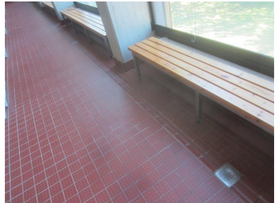
Kuva 39 Laattojen saumoissa ei havaittu merkittäviä vaurioita.
