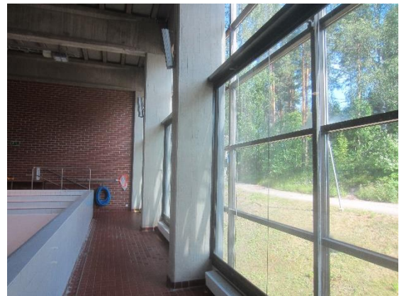
Kuva 49 Lasten altaan viereisiä pilareita on tutkittu aiemminkin.
