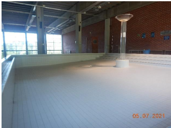
Kuva 28 Altaan laatoitukset ovat hyvin kiinni alustassaan.
