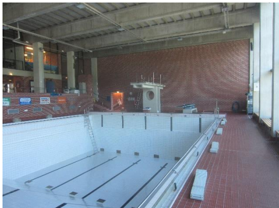
Kuva 34 Kopoa laatoitusta todettiin vain yksittäisiä kohtia.
