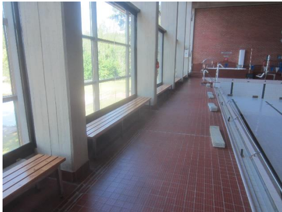
Kuva 32 Allastilojen tasopinnat ovat laa- toitettu keraamisilla laatoilla.
