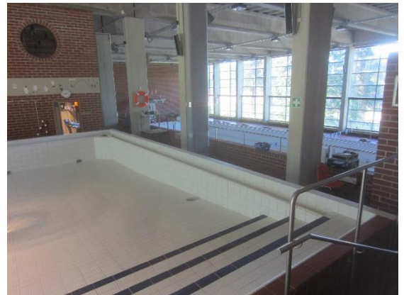
Kuva 27 Lastenaltaassa ei havaittu merkittäviä ruostejätkiä, vaan pinnat ovat siistit.
