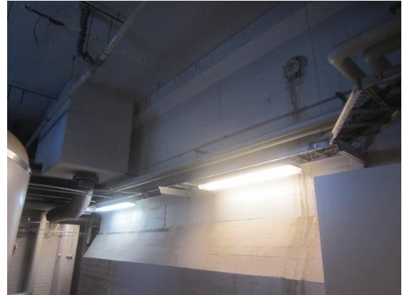
Kuva 20 Vanhoja vuotojälkiä lukuun ottamatta altaan seinät olivat huoltotilojen puolelta tyydyttävässä kunnossa.
