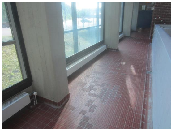
Kuva 48 Lasten altaan viereisissä pilareissa on korjattu vanhoja vaurioita.
