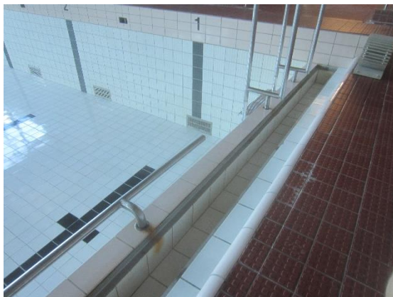
Kuva 11 Ison altaan loiskekoururakenne on uusittu vuonna 1995.
