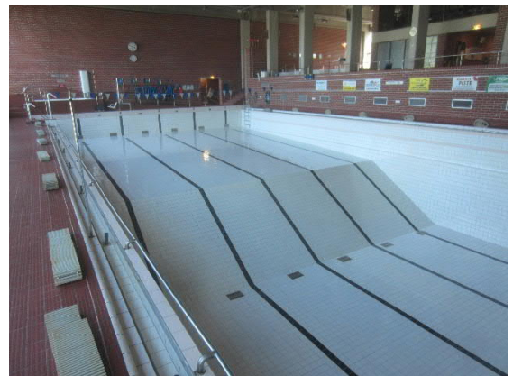
Kuva 33 Altaissa on keraaminen laatoitus. Lähtötietojen mukaan vedeneristeenä on bitumikermi. Altaat on käsitelty tarkemmin erillisessä betonirakenteiden kuntotutkimuksessa.
