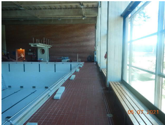
Kuva 66 Allasosaston pilarit ovat siistit.
