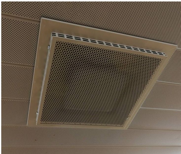
Kuva 13. Esimerkki tuloilman päätelaitteesta.
