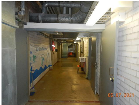
Kuva 24 Teknisen pohjatason käytävällä alapohjan pintamateriaalina on massalattia.
