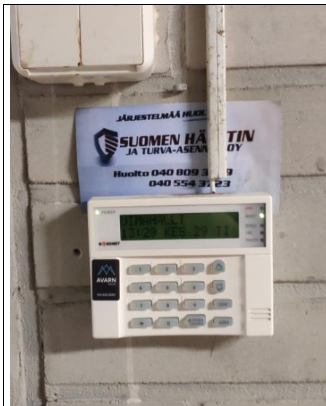
Murtoilmaisimen käyttölaite
