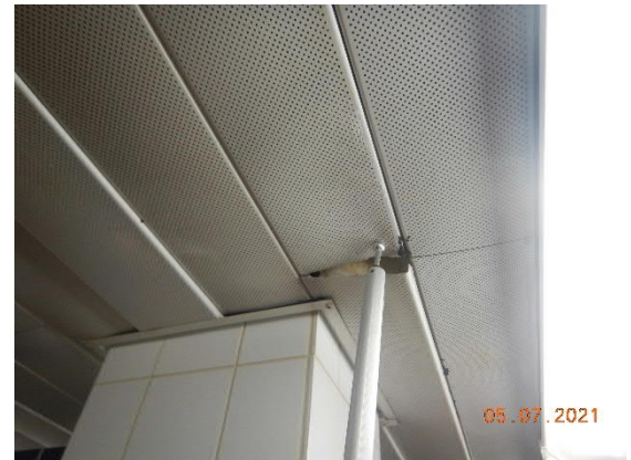
Kuva 82 Säleikköjen yläpuolella on mineraalivillaa.
