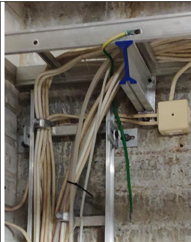
Irronnut pot.tasausjohdin allaslaitetilassa
