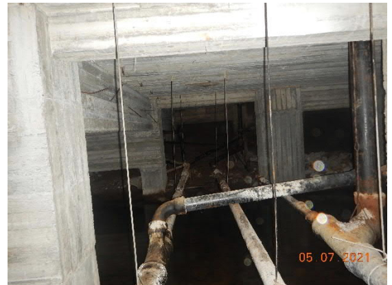
Kuva 23 Alapohjatilassa on pohjaviemärit.
