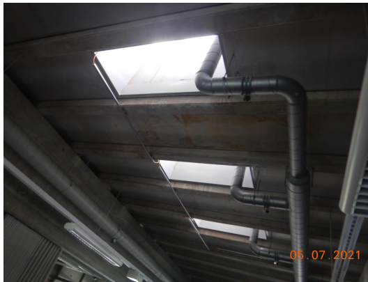
Kuva 111 Kattoikkunan sisäpinnoilla havaittiin valumajälkiä, mutta ei aktiivisia vuotoja.
