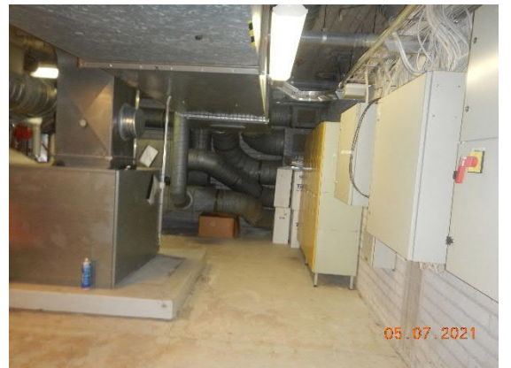
Kuva 25 Maalattua betonilattiaa IV-konehuoneessa.
