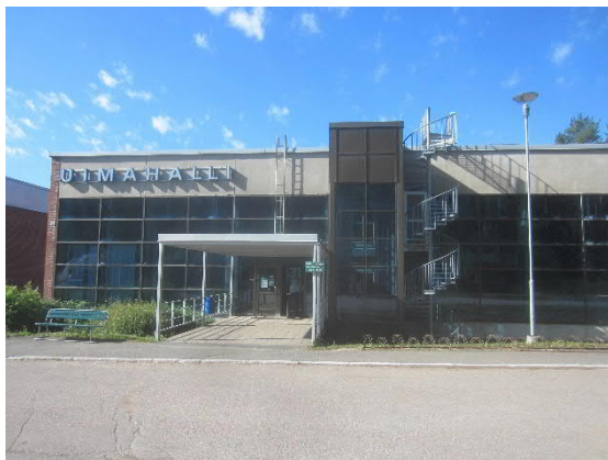
Kuva 52 Koillisivu on pääosin ikkuna- ja sandwich-elementtejä. Pukuhuonekerroksen lasitiili-ikkunat ovat alimpana.
