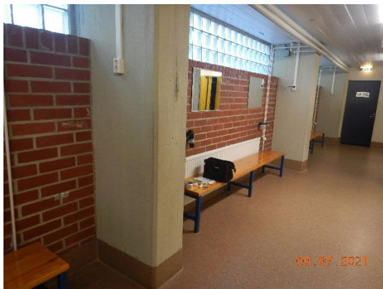
Kuva 68 Pukuhuonetilojen osin maanvastaiset ulkoseinät ovat siistit.
