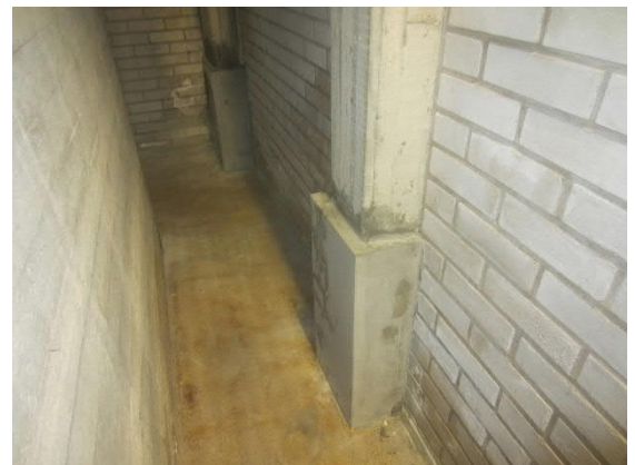
Kuva 69 Tekniikkakerroksessa ulkoseinät ovat siistejä tiilipintoja. Betonipilareja on korjattu (ks. luku 5 Perustukset ja alapohja).
