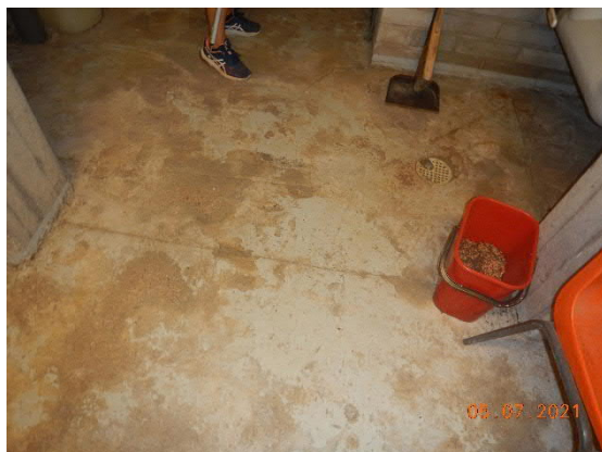
Kuva 26 Maalipinta on paikoin kulunut.
