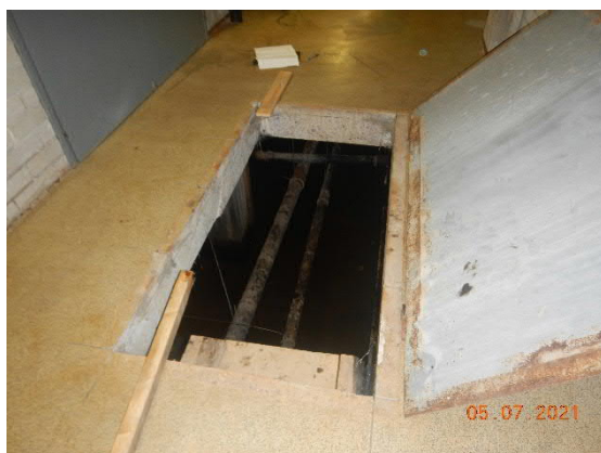
Kuva 20 Teknillisessä pohjakerroksessa on luukku alapohjatilaan.
