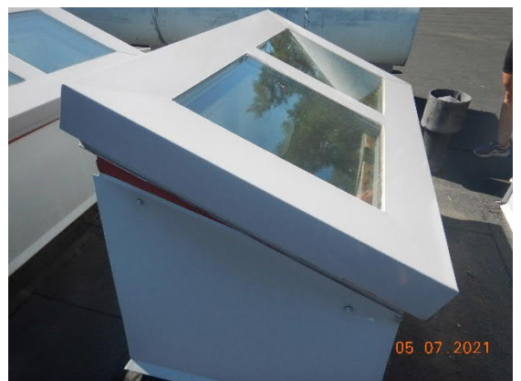
Kuva 110 Kattolyhdyt on korjattu vuoden 1995 peruskorjauksessa ja ne vaikuttivat hyväkuntoisilta.
