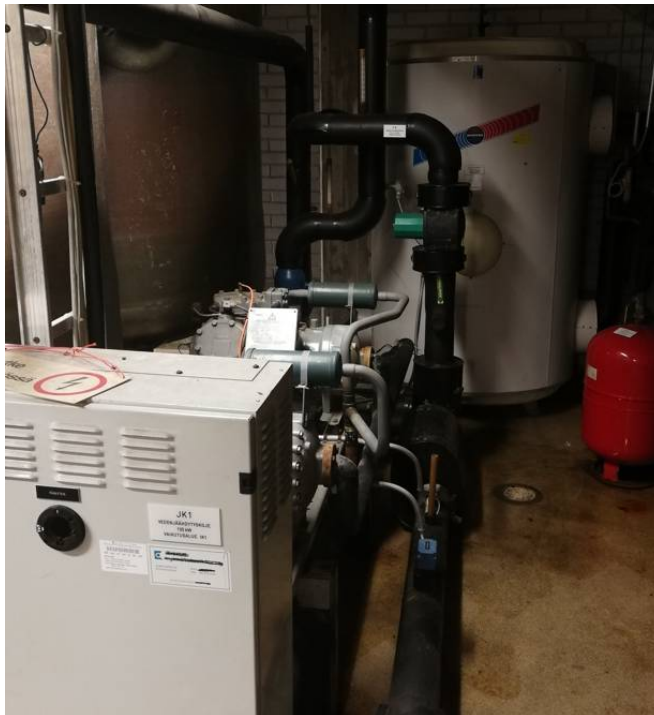
Kuva 16. Vedenjäähdytyskoje allaslaitetilassa.
