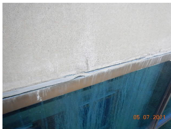
Kuva 57 Epätiivis ikkunaliittymä.
