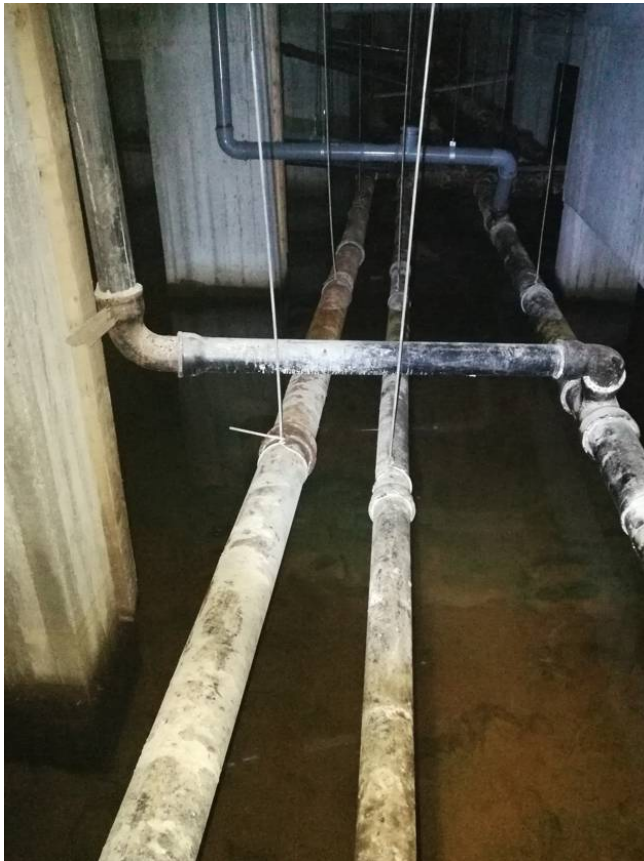
Kuva 6. Esimerkki valurautaviemäreistä tekniikkakerroksen alapuolella.
