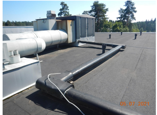
Kuva 106 Yleiskuva vesikatolta. Vesikatolla on pieni IV-konehuone ja läpivientejä lähinnä yläpohjatilän tuuletusputkille.
