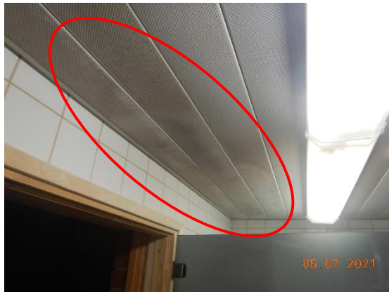
Kuva 81 Kosteusjälkiä metallisäleikköalakatossa.
