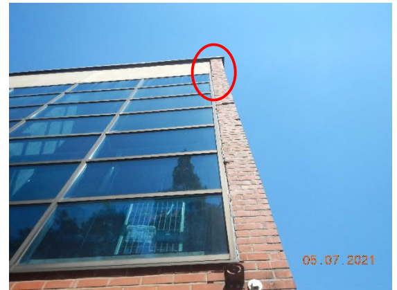
Kuva 45 Vastaavanlainen kallistuma etelänurkalla.
