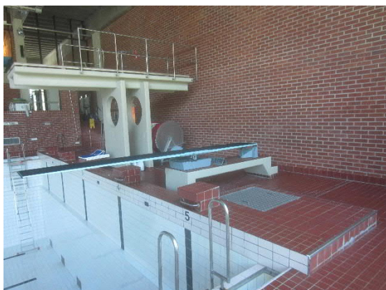
Kuva 64 Ulkoseinien sisäpinnat ovat pääosin muurattuja tiilipintoja.
