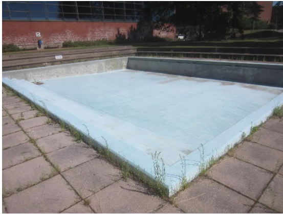
Kuva 34 Ulkoallas on betonipinnalla. Altaat on käsitelty tarkemmin erillisessä betonirakenteiden kuntotutkimuksessa.
