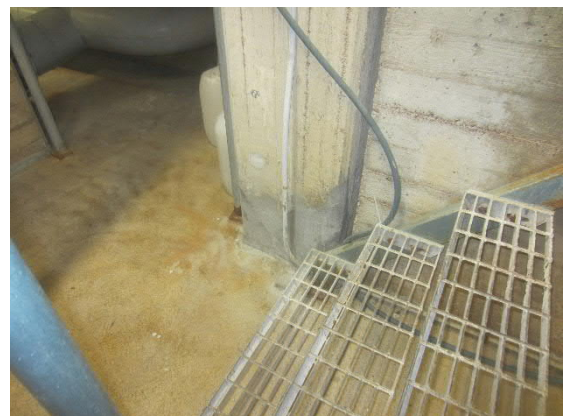
Kuva 27 Tekniikkakerroksessa pilarien alaosien vaurioita on korjattu.
