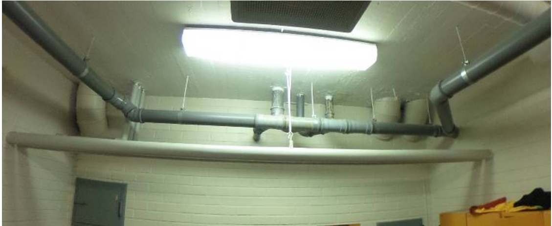
Kuva 7. Esimerkki uusituista muoviviemäreistä tekniikkakerroksessa.
