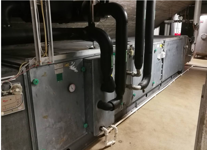
Kuva 12. Ilmankuivatuskone allaslaitetilassa.
