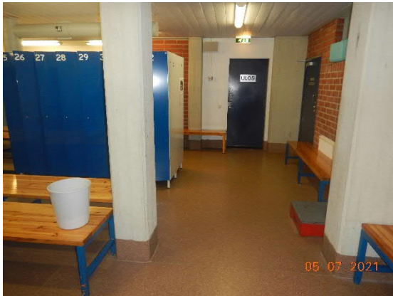
Kuva 30 Pukuhuoneissa alapohjan pintamateriaalina on muovimatto, joka on nostettu seinälle.
