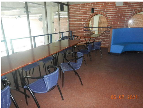
Kuva 77 Ylimmässä kerroksessa on muovimatto.
