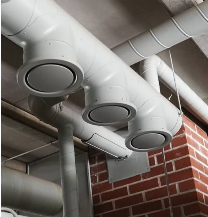
Kuva 14. Esimerkki poistoilman päätelaitetyypeistä.
