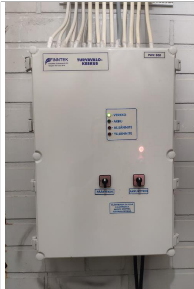
Keskus resonoi voimakkaasti akkukäytöllä
