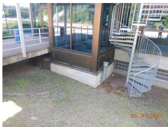
Kuva 59 Koillissivun sinkitty kierreportaitikko on hyväkuntoinen.
