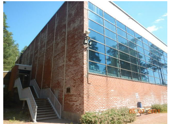
Kuva 43 Kalkkihärmää on erityisesti lounais- ja luodesivuilla.
