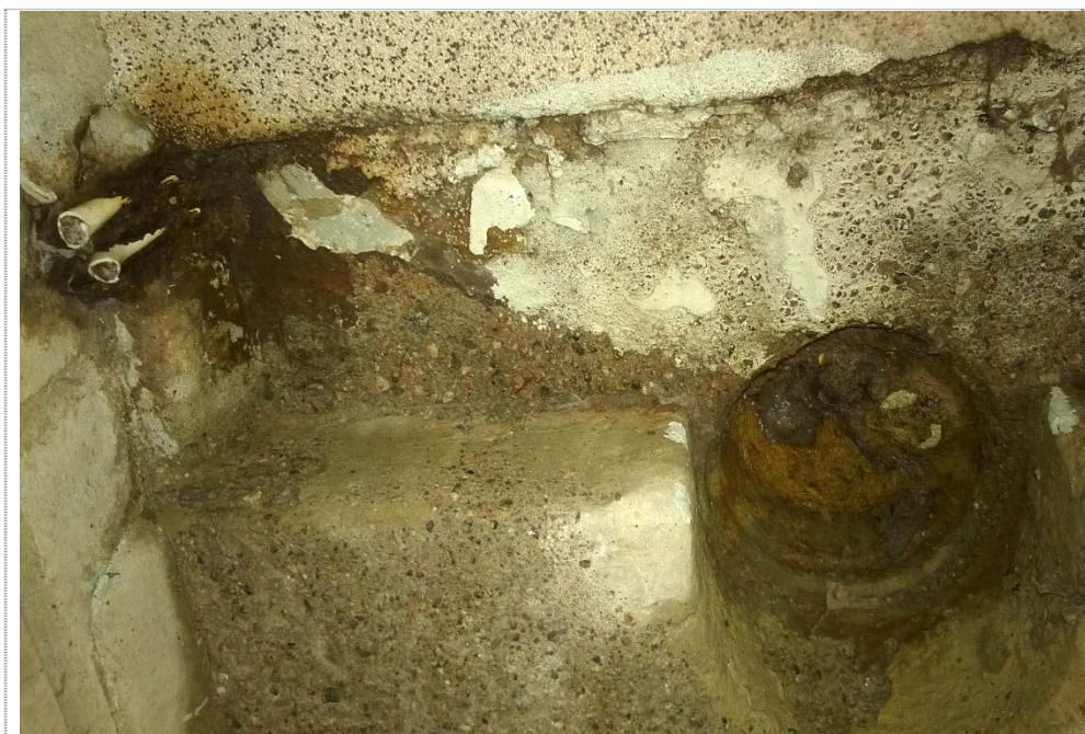
Kuva 9.: Lattiakaivo uima-allaslaitetilassa.
