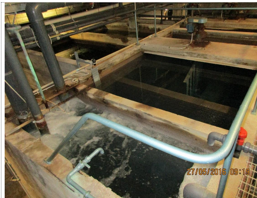
Kuva 13. Saostus- ja suodatintaitaita
