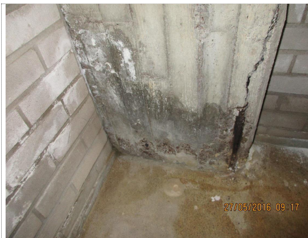
Kuva 11. Vaurioita betonipilarissa
