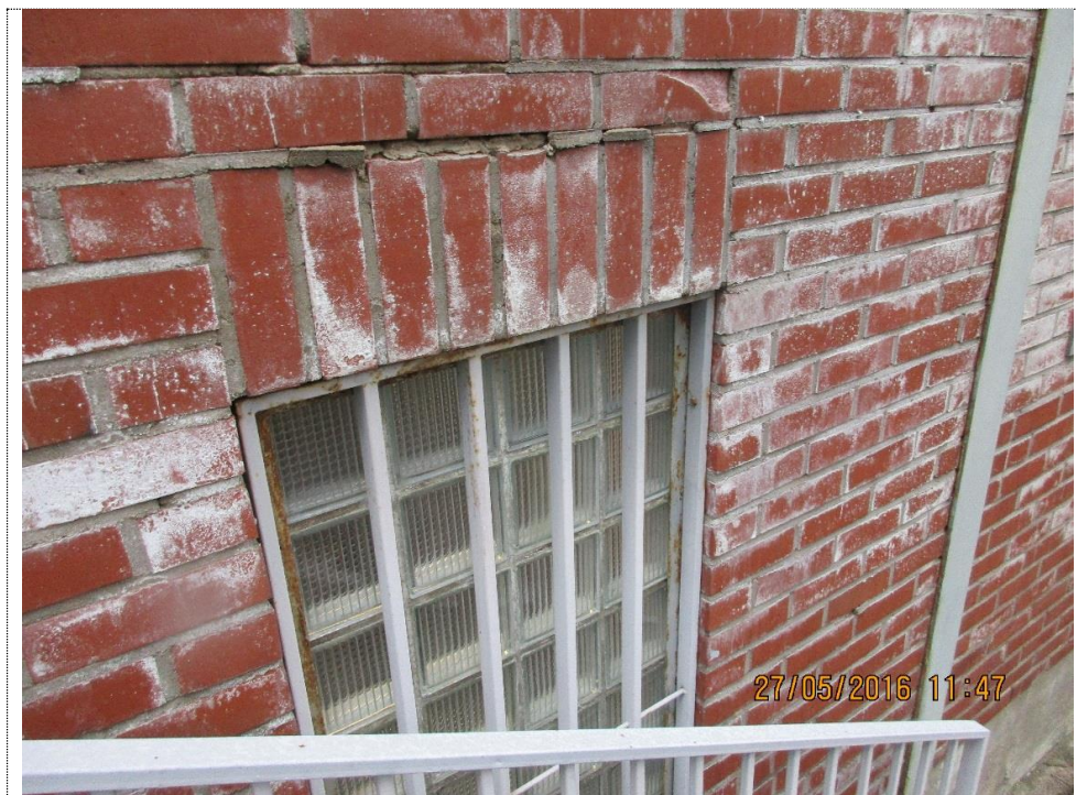
Kuva 16. Tiilipinta ja laastisaumat ovat rapautuneet
