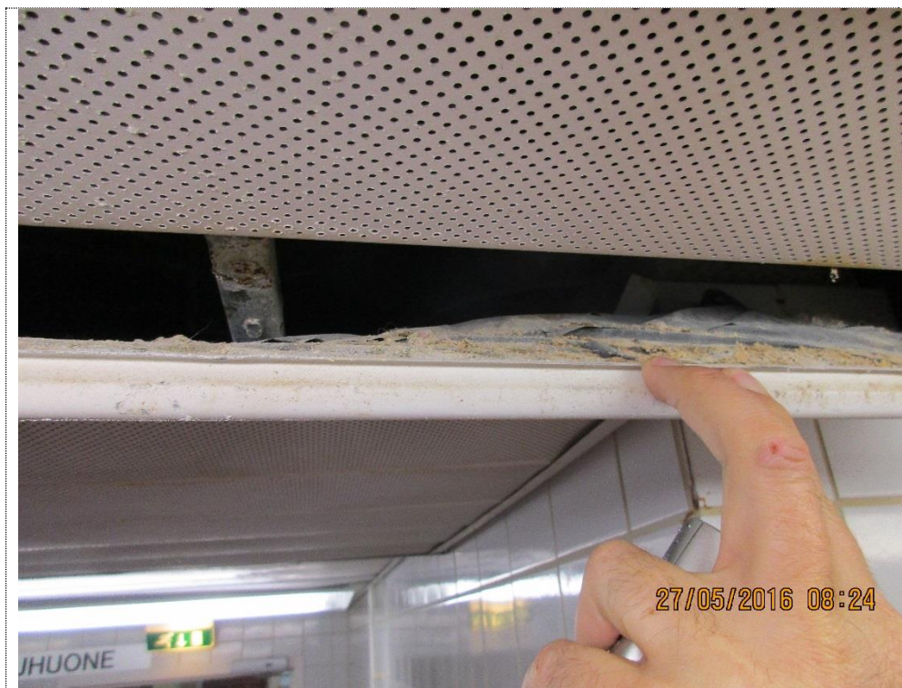
Kuva 20. Mineraalivillaa pesuhuoneen sälekaton päällä
