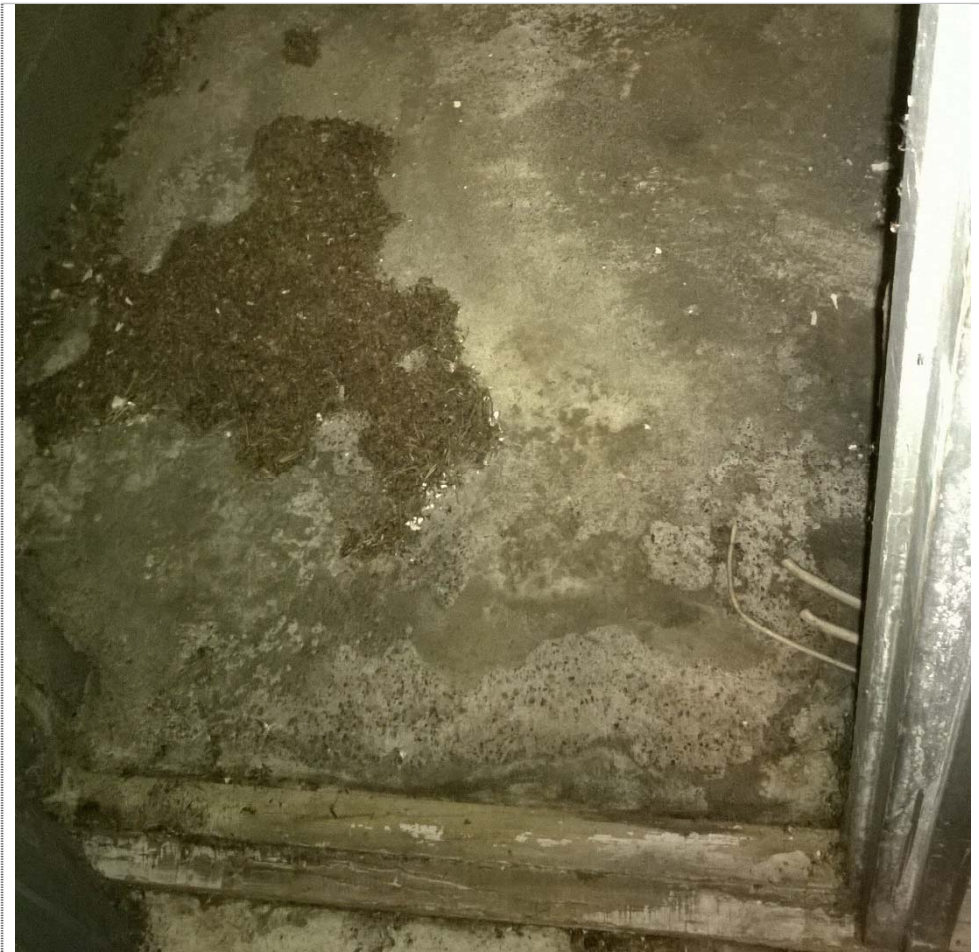
Kuva 16.: Raitisilmakammion ovenkarmi ja lattiaa.
