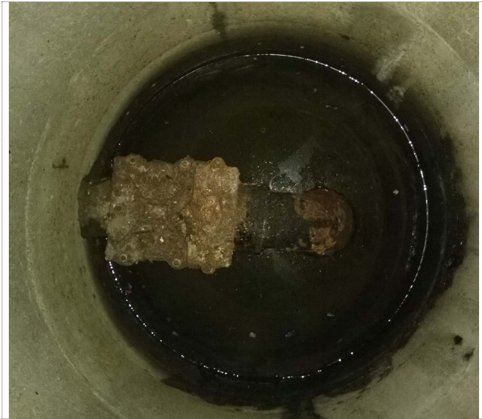
Kuva 12.: Perusvesikaivo lämmönjakohuoneen lattiassa.
