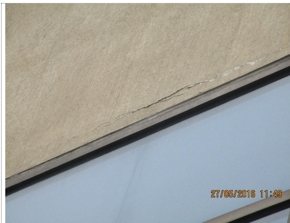
Kuva 14. Vaurioita seinäelementissä
