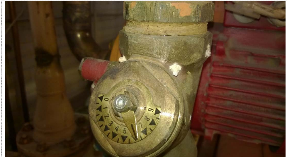
Kuva 5.: Vanha säätöventtiili, jossa säätöarvo aseteltuna.
