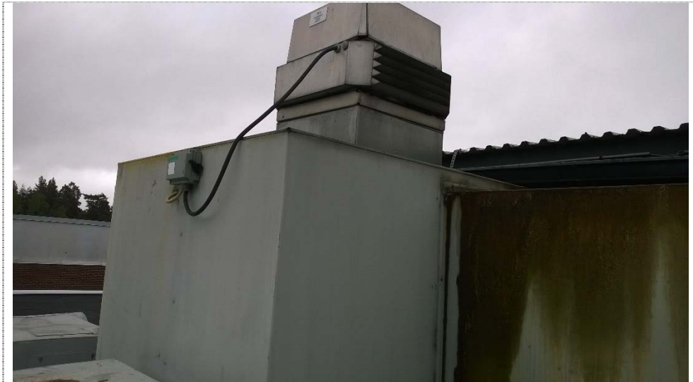
Kuva 22.: PK3 ja turvakytkin.
