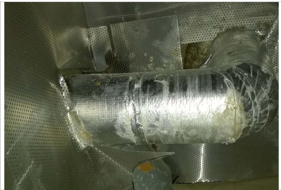
Kuva 17.: Raitisilmakammion reikäpeltiseinää ja näkyviä villapintoja.
