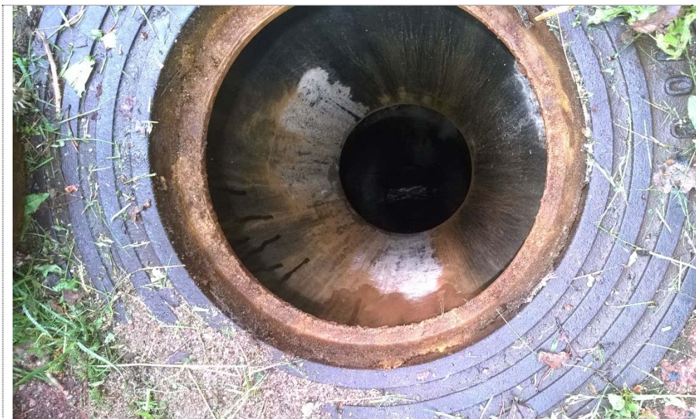
Kuva 13.: Uusittu jätevesikaivo pihamaalla.
