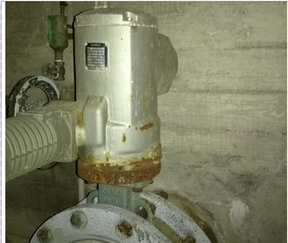
Kuva 25.: Hiekkasuodattimen huuhteluventtiili.
