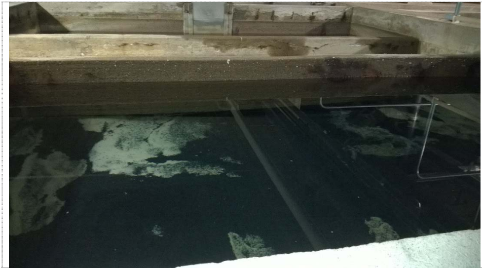
Kuva 24.: Hiekkasuotimet (iso allas).
