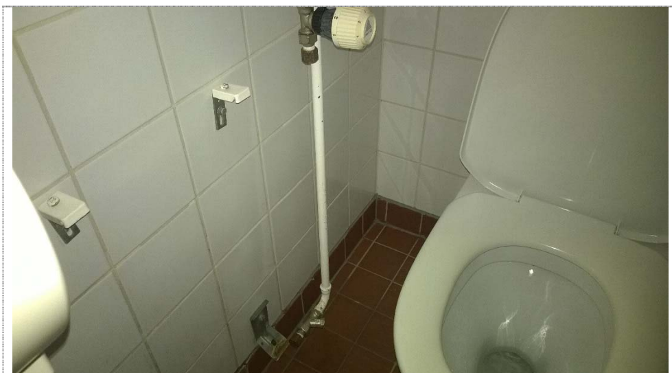
Kuva 7.: Patteriventtiili mallia Danfoss vuodelta 1995. Patteri on irti, venttiili tiputtaa.
