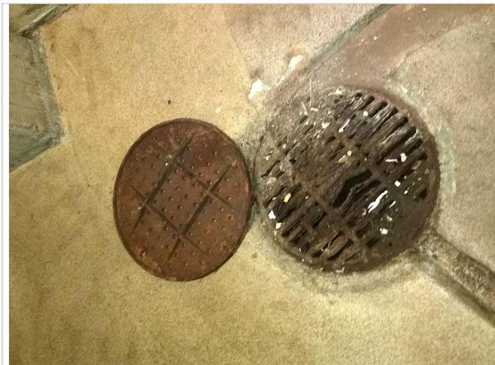
Kuva 11.: Lattiakaivo uima-allaslaitetilassa.
