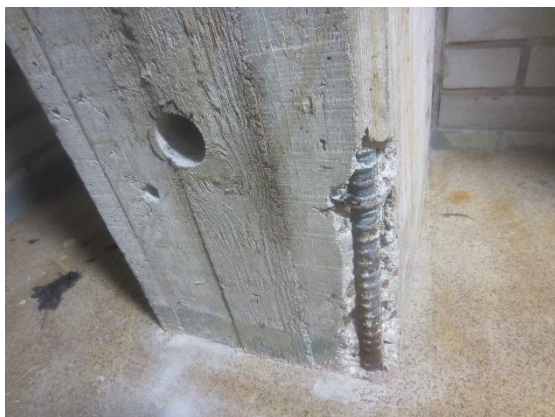
Kuva 3 Ruostuneita pilariteräksiä.
