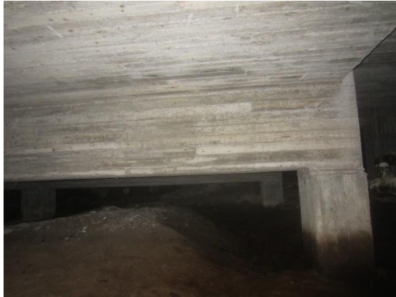
Kuva 11 Pilareiden pinnat olivat veden alla olevia alaosa lukuunottamatta kuivia.
