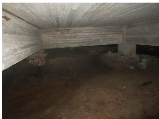
Kuva 7 Rakennuksen reunoilla alapohjatila on matalampi.
