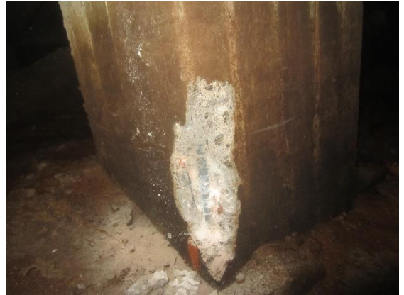
Kuva 16 Pilareiden teräksissä ei todettu korroosiota.
