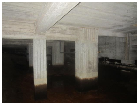
Kuva 8 Rakennuksen keskialueilla alapohjatila on yli 2 m korkea.
