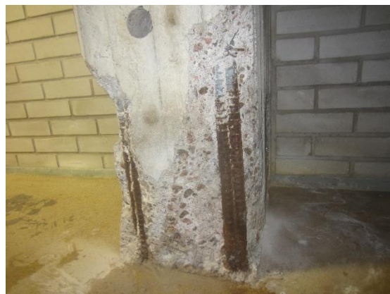
Kuva 4 Ruostuneita pilariteräksiä.
