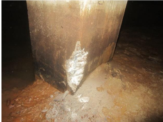
Kuva 15 Pilareiden teräkset olivat hyvässä kunnossa.
