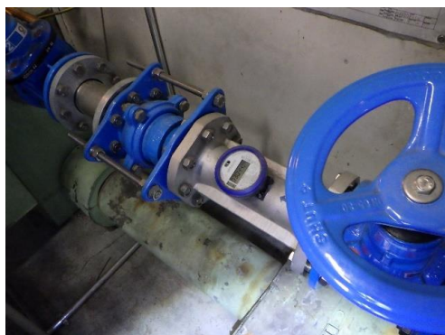
Kuva 81. Vesimittari
