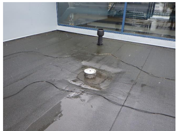
Kuva 31. Vesikatolla vedenpoistojärjestelmää
