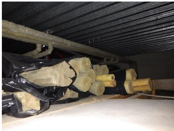
Kuva 94. Ilmanvaihtokanavia ja varastoituja putkieristeitä
