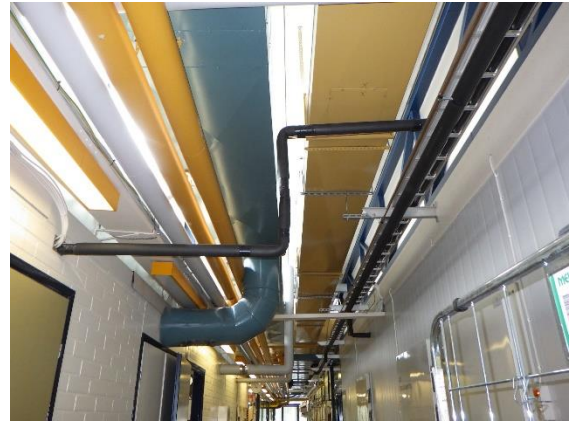
Kuva 93. Ilmanvaihtokanavia
