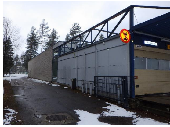
Kuva 17. Julkisivua vasemmalla sivulla
