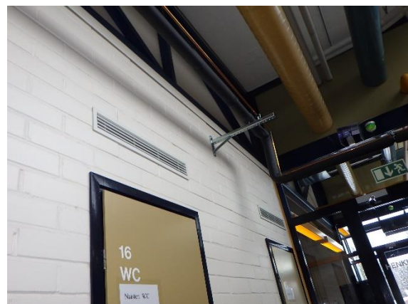
Kuva 97. Siirtoilmasäleikkö
