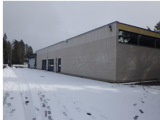
Kuva 19. Julkisivua oikealla sivulla
