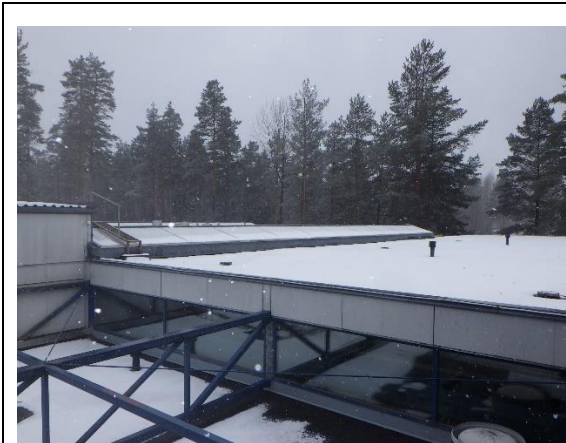
Kuva 26. Vesikaton ylempää tasoa
