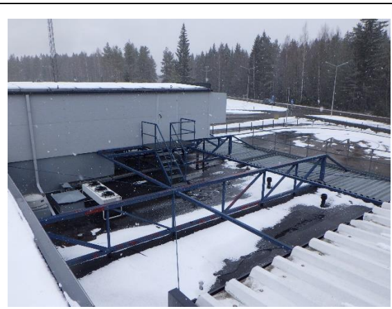
Kuva 25. Vesikaton alempaa tasoa
