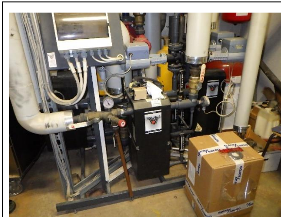
Kuva 75. Lämmönjakokeskus
