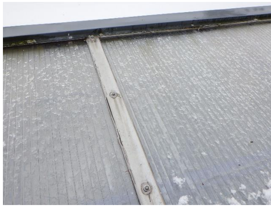
Kuva 44. Kattoikkunan massat ovat ikääntyneet
