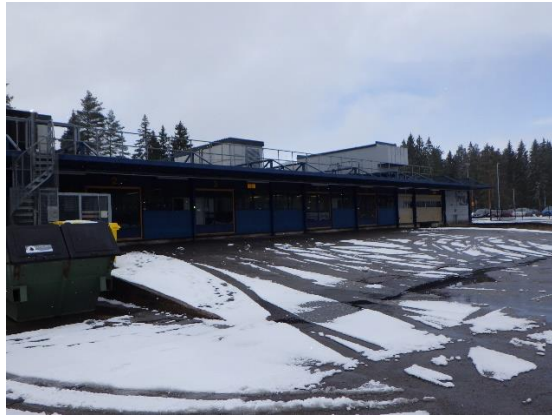
Kuva 16. Julkisivua kadun puolella
