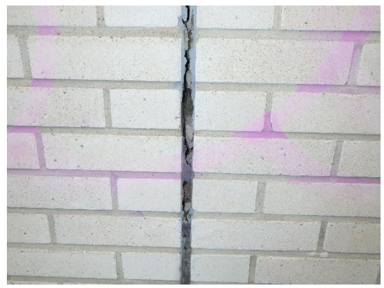
Kuva 21. Liikuntasäura on ikääntynyt ja avoin
