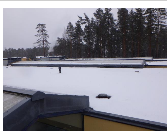
Kuva 27. Vesikaton ylempää tasoa
