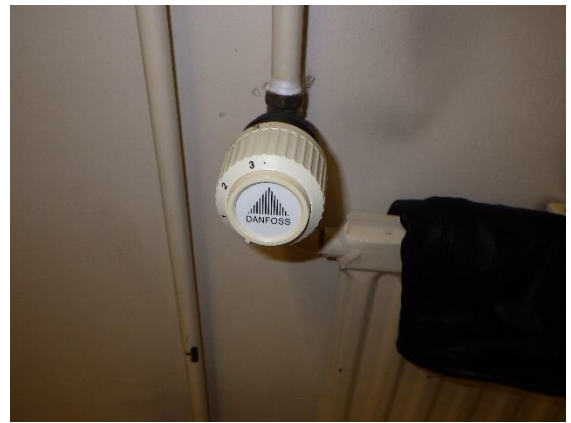
Kuva 78. Termostaattiventtiili
