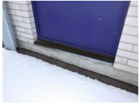
Kuva 47. Vesipeltien kaltevuus on loiva
