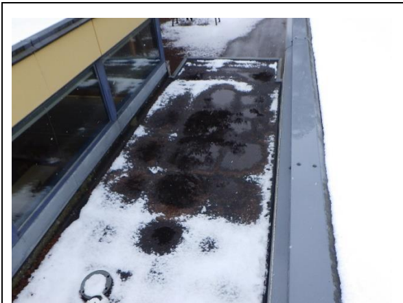
Kuva 28. Ruokalan ns. käytävän vesikattoa
