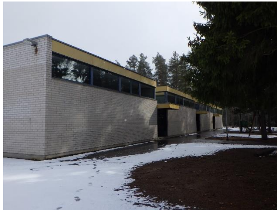
Kuva 18. Julkisivua ruokalan puolella
