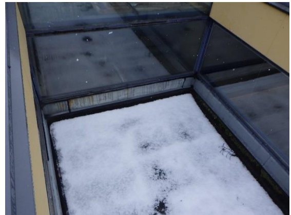
Kuva 29. Ruokalan ns. käytävän vesikattoa
