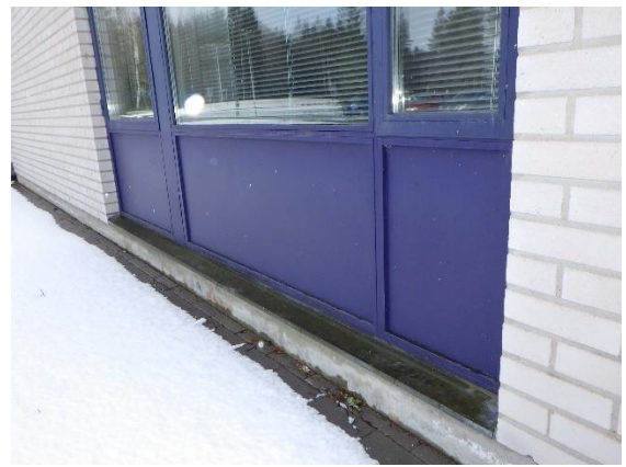
Kuva 41. Vesipeltien kaltevuus on loiva
