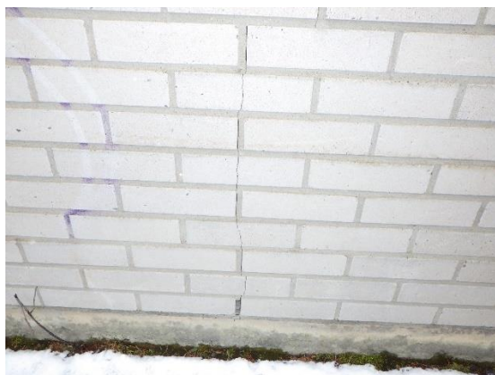
Kuva 20. Halkeama tiiliverhouksessa
