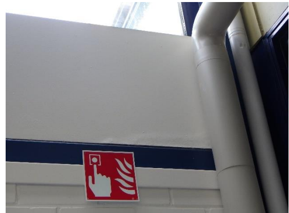
Kuva 23. Kosteusjälkiä ulkoseinän levyrakenteissa ruokalan ns. katoksen päädyssä ulkoseinän levyrakenteissa
