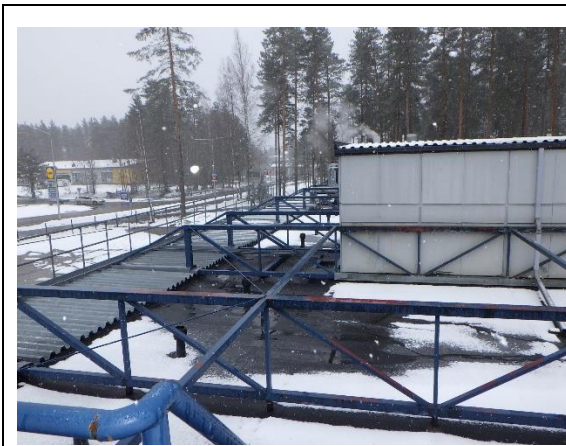
Kuva 24. Vesikaton alempaa tasoa
