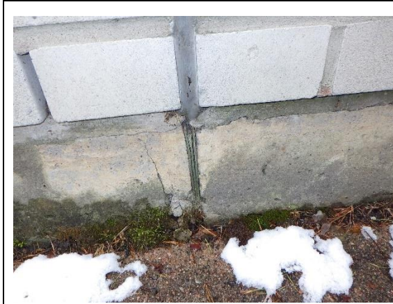
Kuva 10. Liikuntasauva sokkelissa
