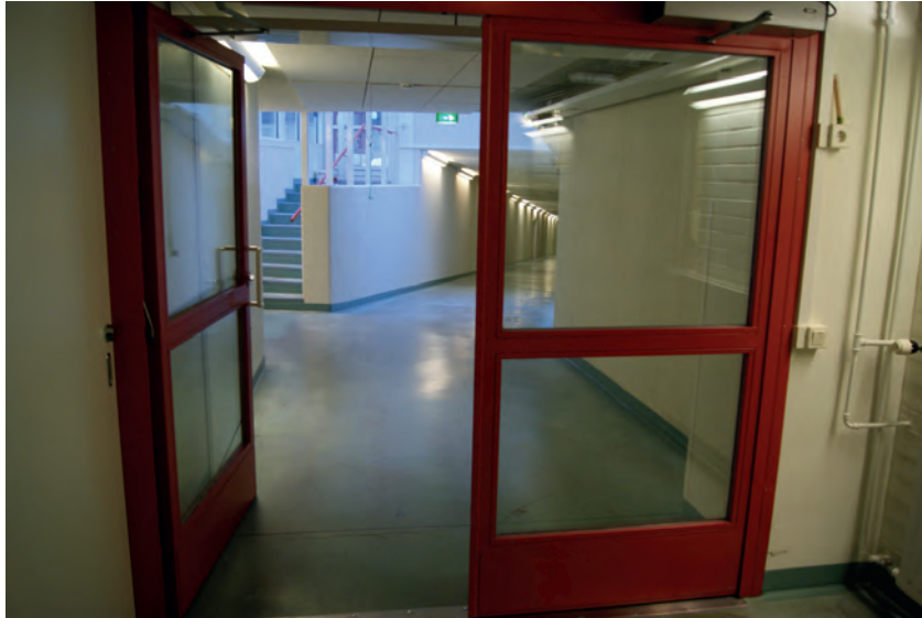
Yhdystunneli porrashuoneesta kellarikerroksesta terveyskeskukseen ja palveluasuntorakennuksiin. Kari Mustonen, 27.1.2022.
