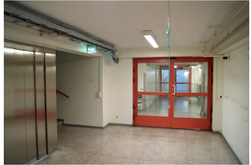
Pohjoispuolen porrashuoneesta kellarikerroksesta. Kari Mustonen, 27.1.2022.
