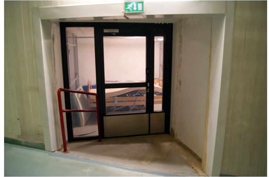
Yhdystunnelista liittymä Marjoniemen palveluasuntorakennukseen (vaihe 2). Kari Mustonen, 27.1.2022.
