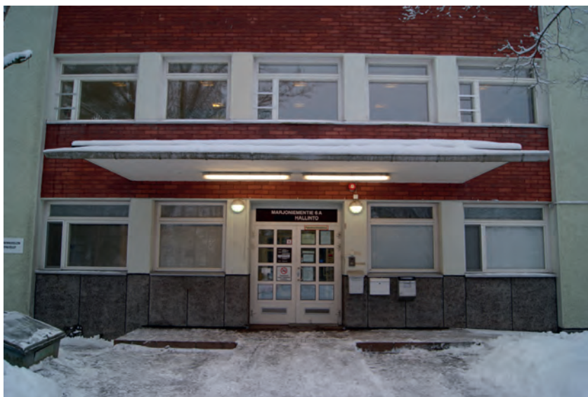
Näkymä sotilassairaala 3, pääsisäänkäynnistä, ovet on uusittu, kuva pohjoisesta päin. Kari Mustonen, 27.1.2022.
