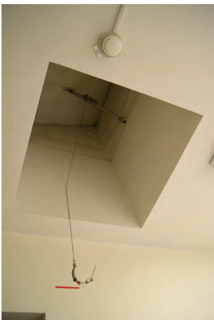
Nykyisen porrashuoneen savunpoistoluukku ullakkokerroksessa. Kari Mustonen, 27.1.2022.
