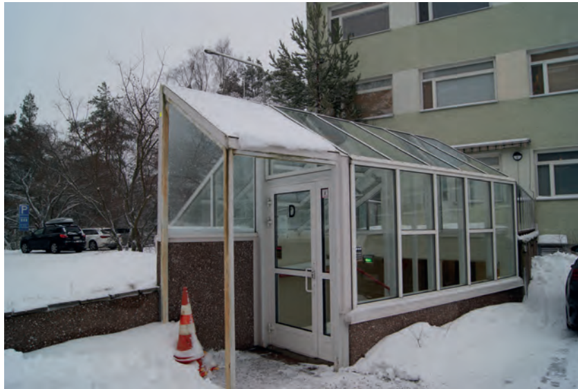
Näkymä sotilassairaala 3, yhdyntunnelin poistumistierakennelmästä, jonka takana on tasorakenelma kaiteineen. Kari Mustonen, 27.1.2022.
