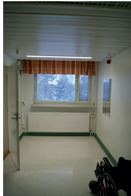
Nykyisen 3. kerroksen itäpuolen käytävä pohjois- päädyn ikkuna. Kari Mustonen, 27.1.2022.
