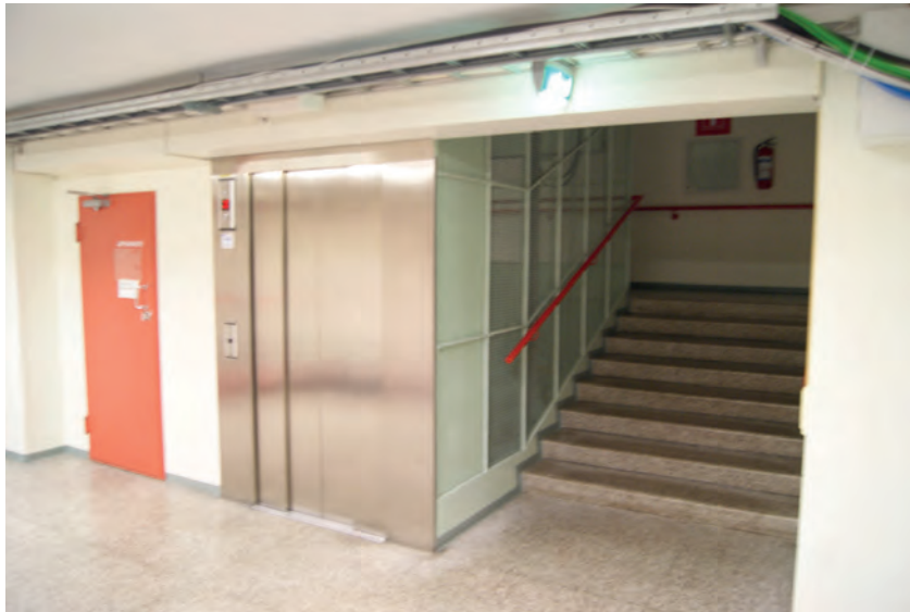
Näkymä pohjoispuolen porrashuoneesta kellarikerroksesta. Kari Mustonen, 27.1.2022.
