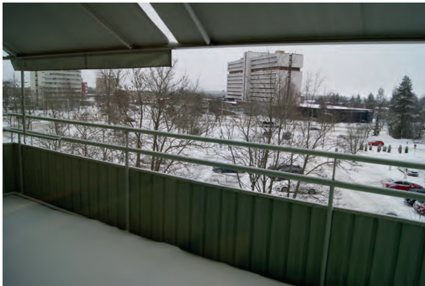
Nykyisen 3. kerroksen eteläpään parveke ja näkymä pohjolatalle. Kari Mustonen, 27.1.2022.
