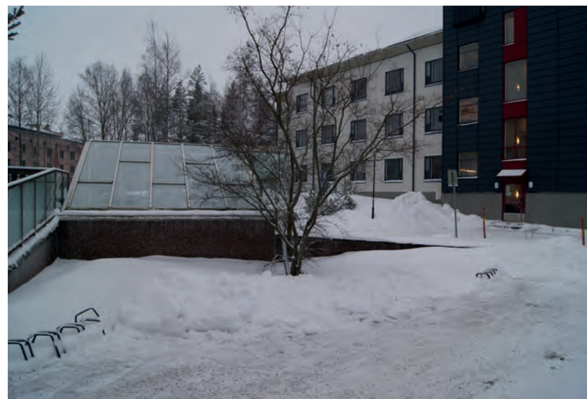
Näkymä sotilassairaala 3, esteettömän käynnin rampin vieressä olevasta yhdistyksen poistumistierakennelman lasikatosta, kuva pohjoisesta päin. Kari Mustonen, 27.1.2022.
