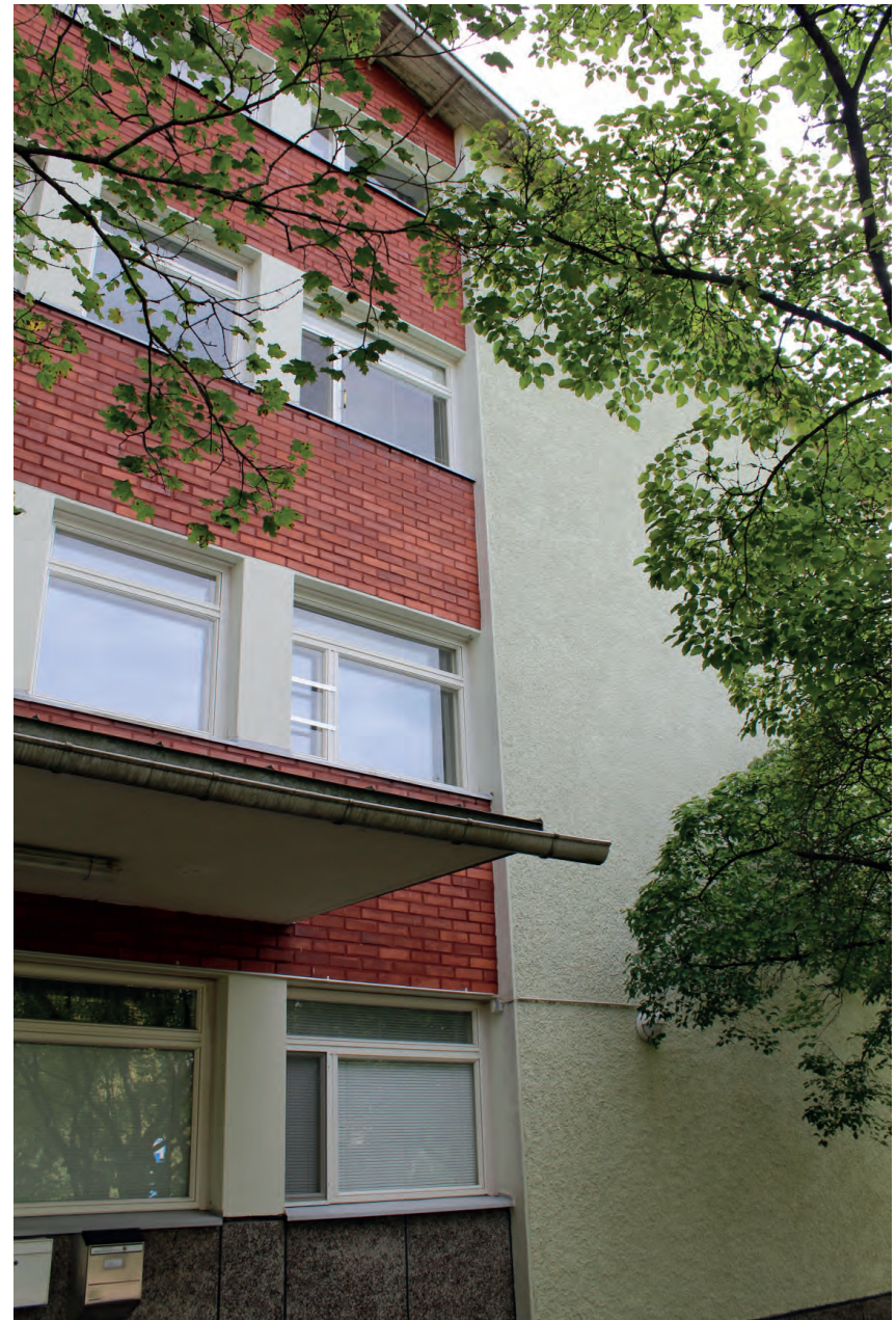
Näkymä sotilassairaala 3, pohjoispäädyn pääsisäänkäynnin katoksesta. Valokuva: Kaisa Niilo-Rämä, 30.8.2021.
