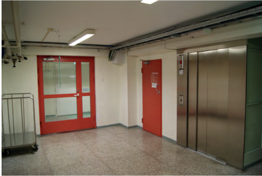
Näkymä pohjoispuolen porrashuoneesta kellarikerroksesta. Kari Mustonen, 27.1.2022.
