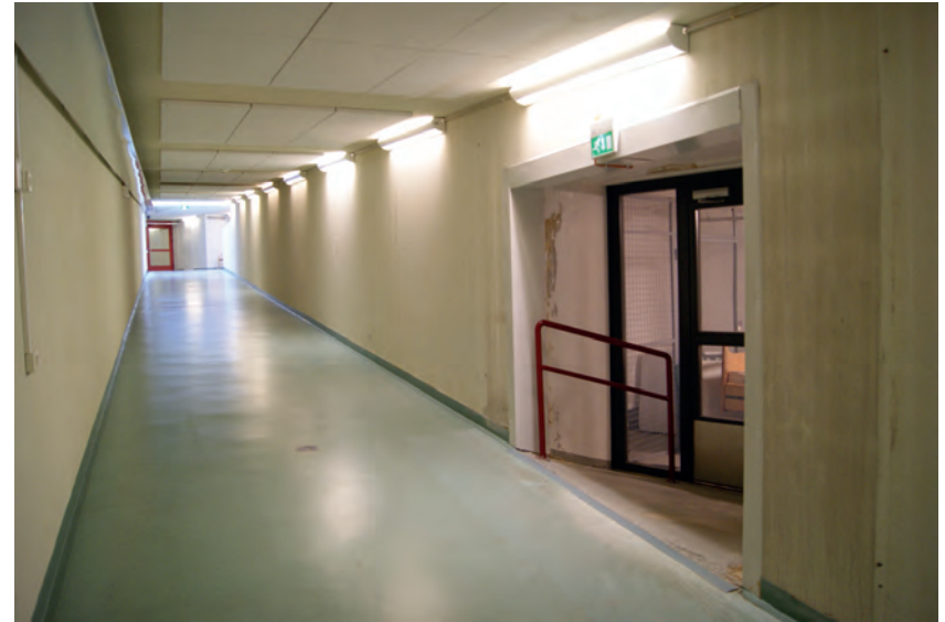
Yhdystunnelista liittymä Marjoniemen palveluasuntorakennukseen (vaihe 2) ja yhdyskäytävä sotilassairaala 3 suuntaan. Kari Mustonen, 27.1.2022.
