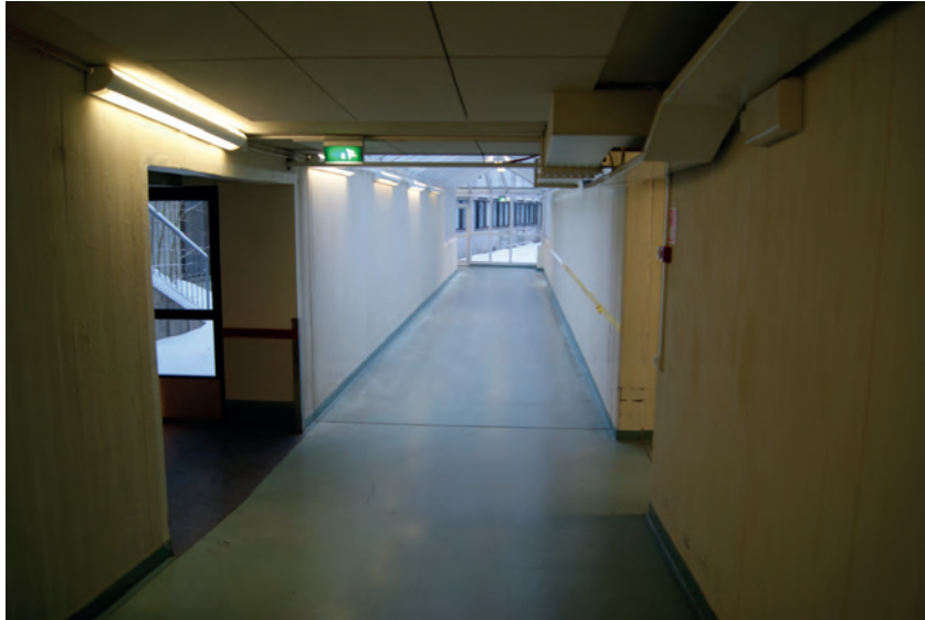
Yhdystunnelista liittymä Marjoniemen palveluasuntorakennukseen (vaihe 1) vasemmalla, taustalla ja oikealla terveystakeskukseen. Kari Mustonen, 27.1.2022.
