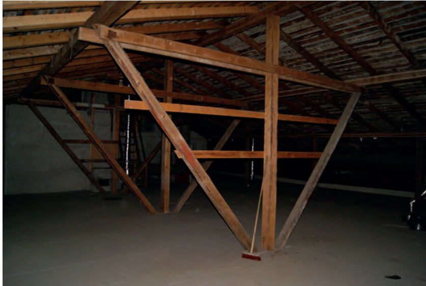
Nykyisen kylmäullakkotilan vesikaton tukirakenteita ja IV-asennuksia. Kari Mustonen, 27.1.2022.
