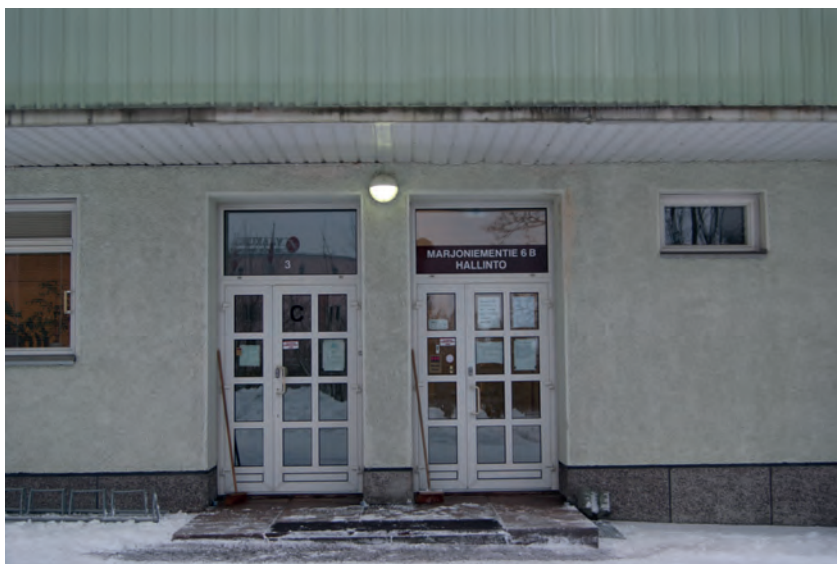
Näkymä sotilassairaala 3, ovi vasemmalla on alkuperäinen ja nykyinen kellarin poistumistie-/yhteysreitistä. Ovi oikealla, alkuperäisen käyttötarkoituksen mukaisesta keittiön huoltosisäänkäynnistä ja nykyisestä hallinnon yhteydestä. Ovet yläikkunoineen ovat uusittu. Kari Mustonen, 27.1.2022.
