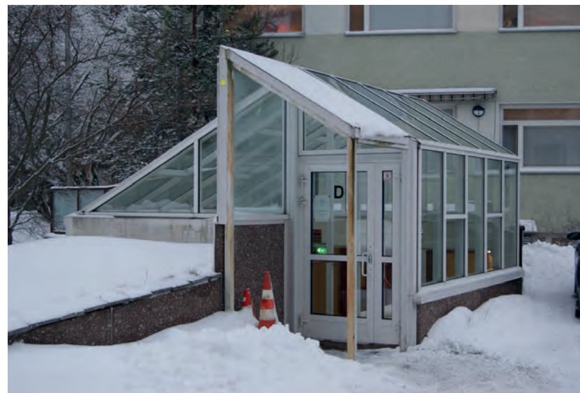
Näkymä sotilassairaala 3, yhdystunnelin poistumistierakennelmästä. Kari Mustonen, 27.1.2022.
