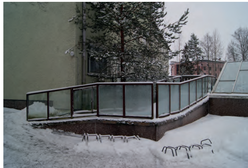
Näkymä sotilassairaala 3, esteettömän käynnin ramppi nykyiselle ulkotasolle, kuva pohjoisesta päin. Kari Mustonen, 27.1.2022.
