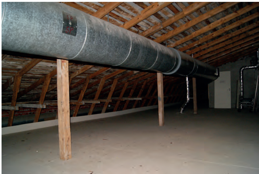
Nykyisen kylmäullakkotilan vesikaton tukirakenteita ja IV-asennuksia. Kari Mustonen, 27.1.2022.
