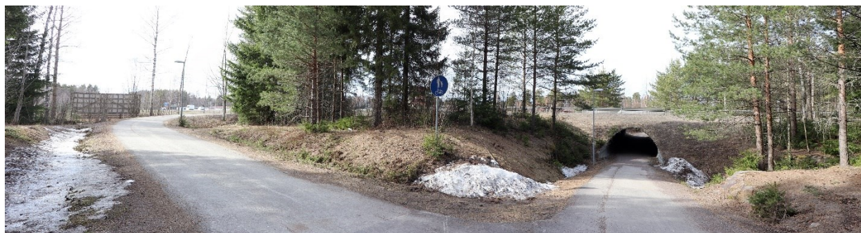
Kuva 13. Valtatie 15 alittavan tunnelin yhteyteen on sijoitettu joukkoliikenteen pysäkkipari. Näkymä Lautaron suunnasta.
