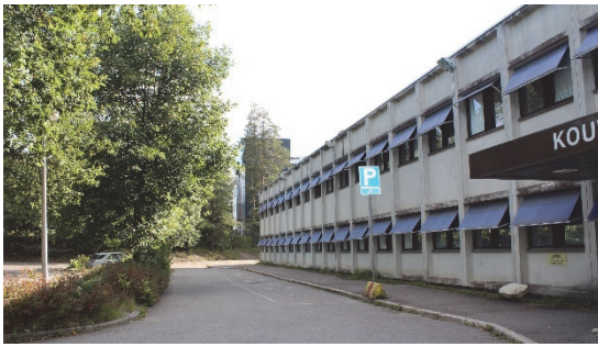
Kuva 6. Marjoniemen terveyskeskuksen Marjoniementien puoleinen julkisivu.
