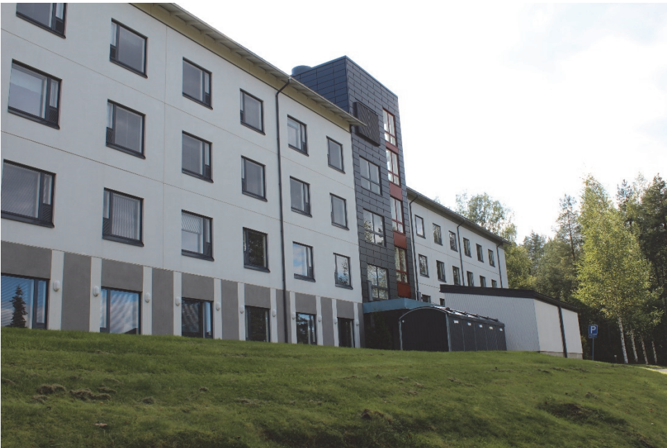
Kuva 12. Näkymä suunnittelualueen keskiosasta kohti palveluasuntojen pohjoista julkisivua.
