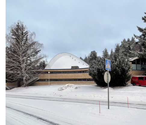
Vanhan uimahallin eteläjulkisivun nauhaikkunoita ei tulisi muuttaa.
