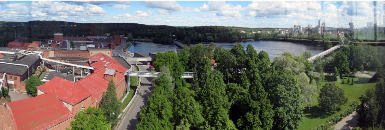
Kuva 3. Näkymä Patosillan tien ja Kyminväylän väliselle Gösta Björkenheimin puistikoksi nimetylle alueelle, jonka keskeltä pilkistää johtokunnan huvila.
