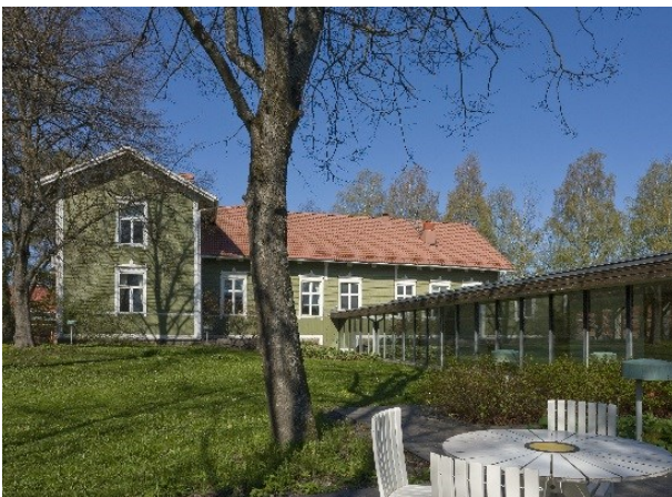
Kuva 7. Johtokunnan huvila Theodor Decker 1873, muutokset Valter Thomé 1908. Kuvassa oikeassa reunassa olevan laajennusosan on suunnitellut Bertel Gripenberg 1970.
