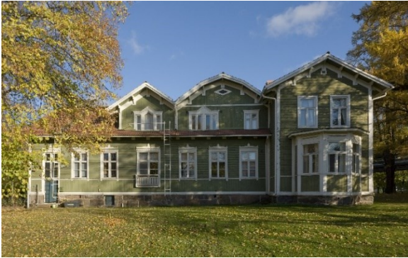
Kuva 16. Johtokunnan huvila lännestä Patosillantieltä. Johtokunnan huvilan ensimmäisessä kerroksessa on nykyisin ravintola- ja kokoustiloja ja toisessa kerroksessa majoitustiloja.
