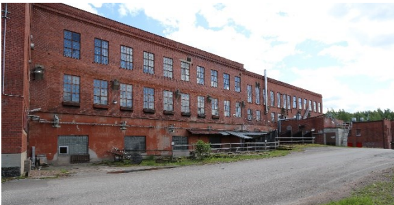
Kuva 23. Vanha hiomo ja korjaamo Minttonintieltä katsottuna.
