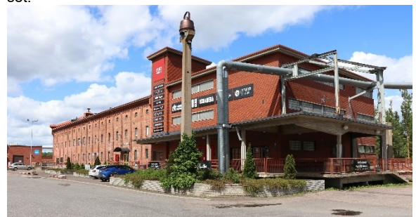
Kuva 15. Vanha keskusvarasto 1890 ja laajennus 1960, Arne Helander.
