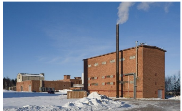
Kuva 13. Nykyinen KSS Lämpö Oy:n lämpökeskus, entinen haihuttamo, 1956, Arne Helander.
