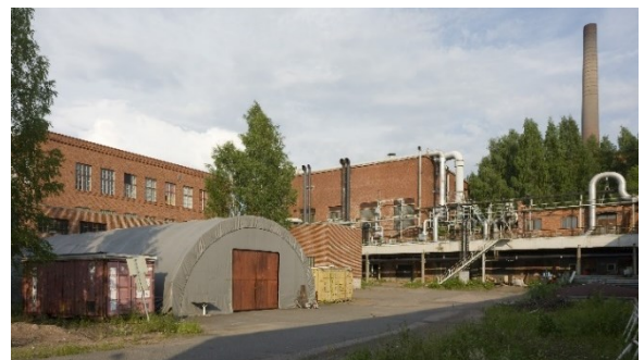
Kuva 14. Konekorjaamo, taustalla vaihdinaseman rakennukset.
