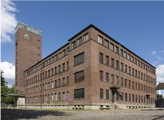
Kuva 17. Pääkonttori Patosillantien suunnalta. Rakennuksen kattokerros laajennettiin vuonna 1954. Rakennuksen
